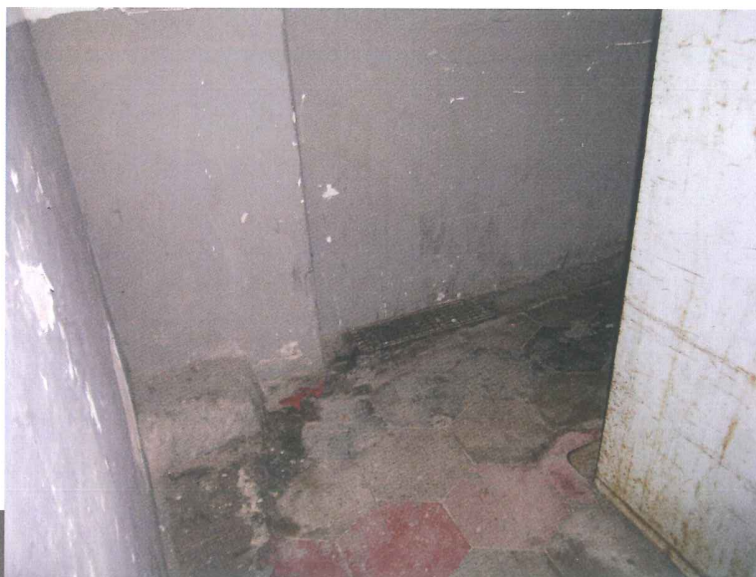
Pavimentazione vano scala di collegamento alle unità
