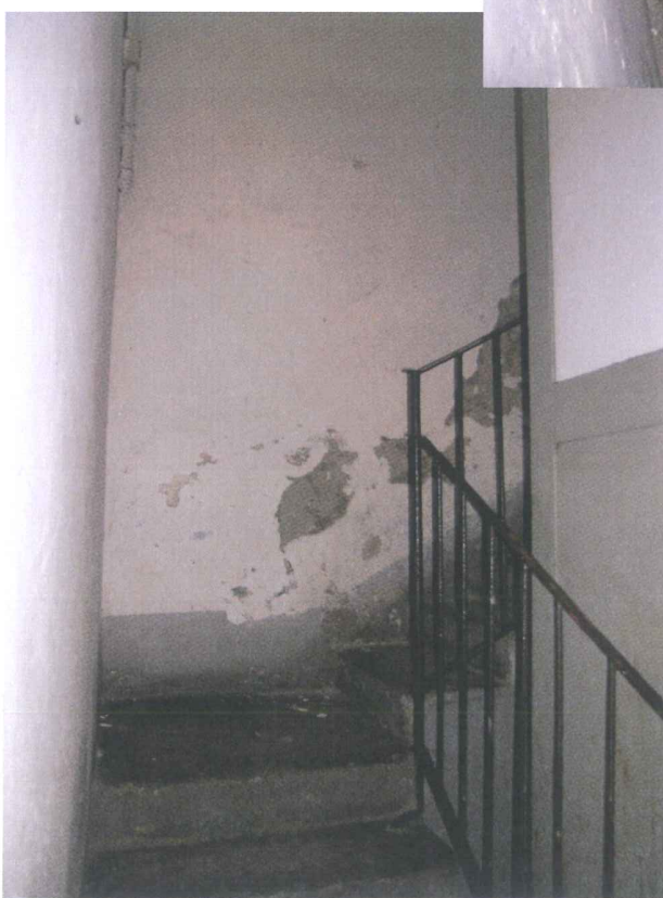
Vano scala edificio
