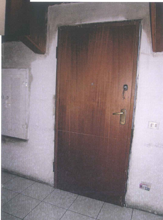
Porta d'ingresso dall'interno dell'unità immobiliare
