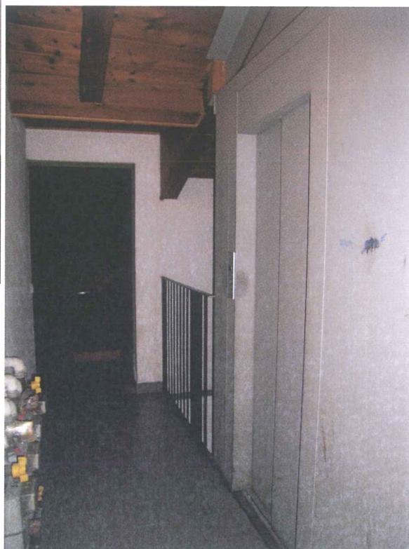
Ballatoio sbarco scala/ascensore piano sottotetto
