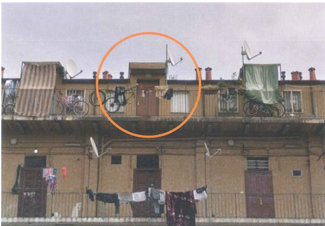
Accesso all'immobile dal ballatoio
