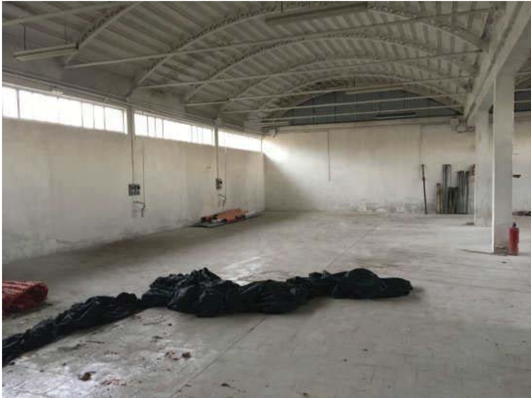
Foto n.8: Area Principale adibita a Deposito Materiali – Laboratorio Artigianale.
