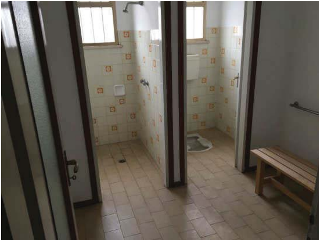
Foto n.15: W.C. - Corpo Uffici/Servizi.
