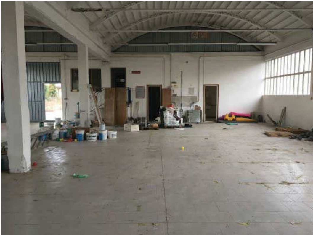
Foto n.7: Area Principale adibita a Deposito Materiali – Laboratorio Artigianale.
