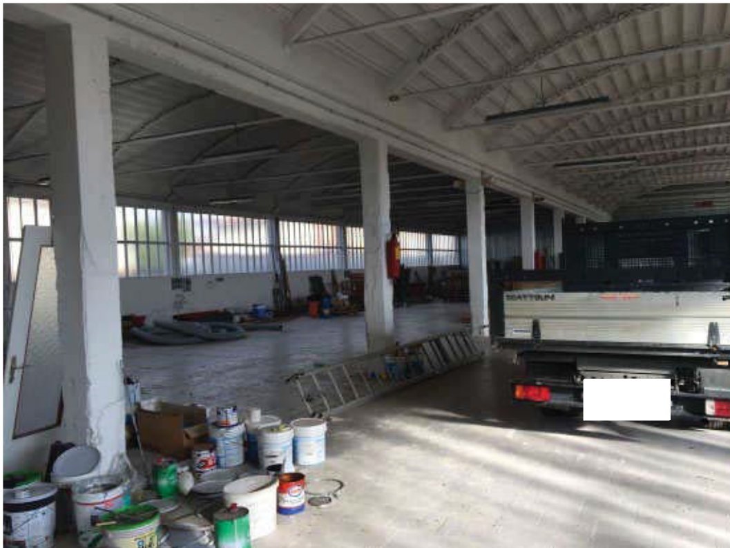
Foto n.10: Area Principale adibita a Deposito Materiali – Laboratorio Artigianale.
