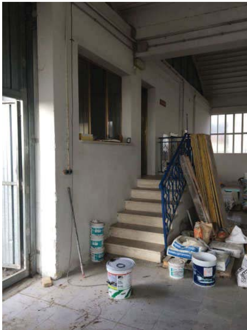
Foto n.12: Rampa di scale interna d'accesso al corpo Uffici/Servizi.
