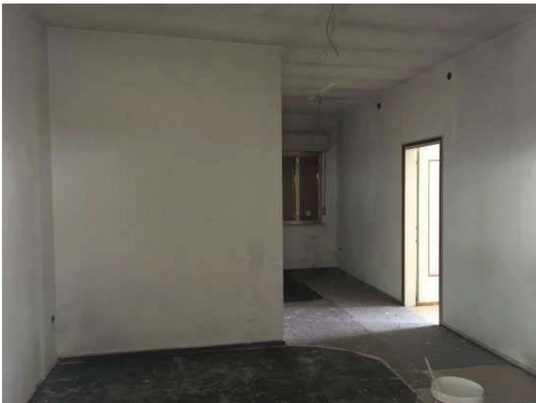
Foto n.16: Spogliatoi - Corpo Uffici/Servizi.
