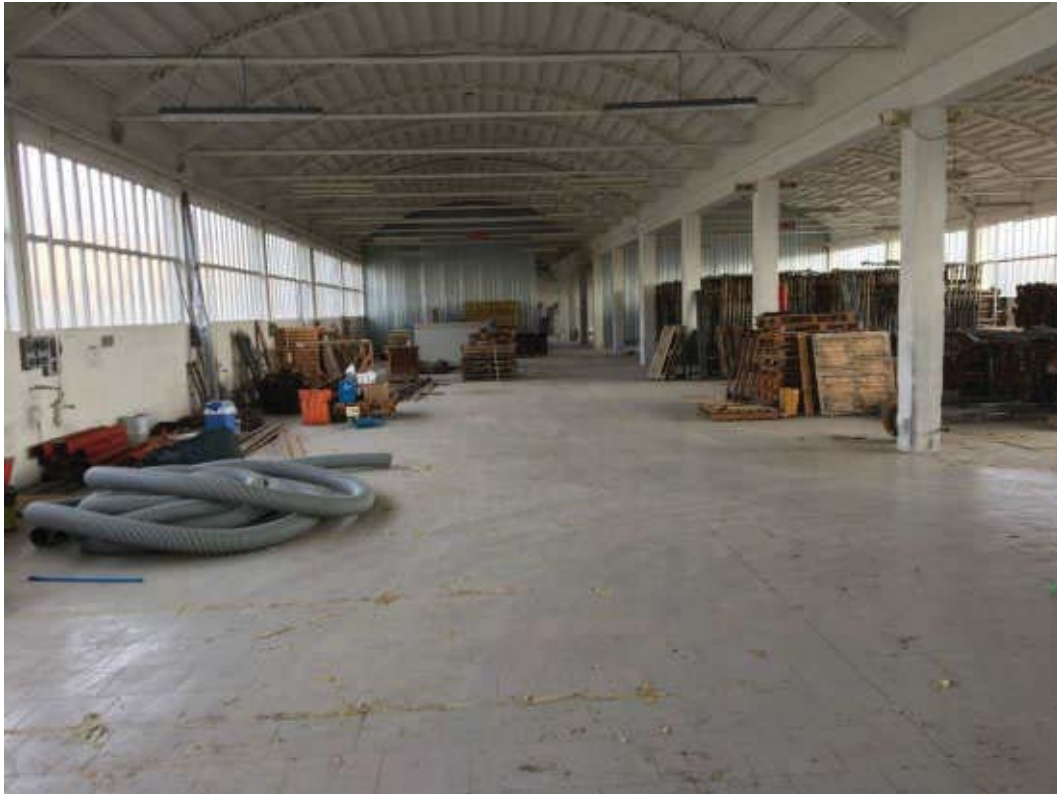
Foto n.11: Area Principale adibita a Deposito Materiali – Laboratorio Artigianale.
