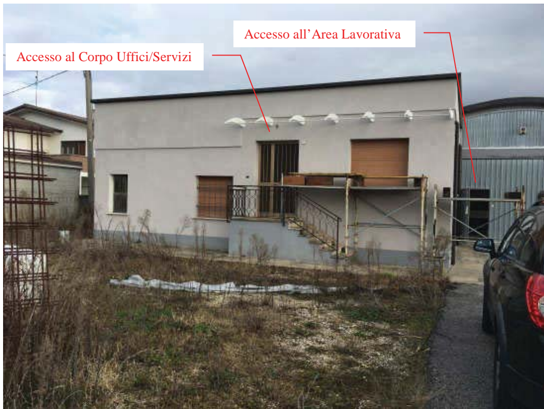
Foto n.5: Prospetto Ovest del Laboratorio Artigianale ( indicati gli accessi all'Area Lavorativa e al Corpo Uffici/Servizi ).
