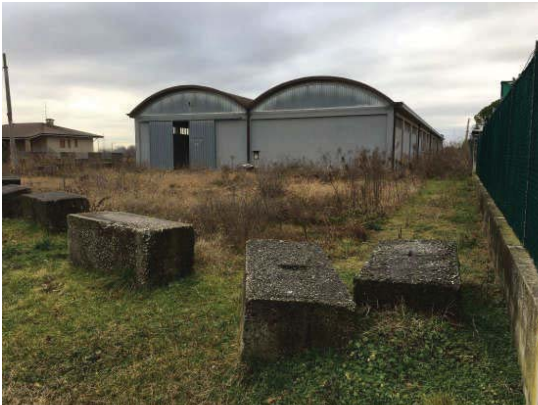
Foto n.3: Prospetti Nord ed Est del Laboratorio Artigianale visto dalla via pubblica Aussa.
