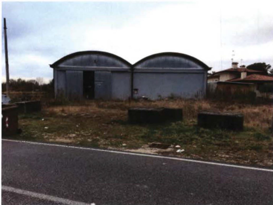
Foto n.2: Prospetto Est del Laboratorio Artigianale visto dalla via pubblica Aussa.
