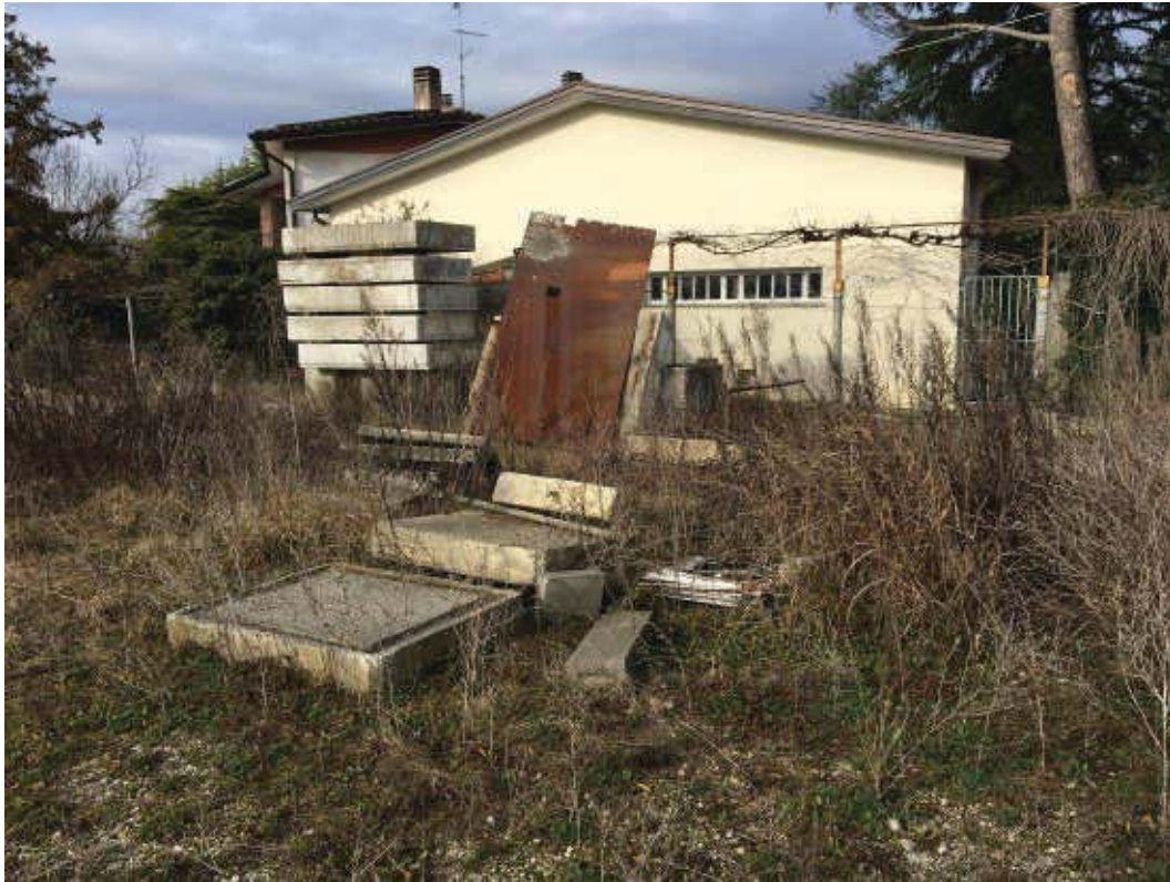
Foto n.19: Scoperto di pertinenza del Laboratorio Artigianale.
