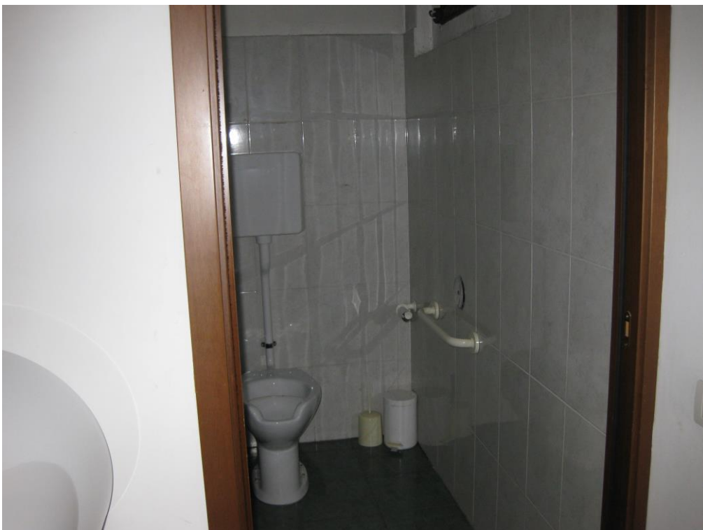
Vista del locale bagno.
