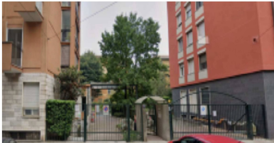
Foto n. 2 – Ingresso al condominio
