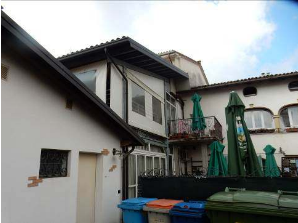
Foto 5-6: Fabbricato sub.3 lati Sud-Est e legnaia lato Sud.
