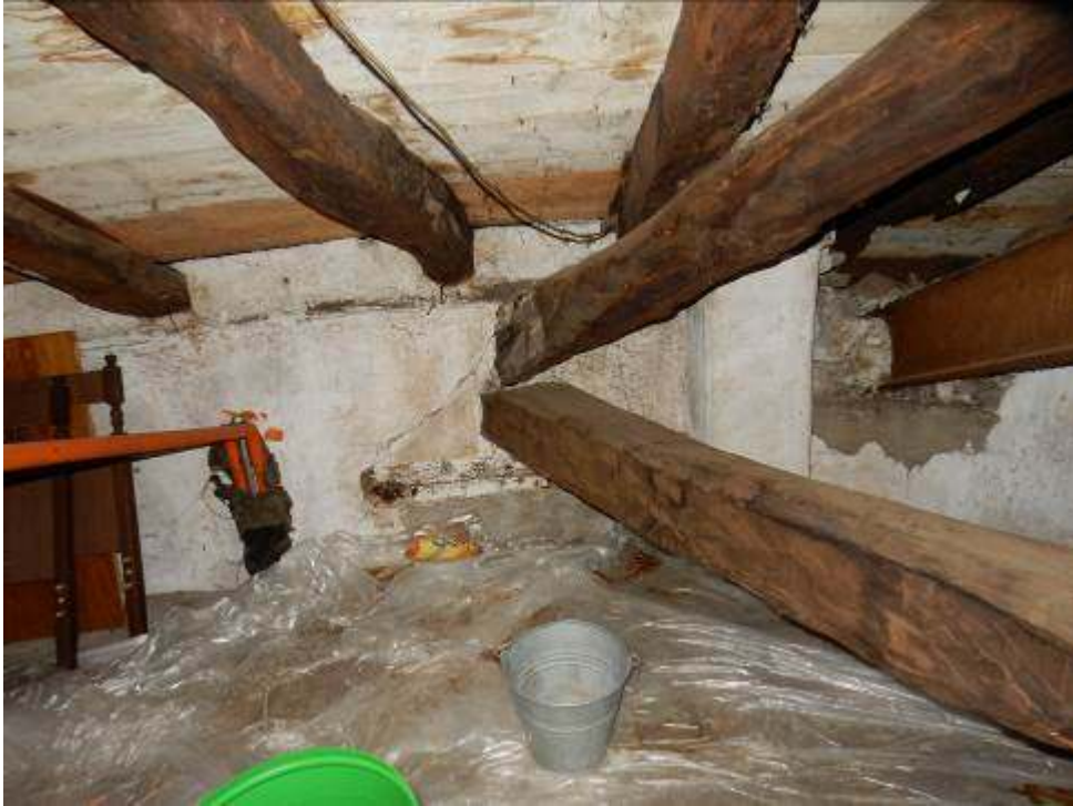
Foto 33-34: Fabbricato sub.3 – Sottotetto.
