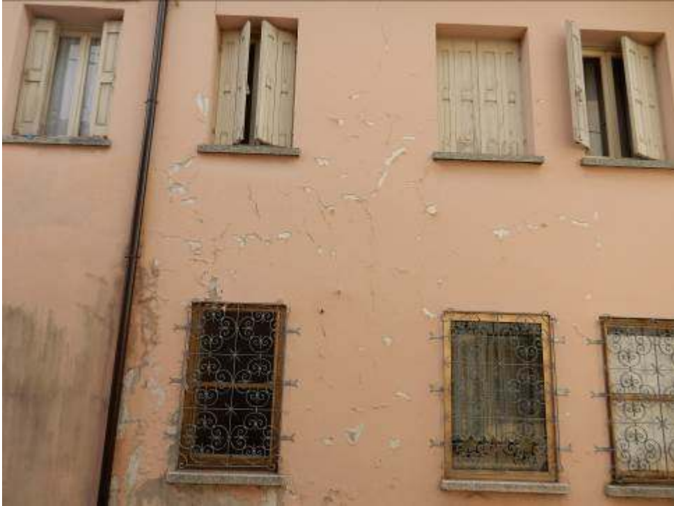
Foto 53-54: Fabbricato sub.4 – Facciata lato Nord e legnaia.
