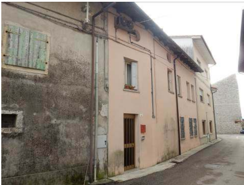
Foto 41-42: Fabbricato sub.4 lato Nord e Sud.
