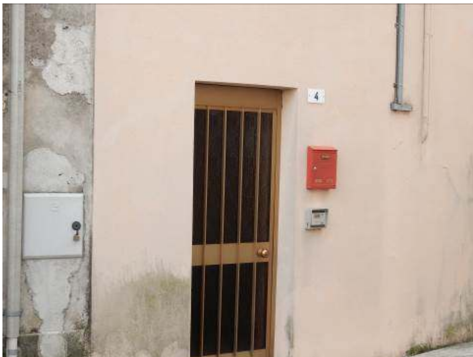
Foto 43-44: Fabbricato sub.4 – ingresso piano terra e vano scale.
