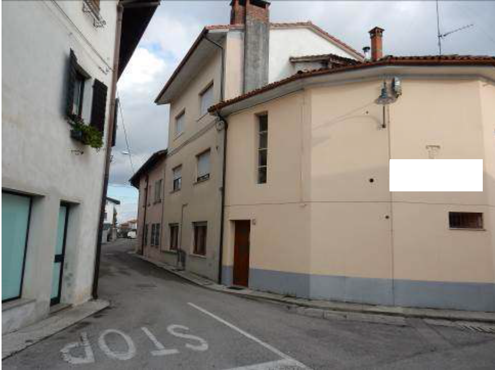
Foto 3-4: Fabbricato sub.3 lati Nord-Ovest e Est.
