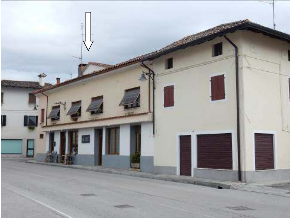
Foto 1-2: Fabbricato sub.3 lati Ovest e Nord-Ovest.
