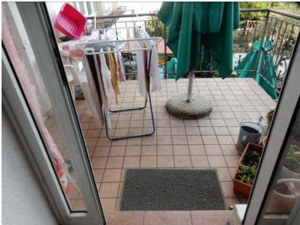
Foto 27-28: Fabbricato sub.3 – Terrazza e locali camere piano primo.
