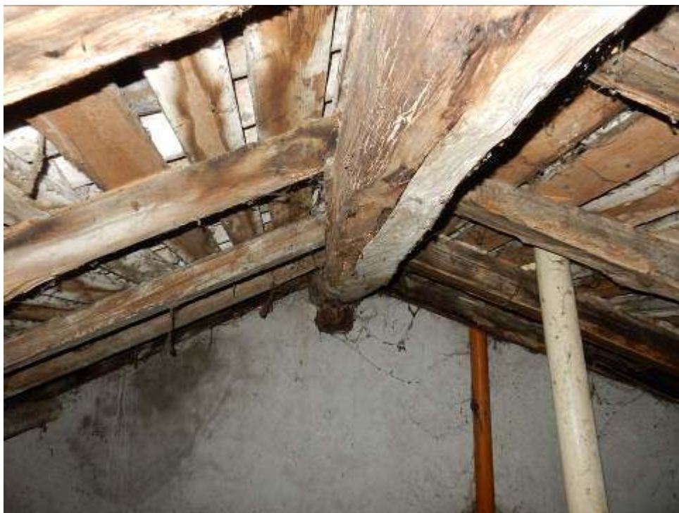
Foto 51-52: Fabbricato sub.4 – Sottotetto.
