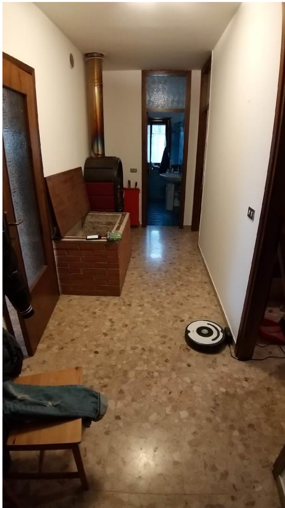
Foto n° 24 – Lotto 1 - Comune di Travesio (PN) – Foglio 20 m.le 87 sub 1 – Piano terra. Veduta, da posizione est, del secondo disimpegno di cui alla foto n°17. Sulla destra si nota parte dell'accesso a una delle tre camere. Sullo sfondo si osserva l'accesso al bagno del piano.
