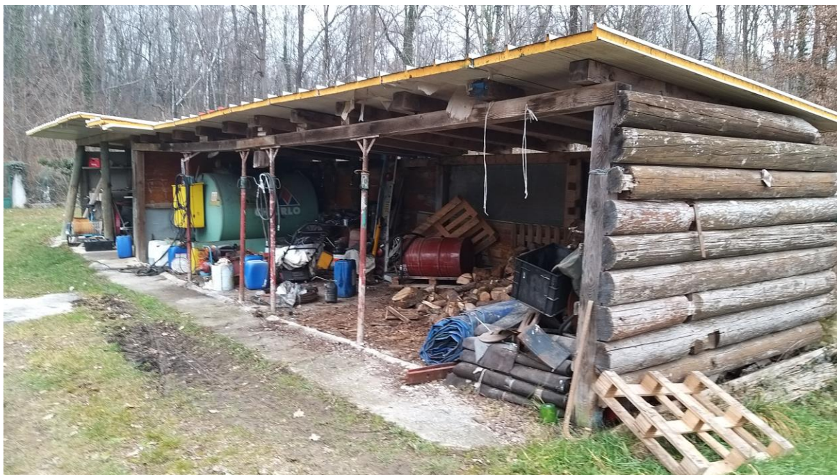
Foto n° 4 – Lotto 1 – Comune di Travesio (PN) – Foglio 20 m.le 87 – Veduta, da posizione sud e all'interno della proprietà, del manufatto abusivo destinato a deposito di materiali ed attrezzi.
