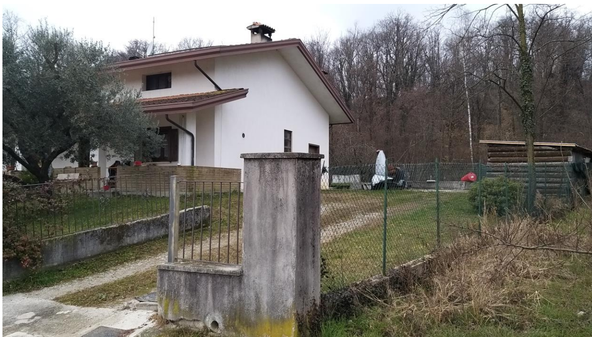
Foto n° 3 – Lotto 1 - Comune di Travesio (PN) – Foglio 20 m.le 87 – Veduta, da Via Magredi e da posizione sud-est, del terzo accesso all'area di pertinenza del fabbricato pignorato. Questa entrata al momento del sopralluogo risulta priva di cancello; a destra si nota parte del manufatto abusivo adibito a deposito materiali ed attrezzature.
