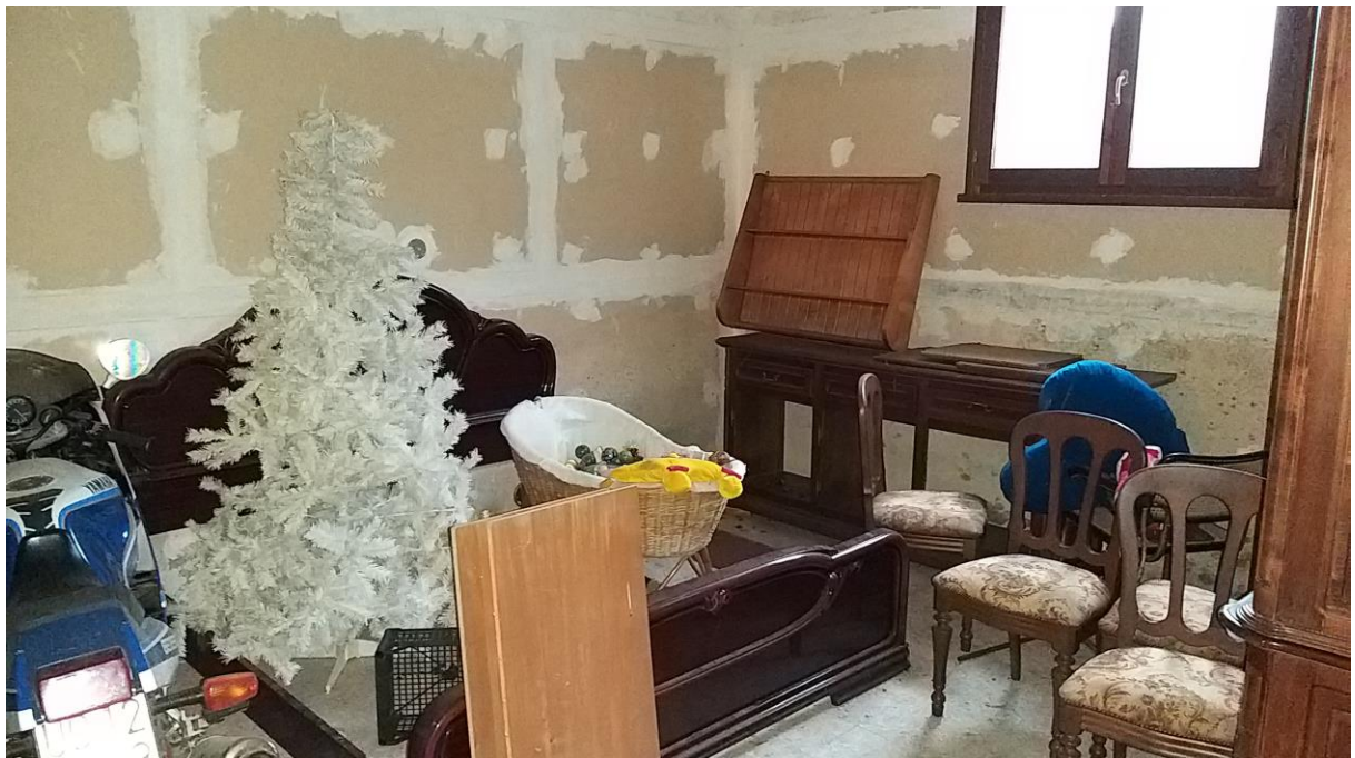
Foto n° 50 - Lotto 1 - Comune di Travesio (PN) - Foglio 20 m.le 87 sub 1 - Piano scantinato. Veduta della porzione sud-ovest del vano ad uso deposito di cui alla foto precedente.
