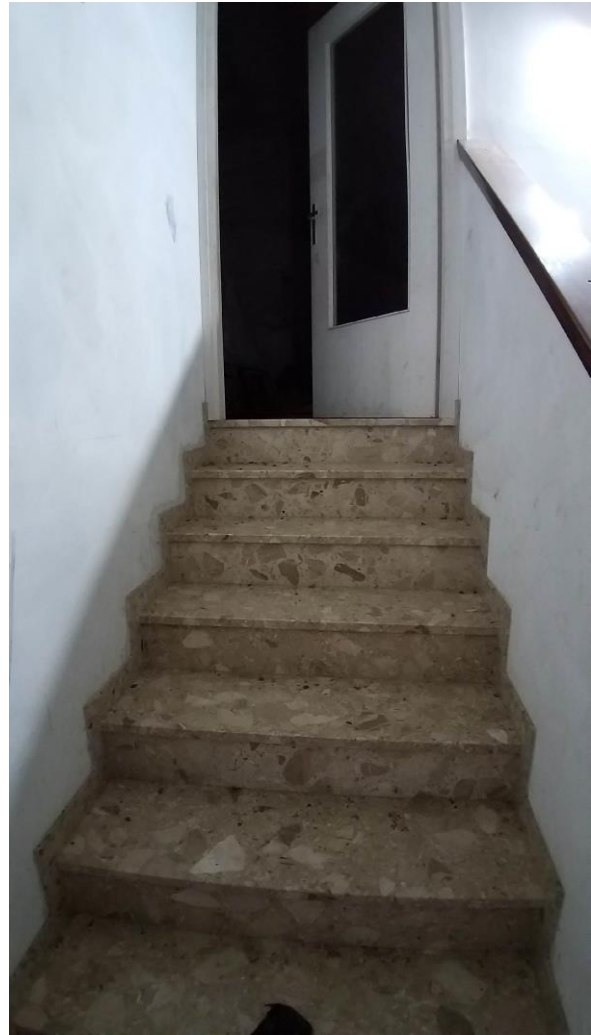
Foto n° 58 – Lotto 1 - Comune di Travesio (PN) – Foglio 20 m.le 87 sub 1 – Veduta, da posizione est, della seconda rampa di scale che conduce al primo piano, in fondo l'entrata alla soffitta.
