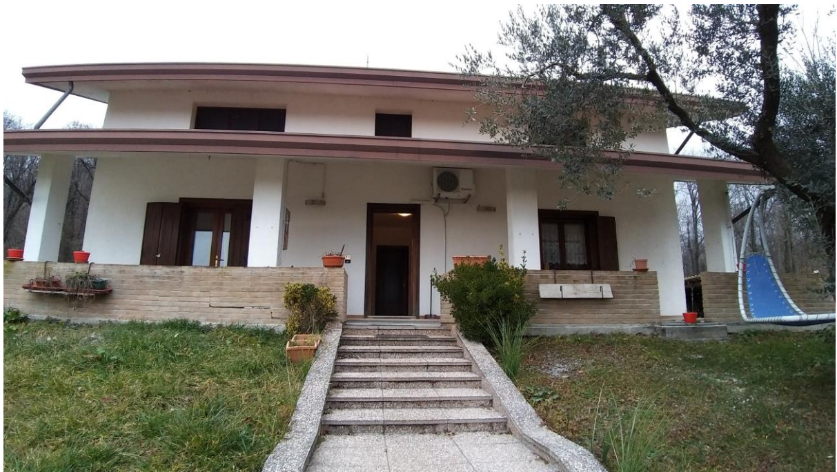
Foto n° 14 – Lotto 1 - Comune di Travesio (PN) – Foglio 20 m.le 87 – Veduta, da posizione sud e dal cancello pedonale di accesso, del giardino e del porticato dell'abitazione pignorata.
