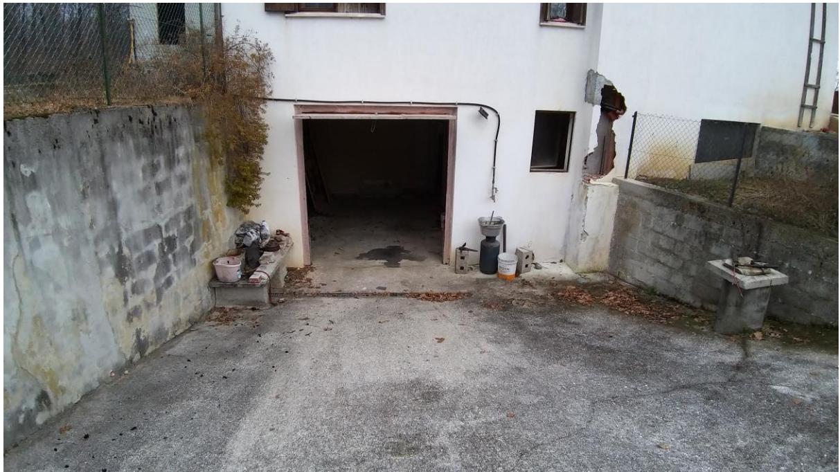
Foto n° 13 – Lotto 1 - Comune di Travesio (PN) – Foglio 20 m.le 87 – Particolare della rampa di accesso al garage sub 2 di cui alla foto precedente.
