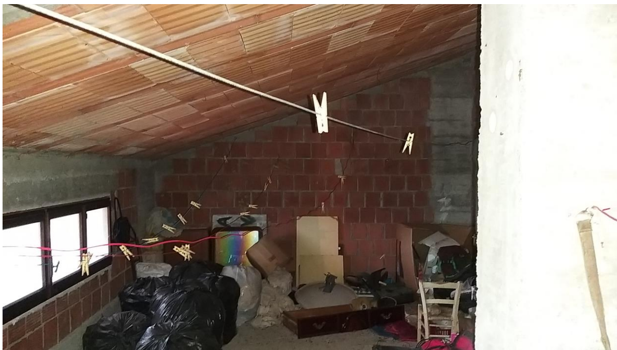
Foto n° 63 - Lotto 1 - Comune di Travesio (PN) - Foglio 20 m.le 87 sub 1 - Piano primo. Particolare interno di porzione sud-ovest della soffitta di cui alla foto precedente.
