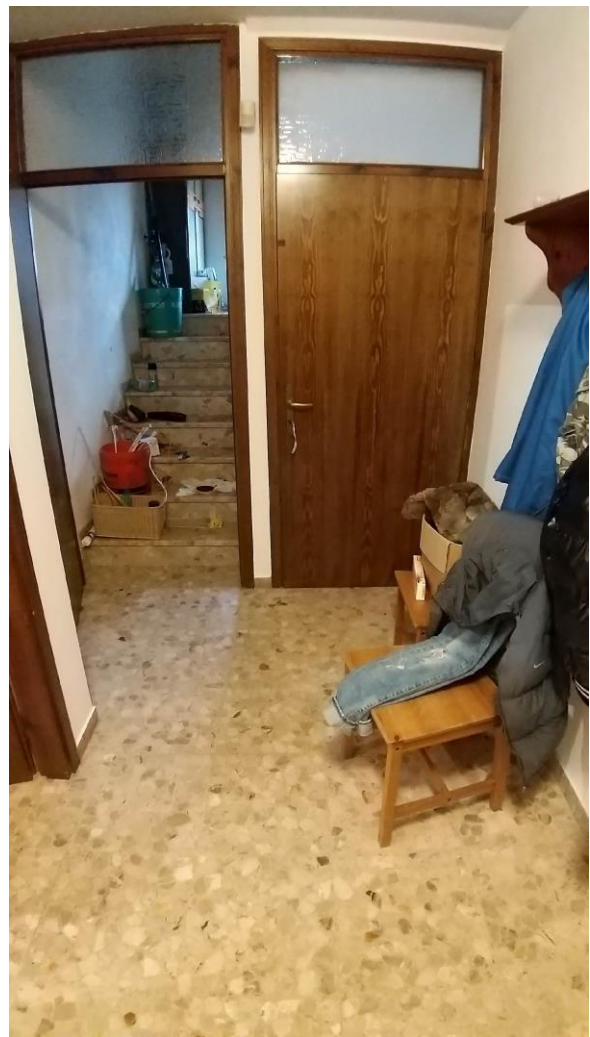
Foto n° 25 – Lotto 1 - Comune di Travesio (PN) – Foglio 20 m.le 87 sub 1 – Piano terra. Veduta, da posizione opposta, di porzione est dello stesso disimpegno, con i due accessi ai vani scale della soffitta e del piano scantinato.
