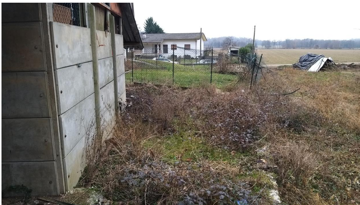
Foto n° 10 – Lotto 1 - Comune di Travesio (PN) – Foglio 20 m.le 87 – Veduta, da posizione nord, di parte del fabbricato abusivo di cui alla foto precedente (a sinistra nella foto) e del confine con altra particella non pignorata di proprietà dell'esecutato. In questa parte della proprietà la recinzione di rete metallica è in parte assente.
