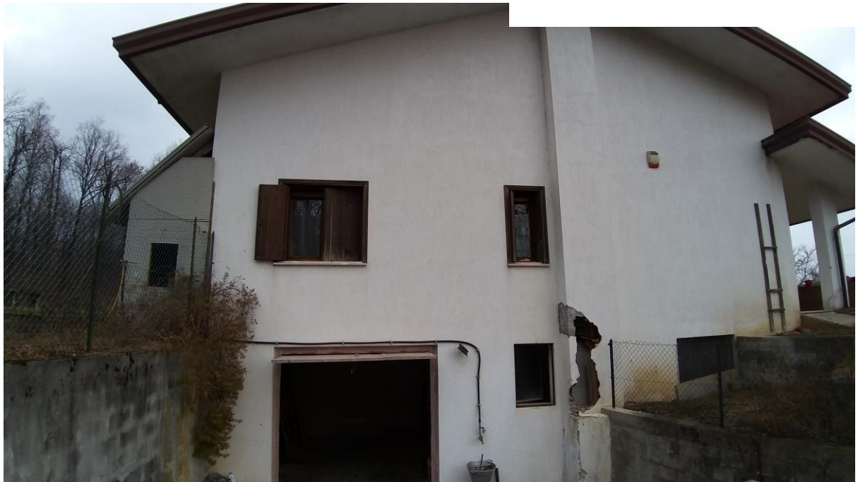
Foto n° 12 – Lotto 1 - Comune di Travesio (PN) – Foglio 20 m.le 87 – Veduta del fronte ovest del fabbricato sub 1 e dell'entrata al garage sub 2, posto nel seminterrato.
