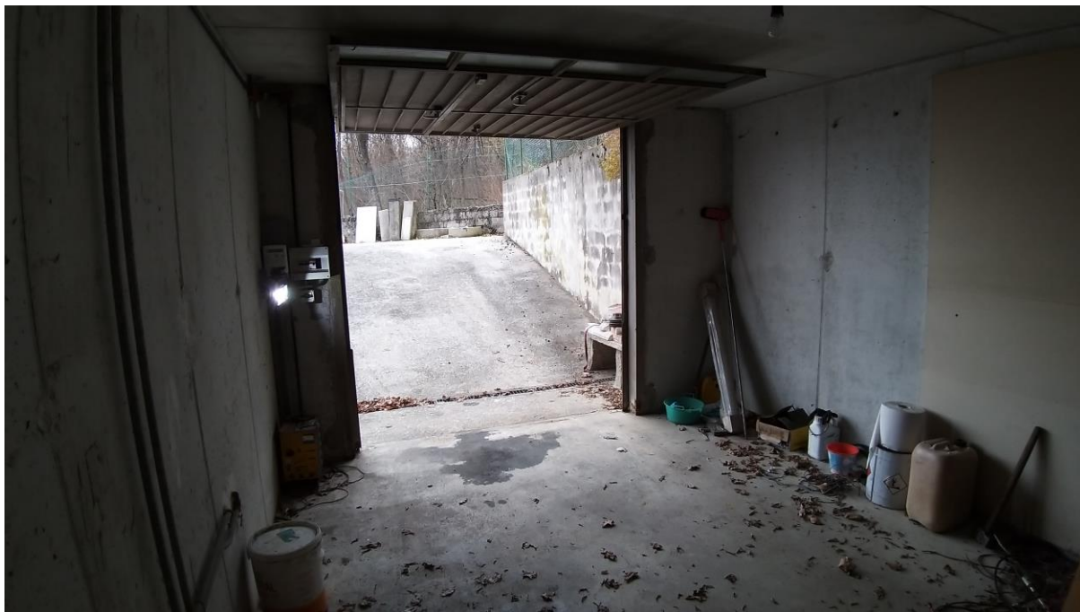
Foto n° 55 - Lotto 1 - Comune di Travesio (PN) - Foglio 20 m.le 87 sub 2 - Piano scantinato. Veduta della porzione ovest dell'autorimessa, con lo scivolo che conduce all'uscita secondaria dedicata.
