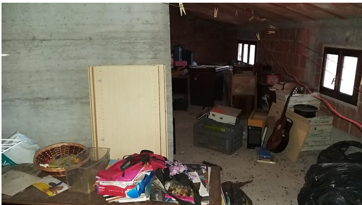
Foto n° 64 - Lotto 1 - Comune di Travesio (PN) - Foglio 20 m.le 87 sub 1 - Piano primo. Veduta interna della stessa soffitta da posizione ovest.
