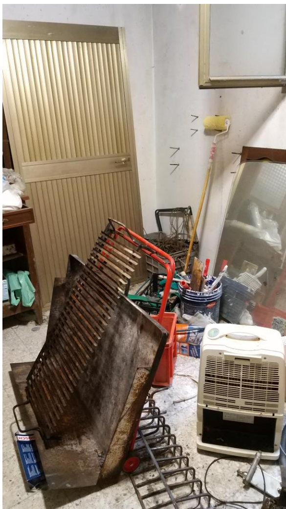
Foto n° 39 – Lotto 1 - Comune di Travesio (PN) – Foglio 20 m.le 87 sub 1 – Piano scantinato. Veduta, dalla porta di ingresso, di porzione nord-ovest del locale "lavanderia", in realtà utilizzato come deposito.
