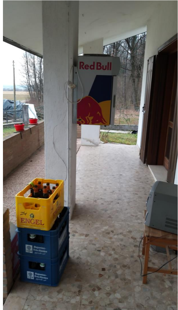
Foto n° 16 – Lotto 1 - Comune di Travesio (PN) – Foglio 20 m.le 87 sub 1 – Veduta del lato ovest dello stesso porticato.
