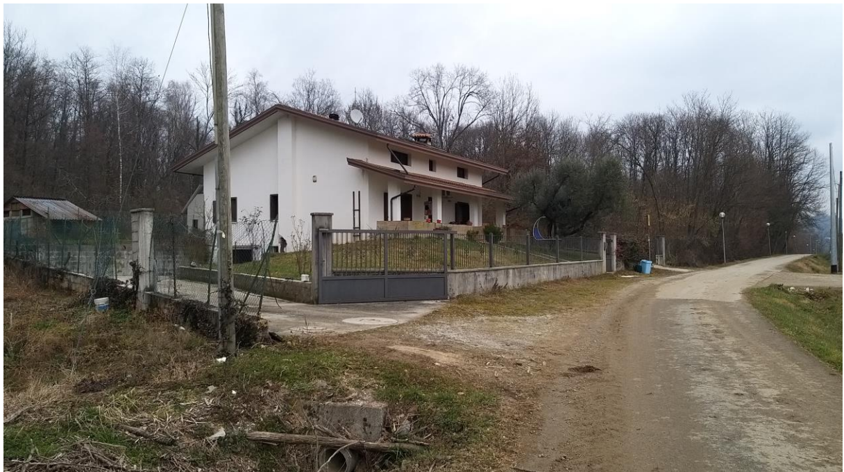
Foto n° 2 – Lotto 1 - Comune di Travesio (PN) – Foglio 20 m.le 87 – Veduta, da via Magredi e da posizione sud-ovest, del secondo accesso alla proprietà e al garage (sub 2), posto nel seminterrato sul fronte ovest dell'abitazione.
