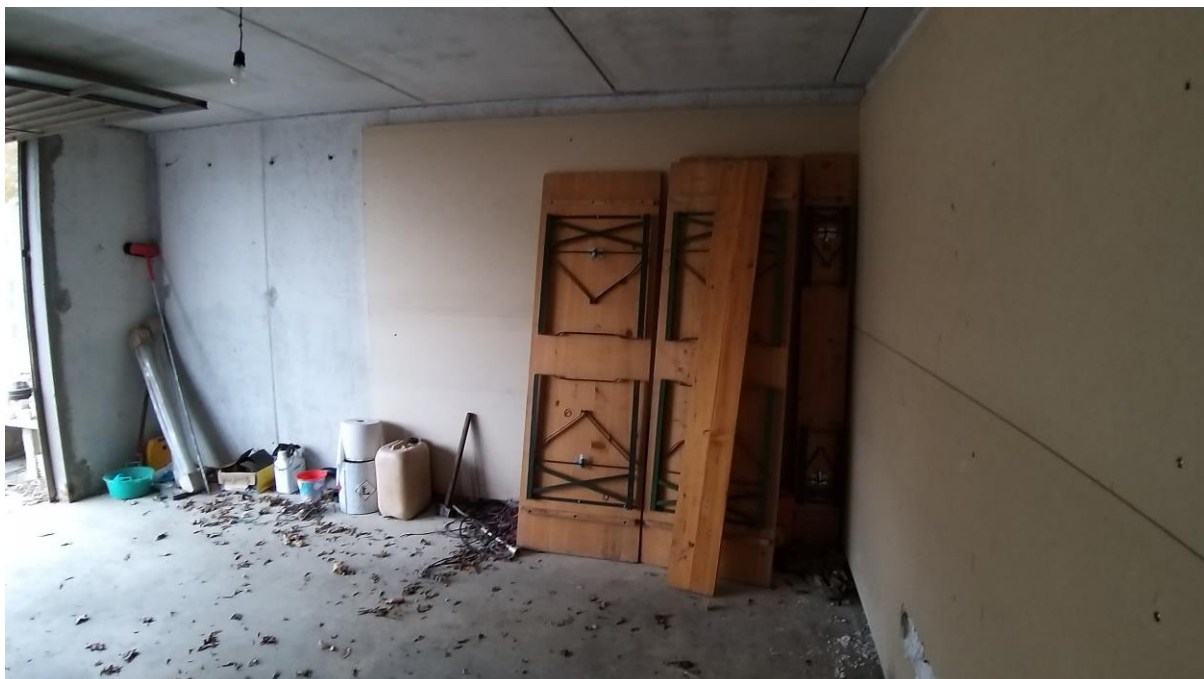
Foto n° 54 – Lotto 1 - Comune di Travesio (PN) – Foglio 20 m.le 87 sub 2 – Piano scantinato. Veduta, dall'ingresso, della porzione nord-ovest dell'autorimessa.
