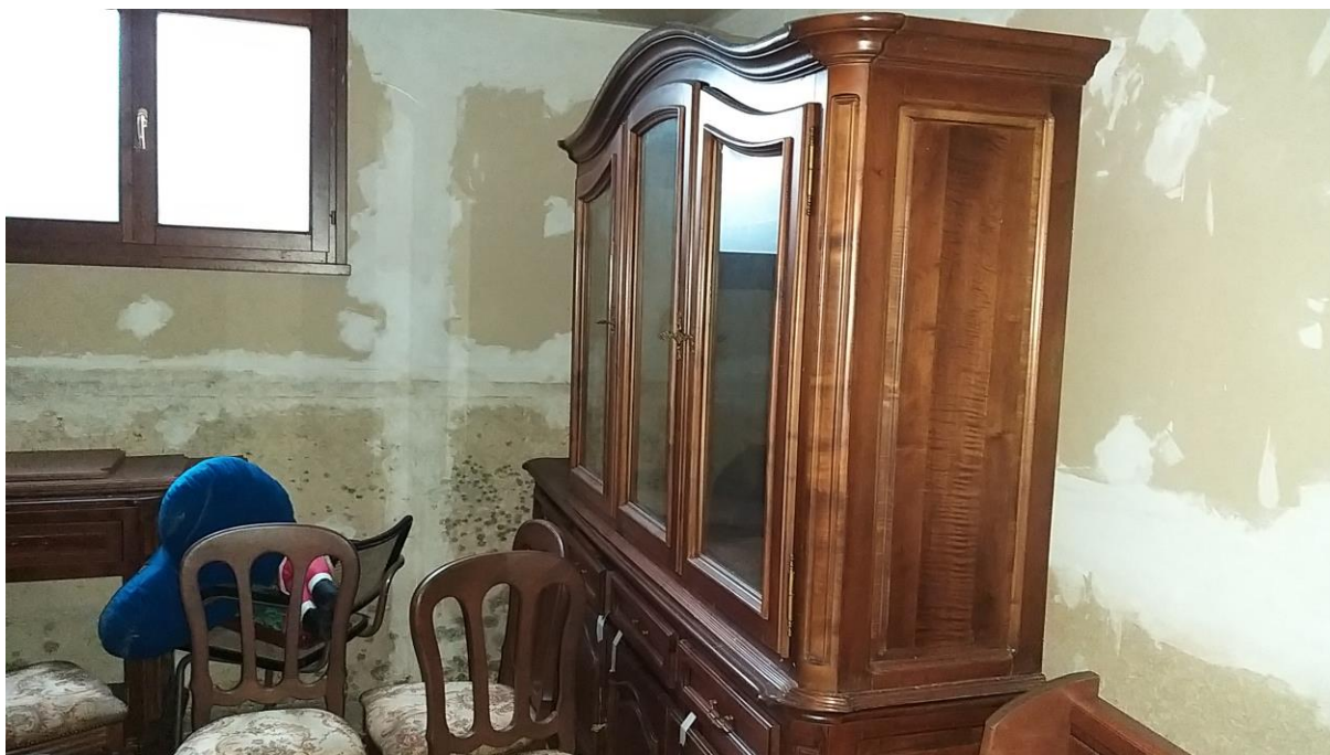
Foto n° 51 – Lotto 1 - Comune di Travesio (PN) – Foglio 20 m.le 87 sub 1 – Piano scantinato. Particolare della porzione nord-ovest dello stesso vano di cui alla foto precedente.
