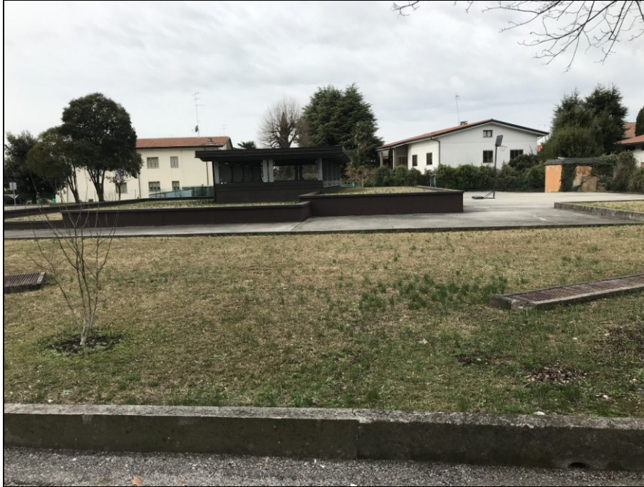
Fig.28: vista garage interrato dall'esterno
