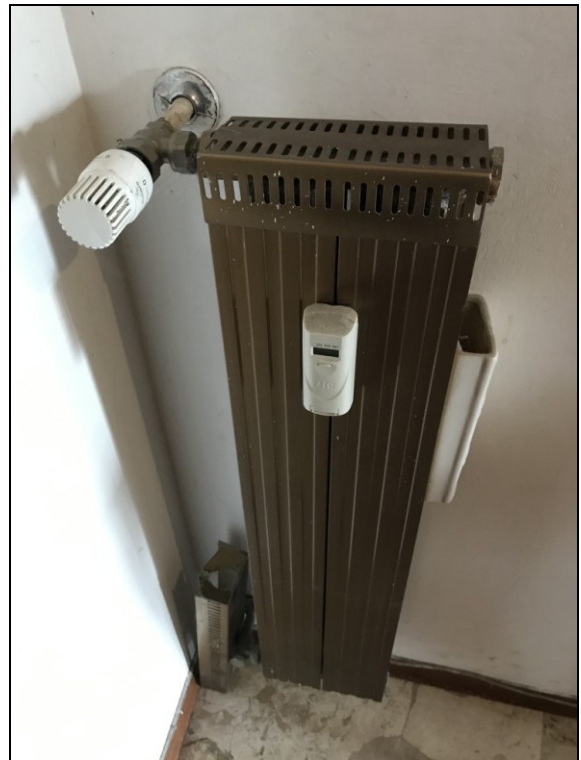
Fig.20: vista radiatore generico con valvola termostatica e ripartitore di calore
