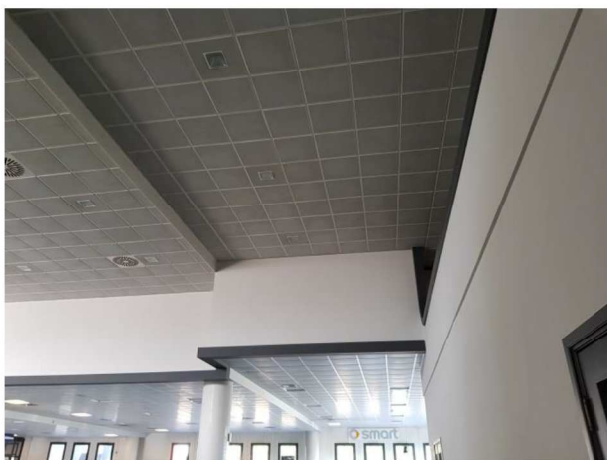
Controsoffitto zona esposizione - corpo A
