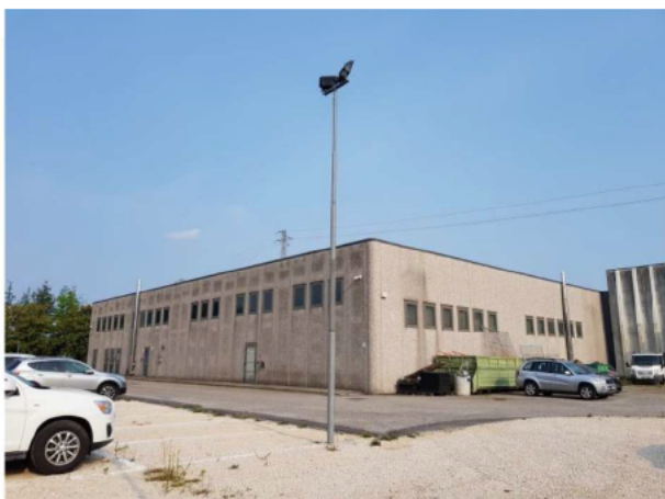
Prospetto lato Nord Corpo B
