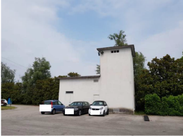
Ex cabina elettrica
