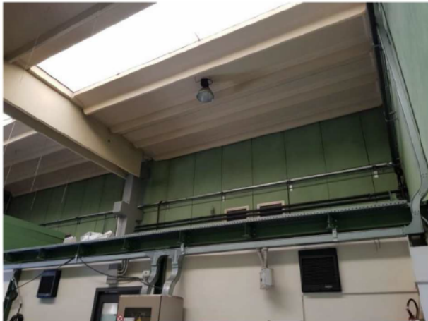
Soffitto - corpo A
