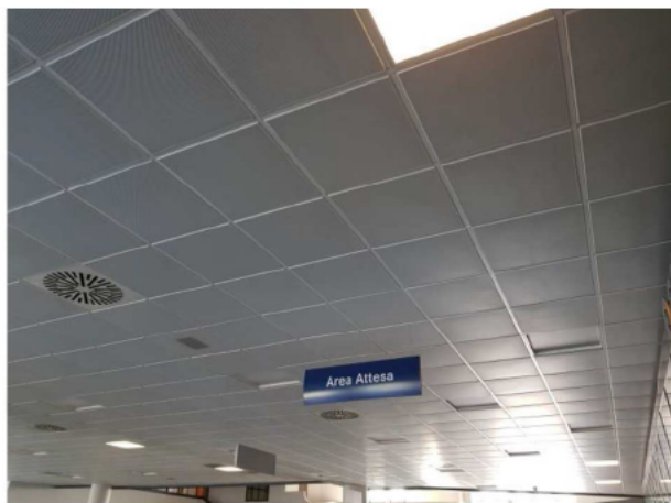
Controsoffitto zona esposizione - Corpo A
