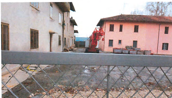
Vista da via S. Ulderico, attraverso il cancello che impedisce l'accesso all'area.
