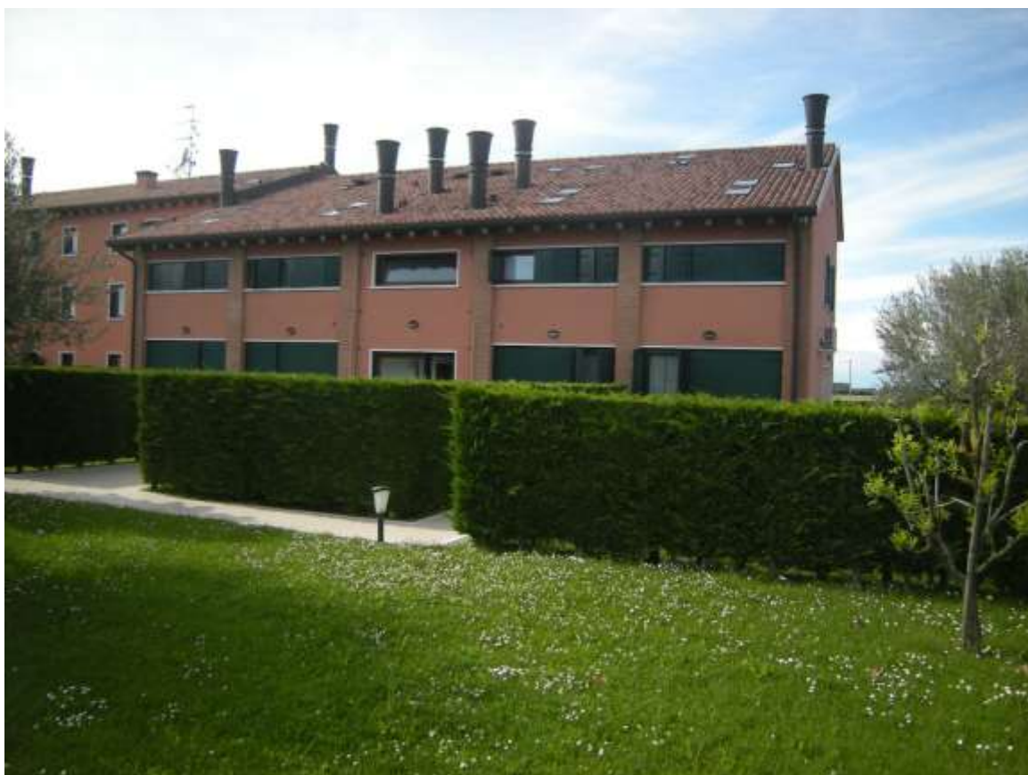
Ottava Presa (Caorle), Strada Fortuna n. 56 - Il prospetto a sud-est del fabbricato.
