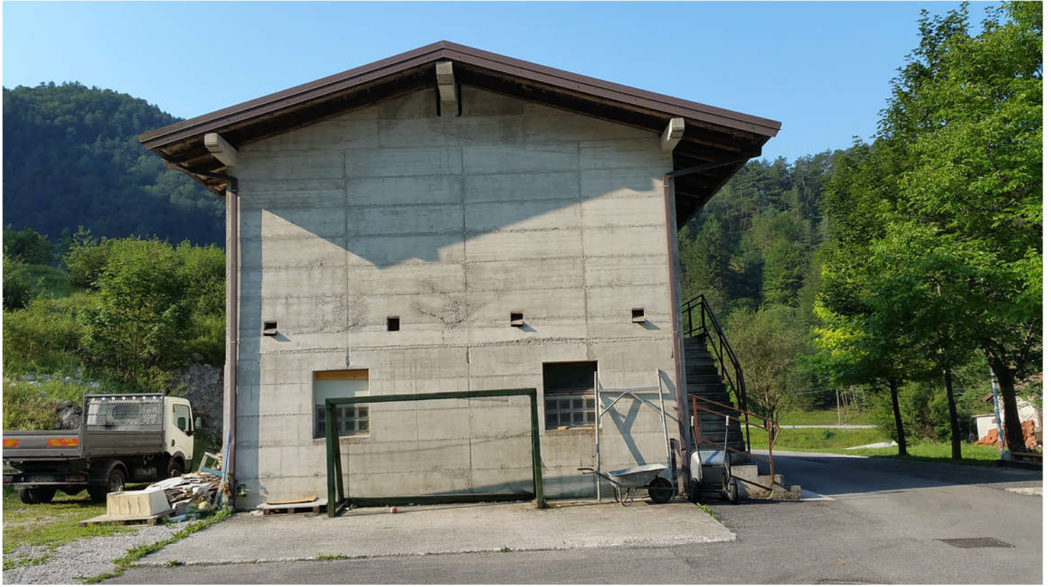
5 - lato nord e pertinenza
