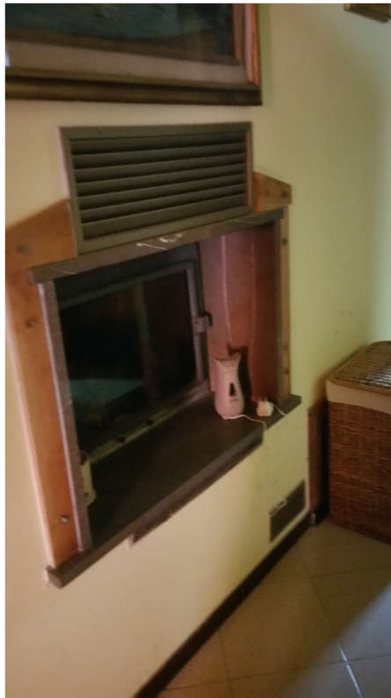
41 - particolare caminetto bifacciale su corridoio
