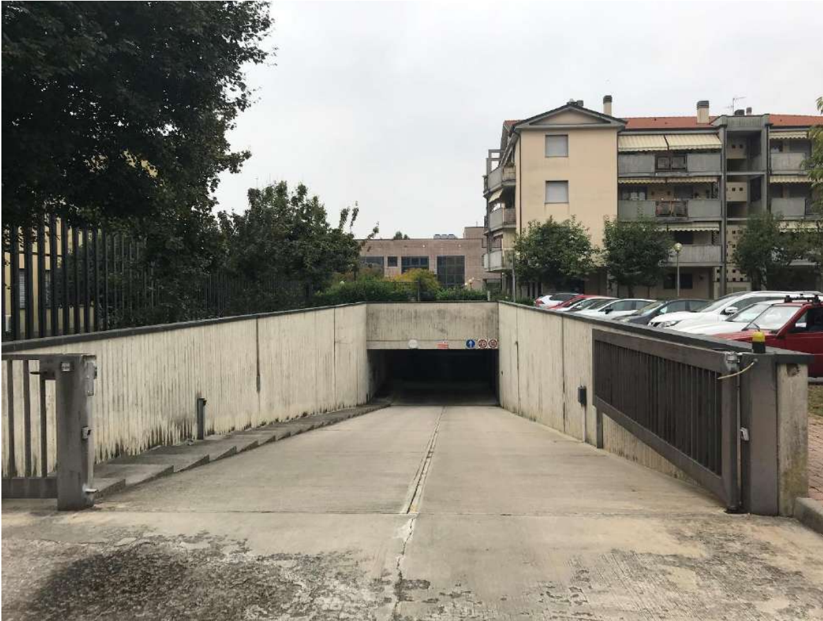
Ingresso esterno ai boxes
