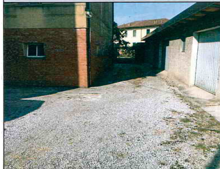
Vista dei parcheggi coperti esterni
