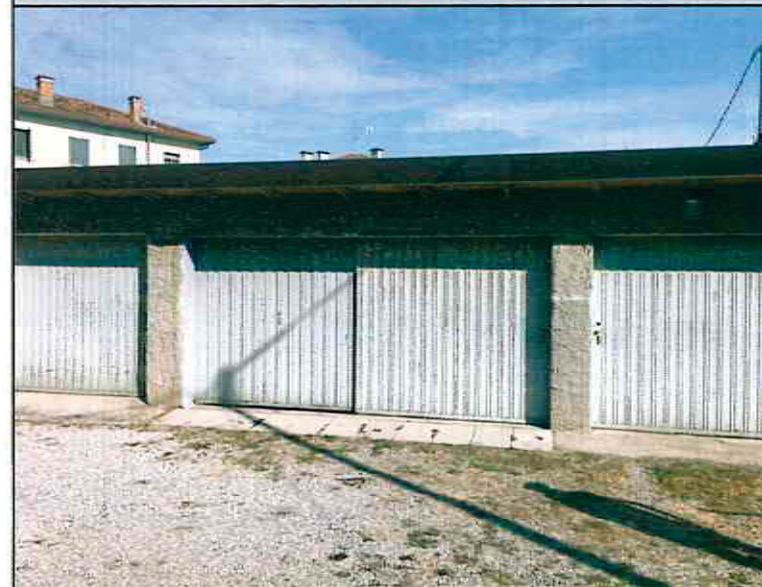
Vista dei parcheggi coperti esterni
