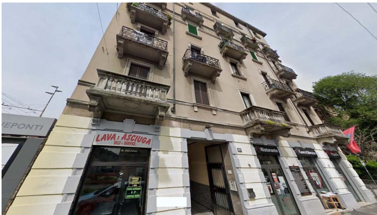
Viale Monza, 109 – fronte su strada
