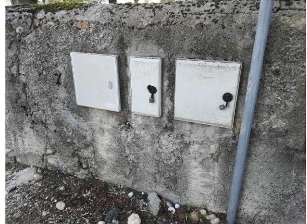
*Contatori corrente elettrica, collocati sul muro perimetrale a nord-est.*
