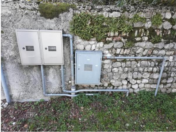
*Contatori gas, collocati sul muro perimetrale a nord-est.*
