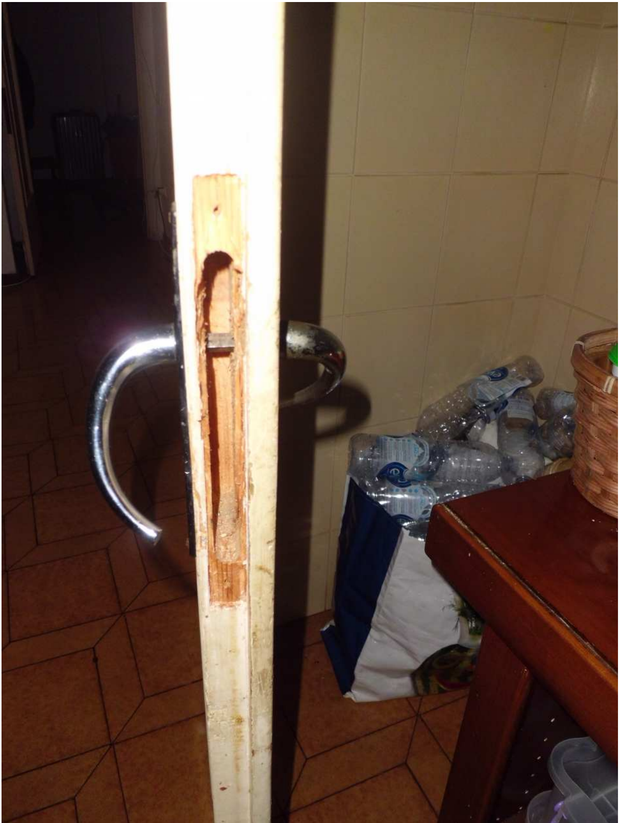
Foto n° 28 - 14/03/2019 - Comune di Maniago, foglio 20, part. 474, sub.67 – Particolare della porta di accesso alla cucina.
