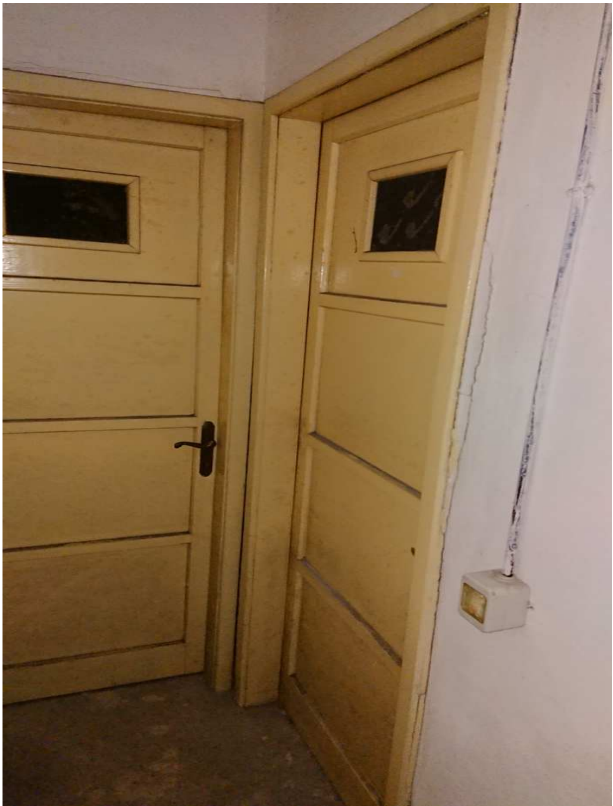
Foto n° 35 - 14/03/2019 - Comune di Maniago, foglio 20, part. 474, sub.67 – Secondo piano sottostrada. Porta di accesso alla cantina.
