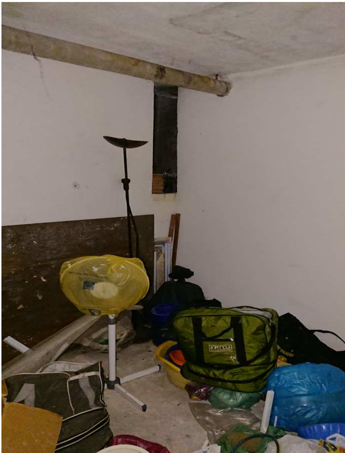
Foto n° 37 - 14/03/2019 - Comune di Maniago, foglio 20, part. 474, sub.67 – Cantina posta al secondo piano sottostrada.
