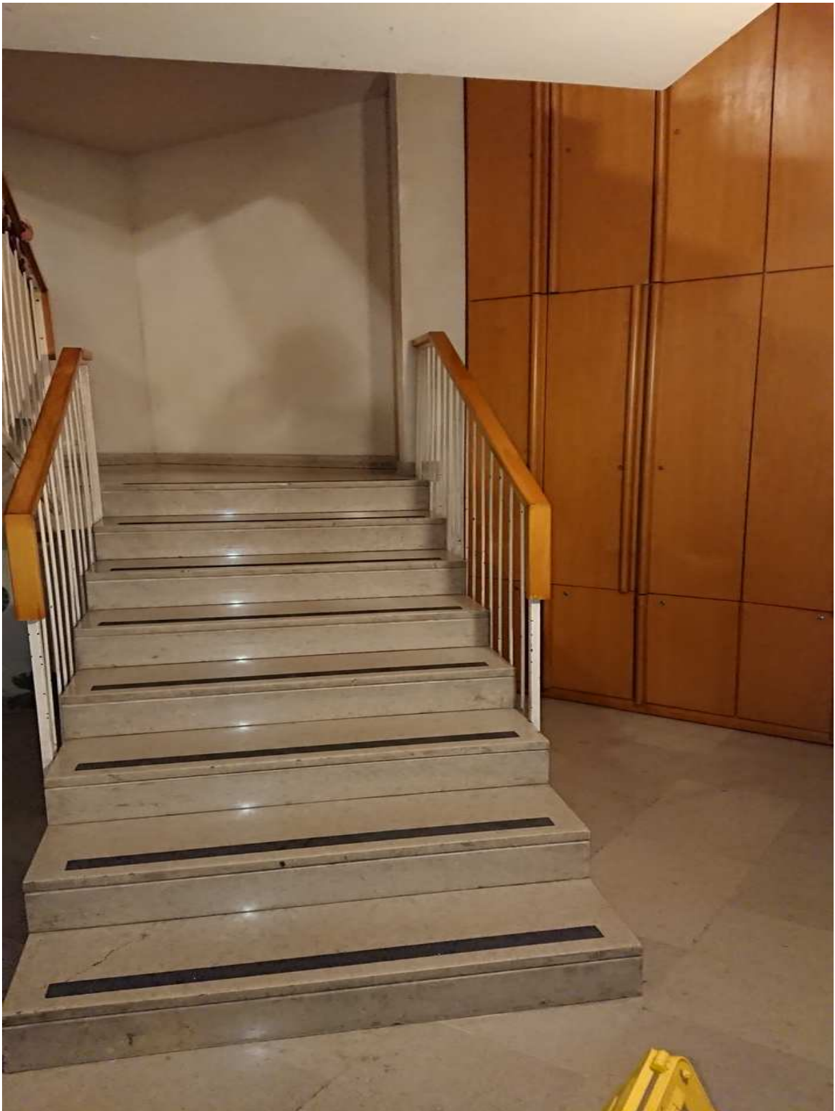
Foto n° 4 - 14/03/2019 - Comune di Maniago, foglio 20, part. 474 – Scala interna condominiale, piano terra.
