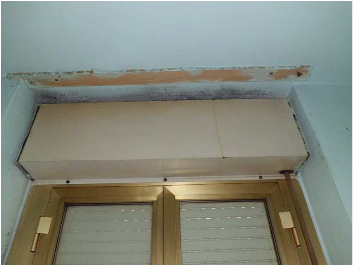
Foto n° 26 - 14/03/2019 - Comune di Maniago, foglio 20, part. 474, sub.67 – Particolare della cucina.
