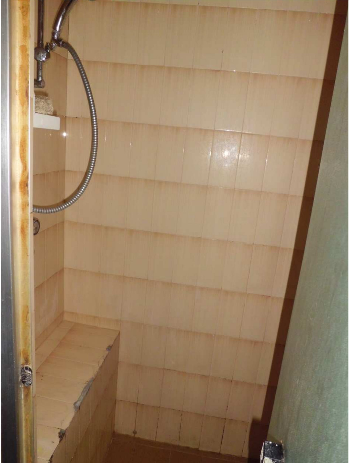
Foto n° 21 - 14/03/2019 - Comune di Maniago, foglio 20, part. 474, sub.67 – Vano doccia ubicato nel bagno piccolo.
