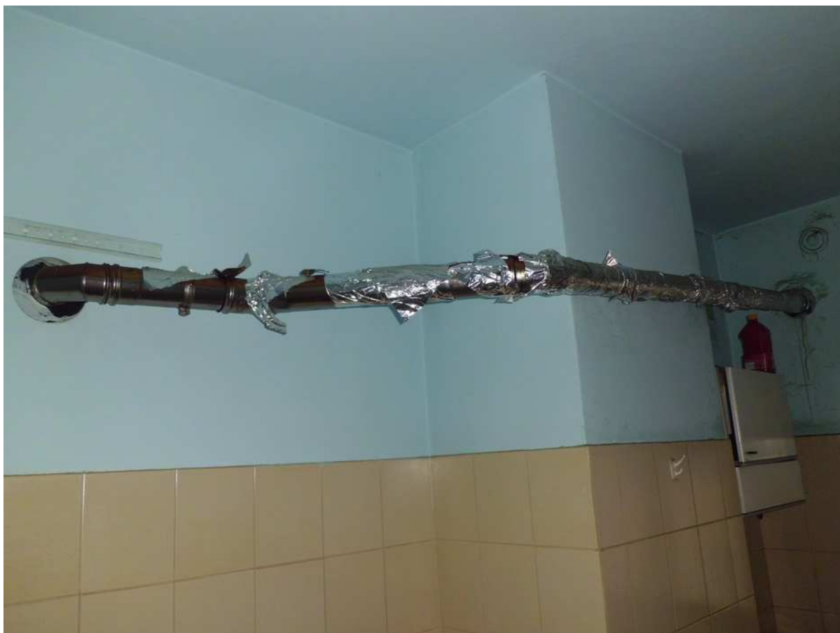
Foto n° 27 - 14/03/2019 - Comune di Maniago, foglio 20, part. 474, sub.67 – Particolare della cucina.
