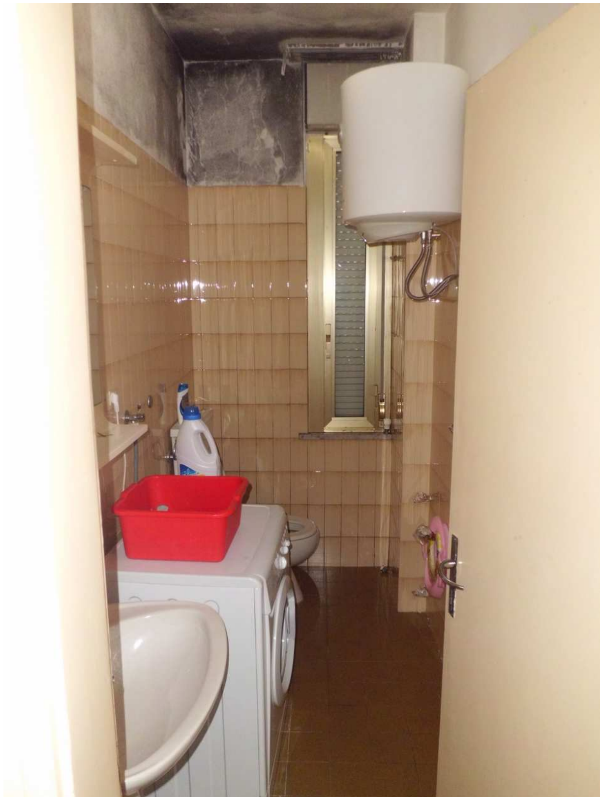
Foto n° 19 - 14/03/2019 - Comune di Maniago, foglio 20, part. 474, sub.67 – Bagno piccolo. Fotografia scattata dalla porta di accesso alla stanza.
