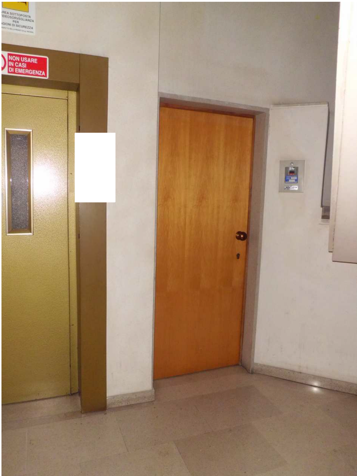
Foto n° 32 - 14/03/2019 - Comune di Maniago, foglio 20, part. 474 – Vano scale condominiale al piano terra. Visibile la porta di accesso ai piani sottostrada del condominio.
