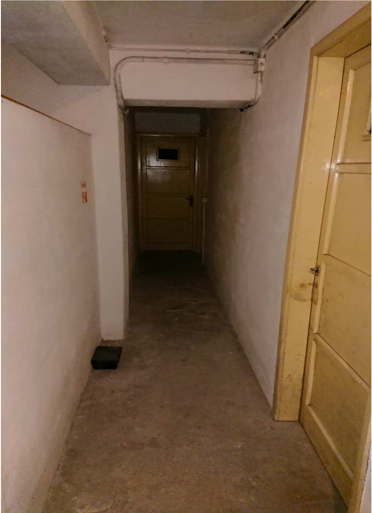
Foto n° 34 - 14/03/2019 - Comune di Maniago, foglio 20, part. 474 – Secondo piano sottostrada. Corridoio condominiale che conduce alla cantina.
