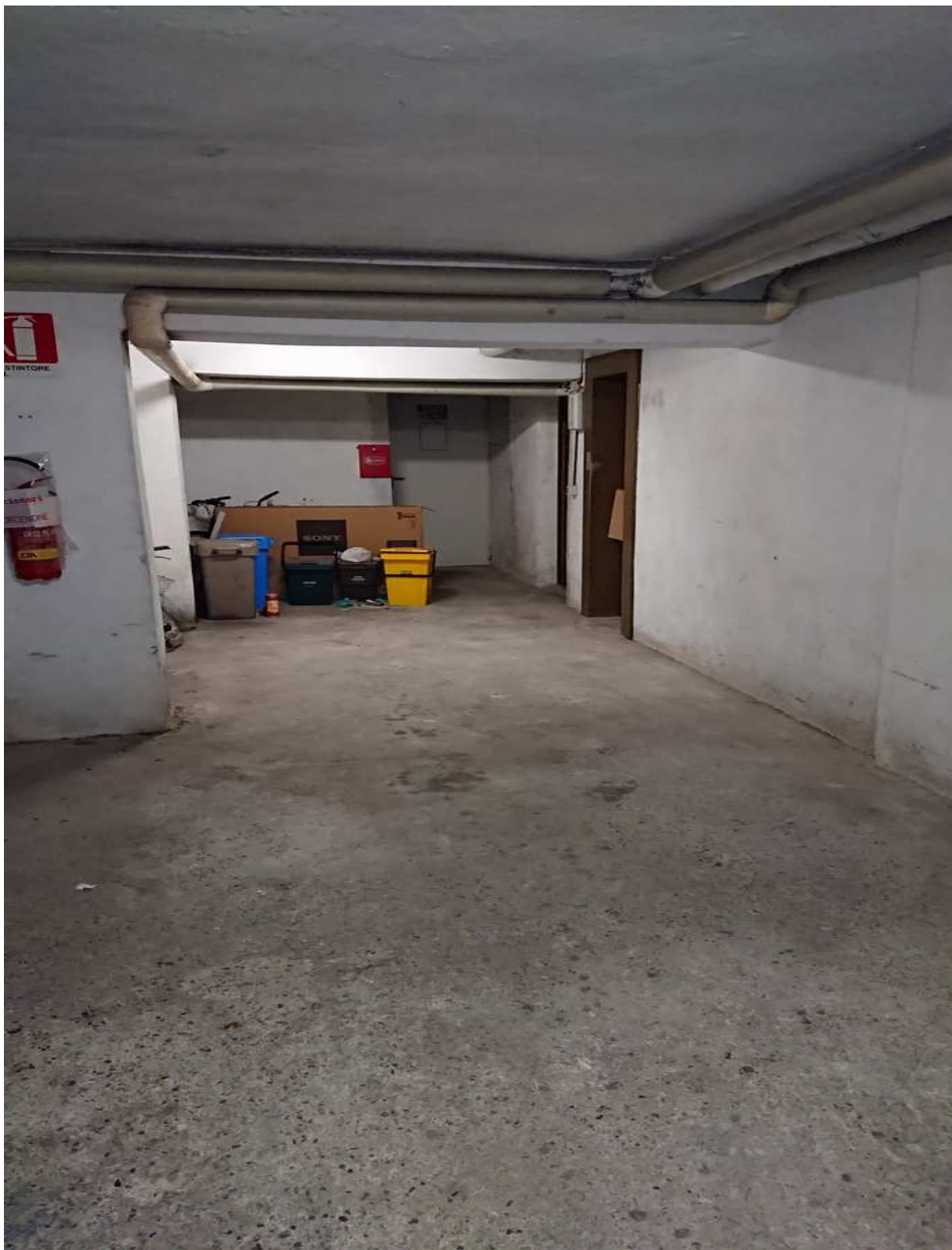
Foto n° 38 - 14/03/2019 - Comune di Maniago, foglio 20, part. 474 – Secondo piano sottostrada.
