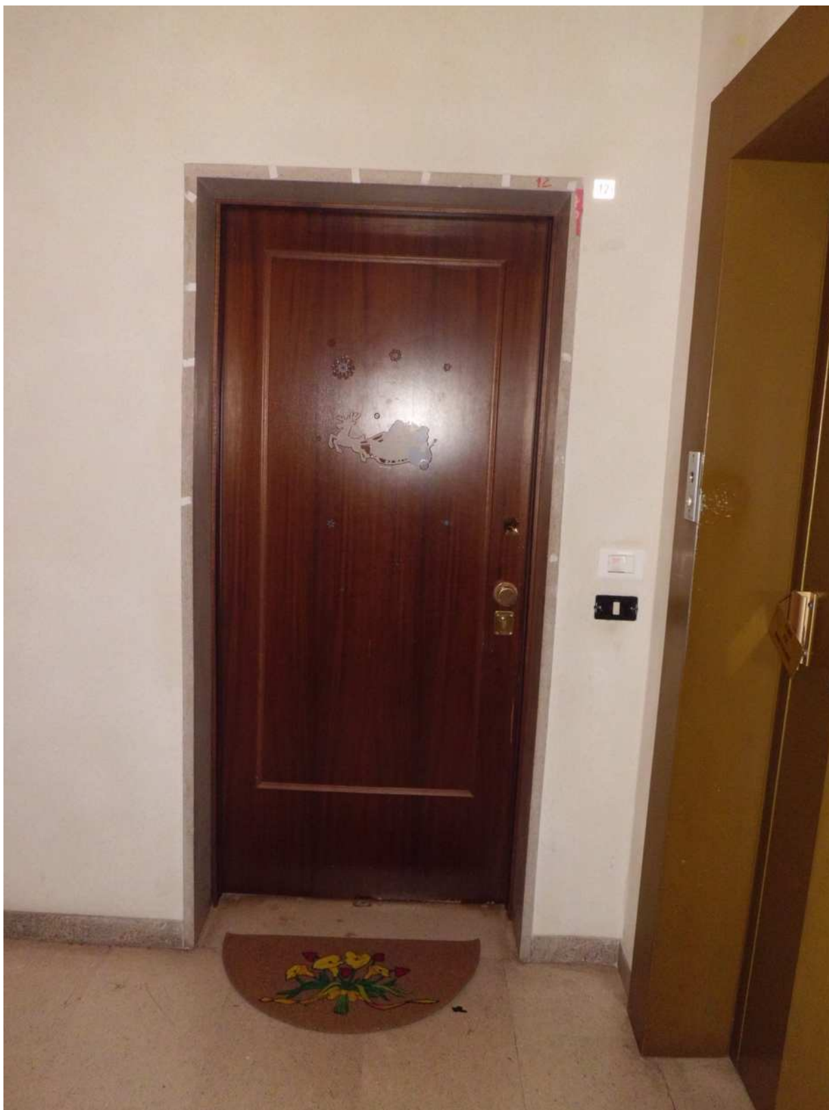
Foto n° 6 - 14/03/2019 - Comune di Maniago, foglio 20, part. 474 – Porta di accesso all'immobile pignorato. Alla destra si intravede la porta dell'ascensore.
