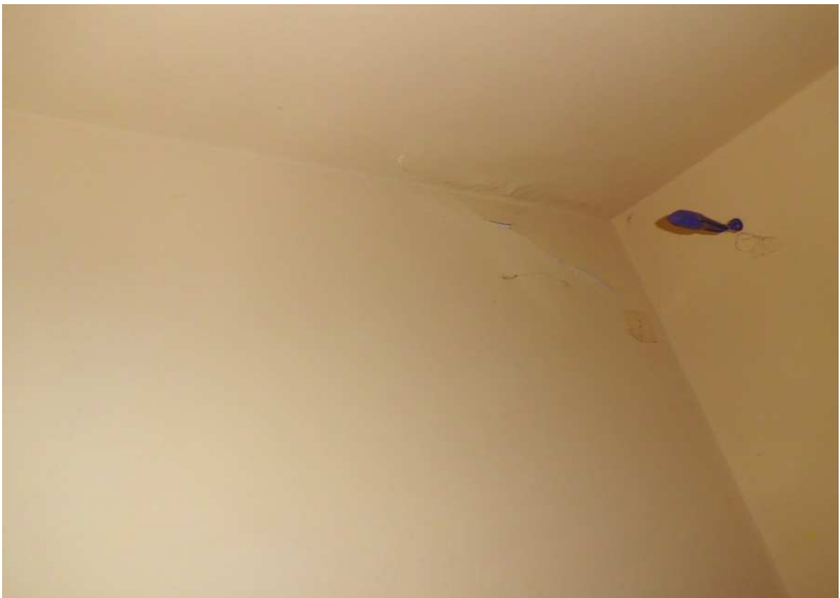
Foto n° 14 - 14/03/2019 - Comune di Maniago, foglio 20, part. 474, sub.67 – Camera. Particolare delle pareti.
