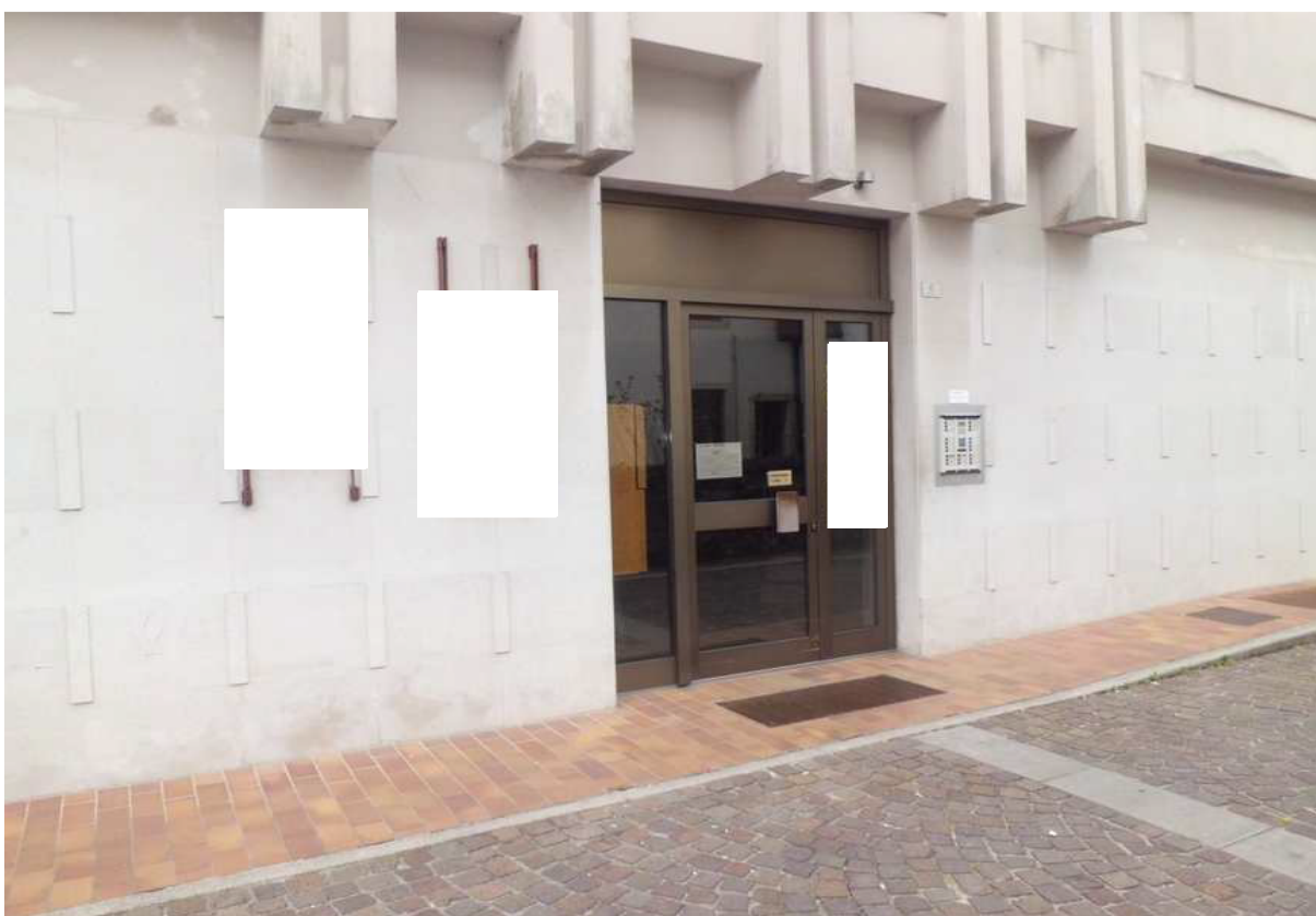
Foto n° 3 - 14/03/2019 - Comune di Maniago, foglio 20, part. 474 – Portone di accesso al condominio denominato "CASA ALTA".
