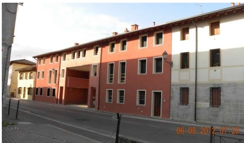
Portico di accesso area, lato Via Plebiscito
