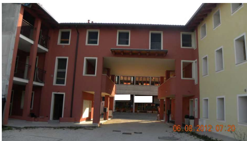
Portico di accesso area, lato interno, con passo pedonali da ambo i lati.
