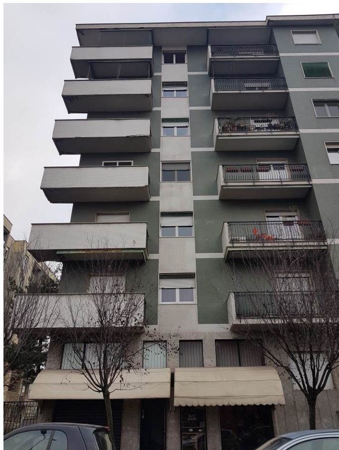
FOTO 1: BRESCO, VIA LILLO DEL DUCA 23, fronte dell'edificio
