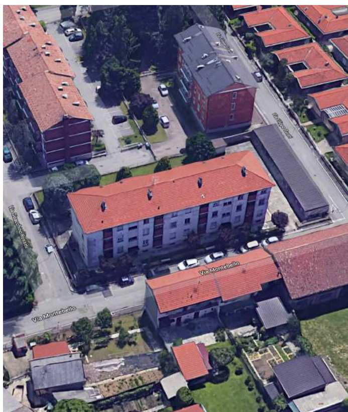
Foto 3,4,5 - vista esterna edificio
