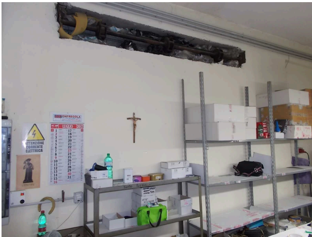
Foto n. 8: • Si scorge l'apertura della saracinesca murata (ambiente d'ingresso "sub 41").
