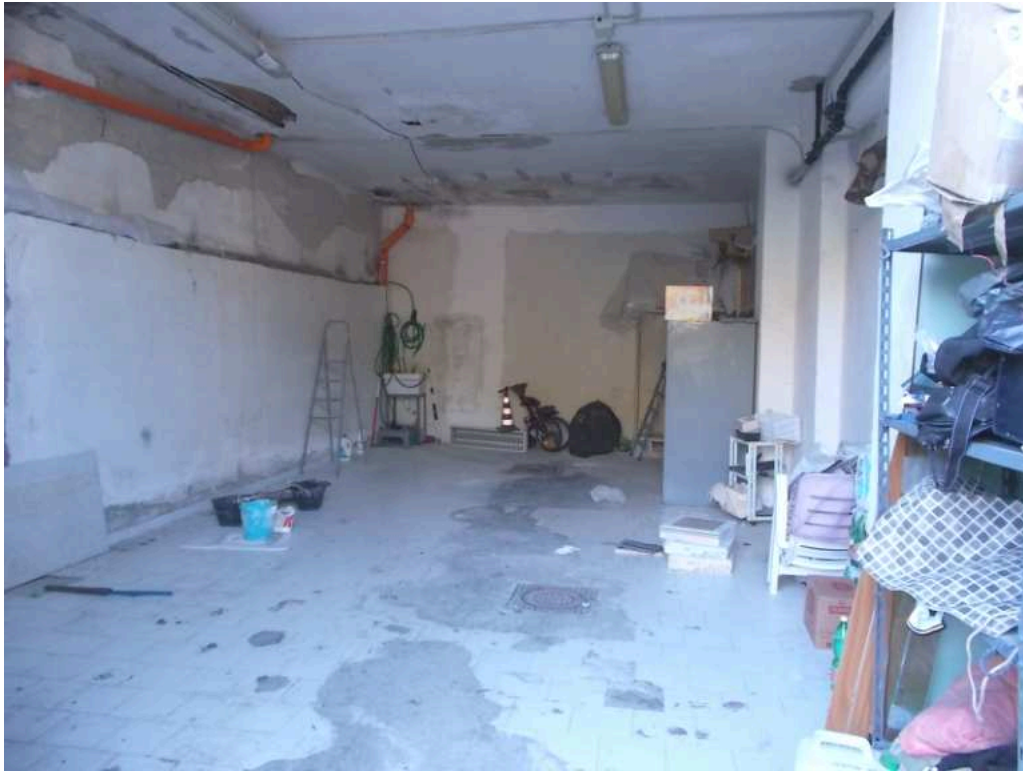
Foto n. 32: • Locale-deposito attualmente censito come "sez. PIA, foglio 10, particella 87, subaltemo 44" (monovano senza bagni).
