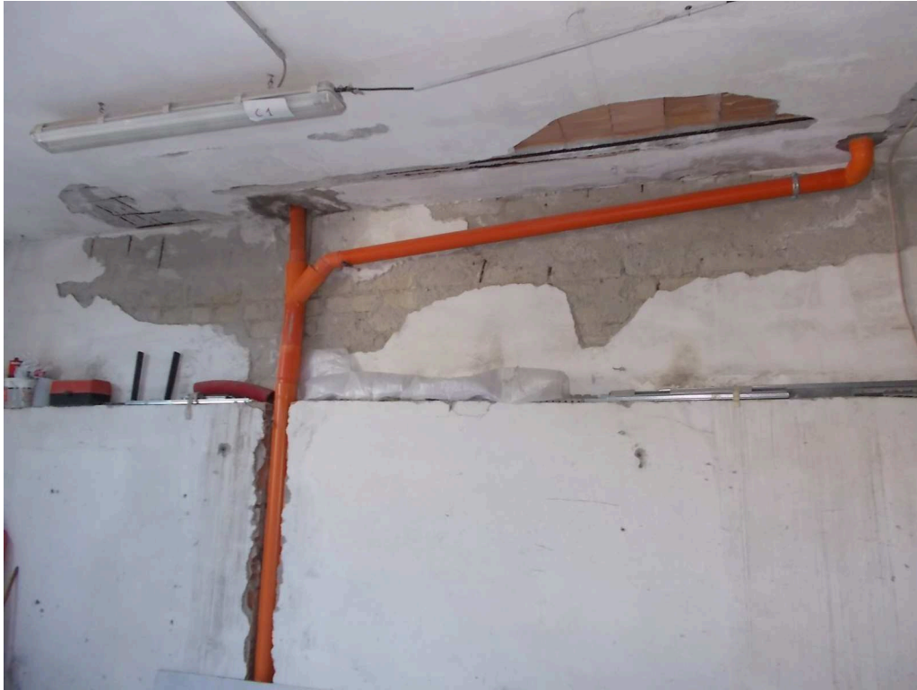
Foto n. 34: • Condizione dei luoghi nel locale-deposito "sub 44".
