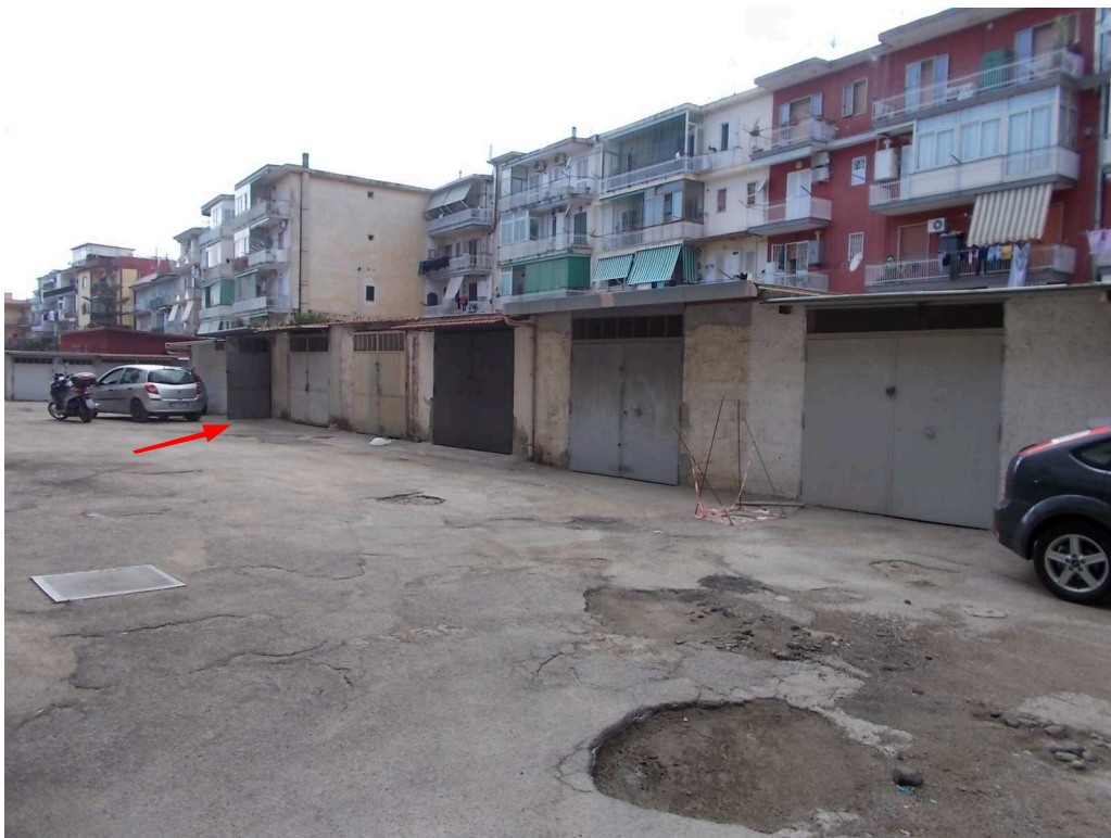
Foto n. 65: • Corpo di fabbrica comprendente l'immobile pignorato (visto dal varco di accesso da Via Ignazio Silone). • La costruzione è fisicamente ubicata al centro di un cortile circoscritto da altri fabbricati. • E' stata evidenziata la porta del locale d'interesse (la 6 a contando da destra).
