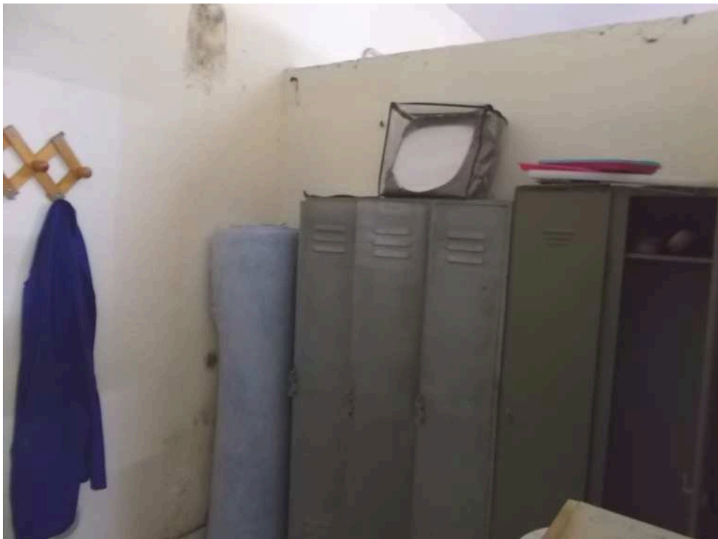
Foto n. 19: • Particolare foto n. 17 (spogliatoio).
