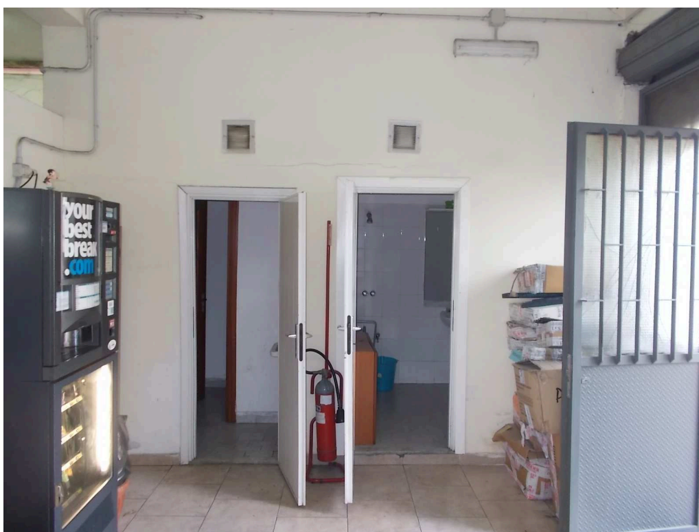
Foto n. 9: • Bagni del laboratorio "sub 41" (a ridosso della porta d'ingresso).
