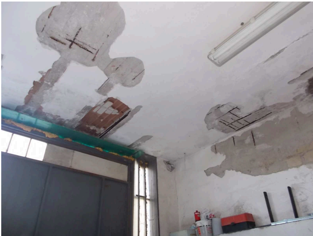
Foto n. 35: • Condizione dei luoghi nel locale-deposito "sub 44".
