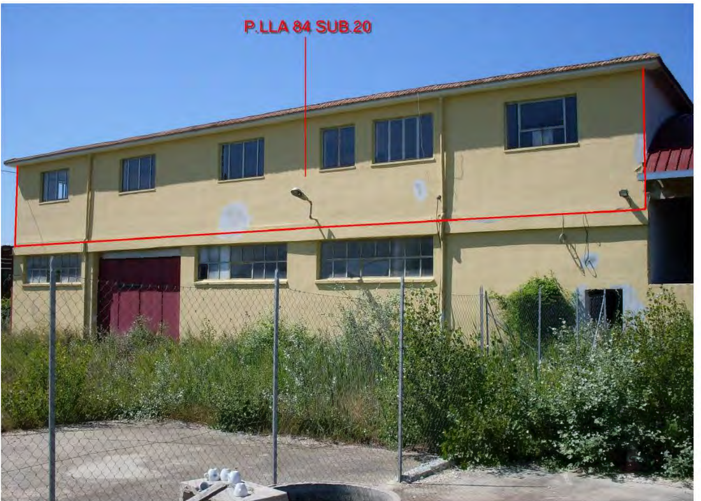
PORZIONE DELLA P.LLA 84 SUB.19, DI FATTO UNITA CON LA P.LLA 84 SUB.20.
