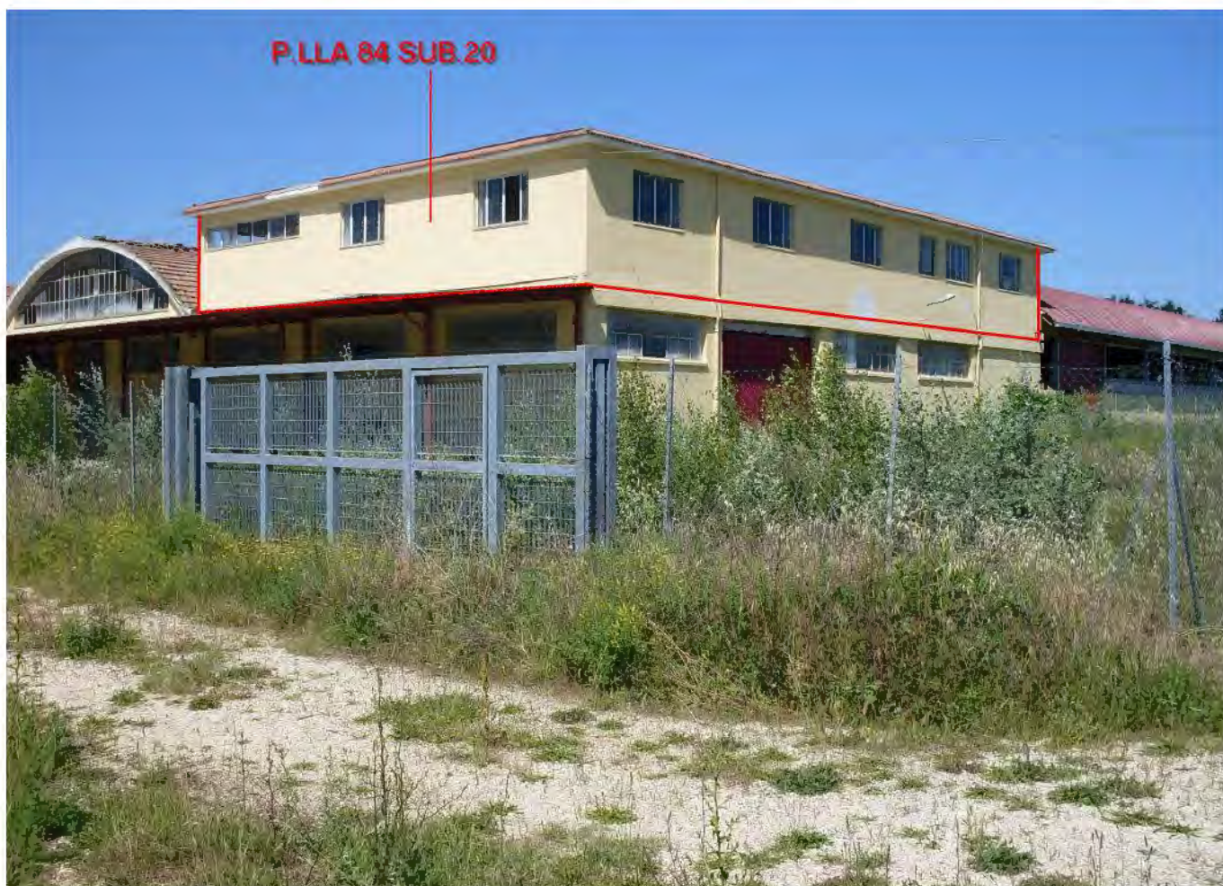
PORZIONE DELLA P.LLA 84 SUB.19. DI FATTO UNITA CON LA P.LLA 84 SUB.20.
