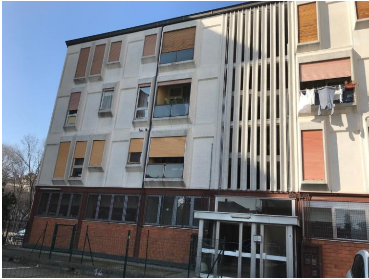
Immagine 3. Il fabbricato inquadrato dall'esterno; al centro della facciata è riconoscibile il vano scale e al piede, la bussola che consente l'accesso.
