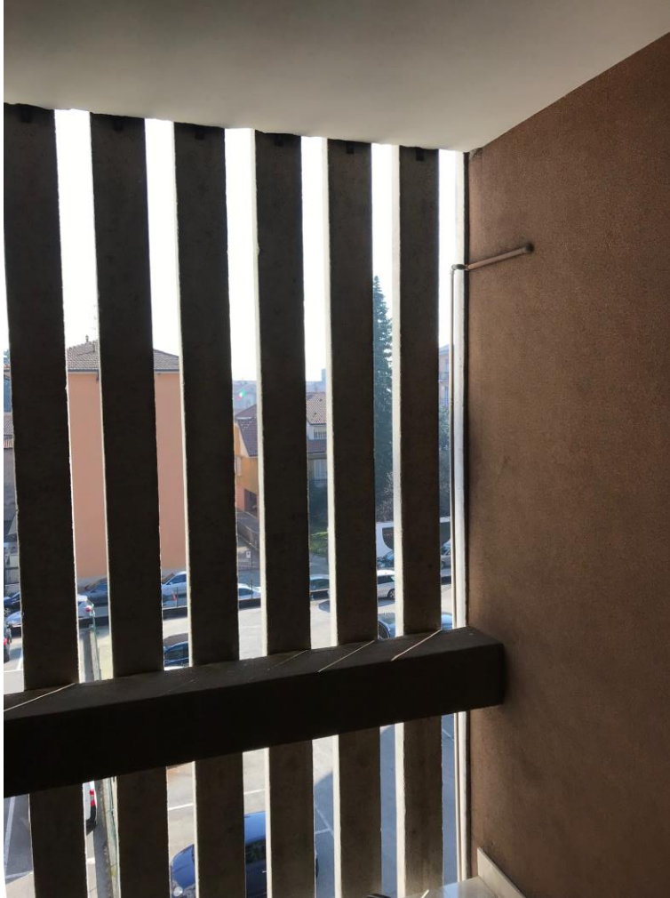
Immagine 9. Dettaglio della soluzione per l'illuminazione naturale della scala.
