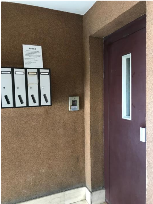
Immagine 7. L'androne di ingresso al fabbricato, dettaglio della collocazione delle cassette postali e dell'accesso all'ascensore.
