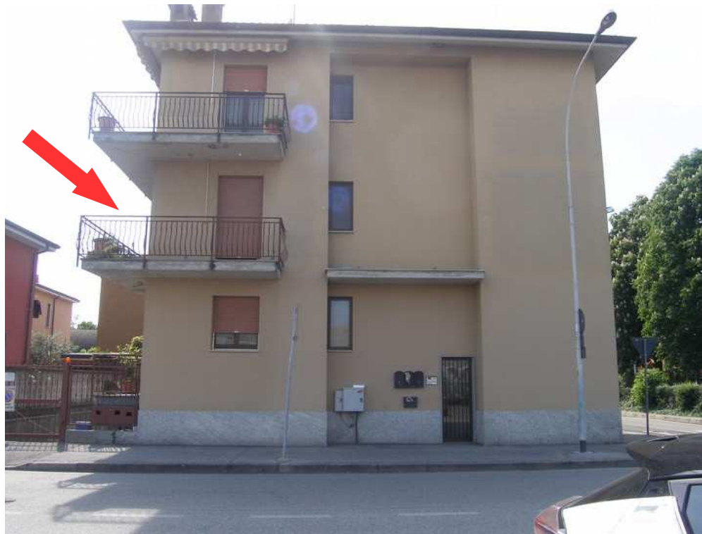
Fronte edificio su via della Resistenza
