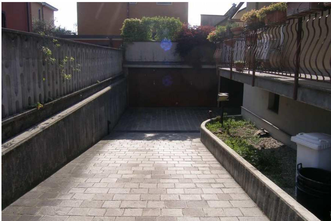
Rampa di accesso ai box
