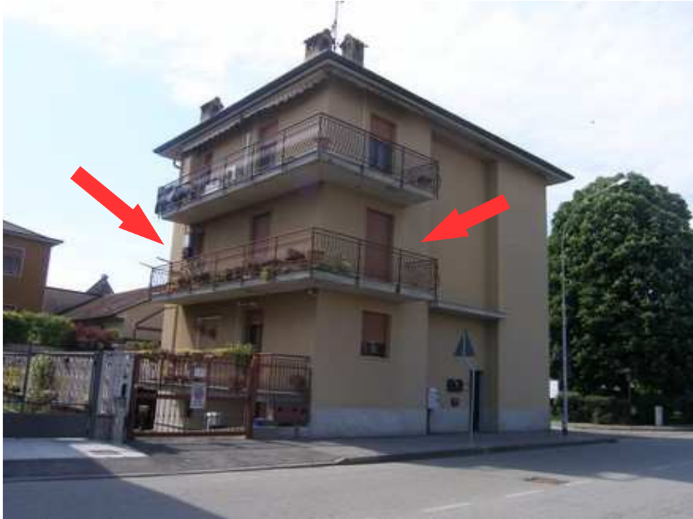
Edificio su via della Resistenza
