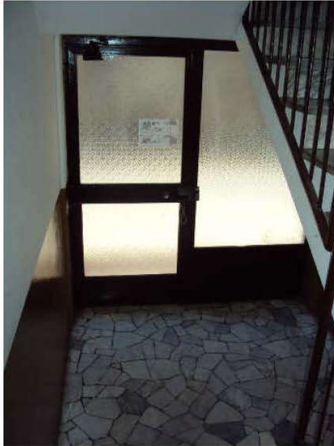
Ballatoio 03 Piano terra.JPG
