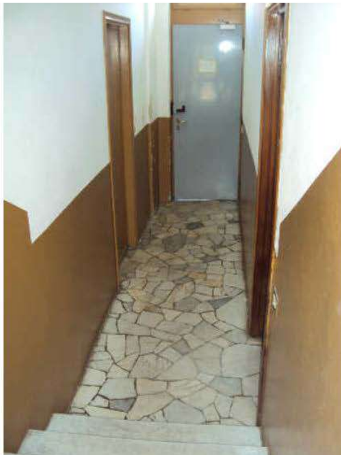
Ballatoio 04 PT Cantine.JPG
