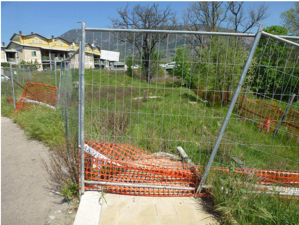
Foto n.08 – Area adibita a strada non realizzata
