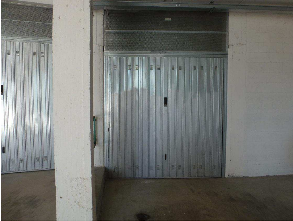
Foto n.11 ingresso garage sub.39
