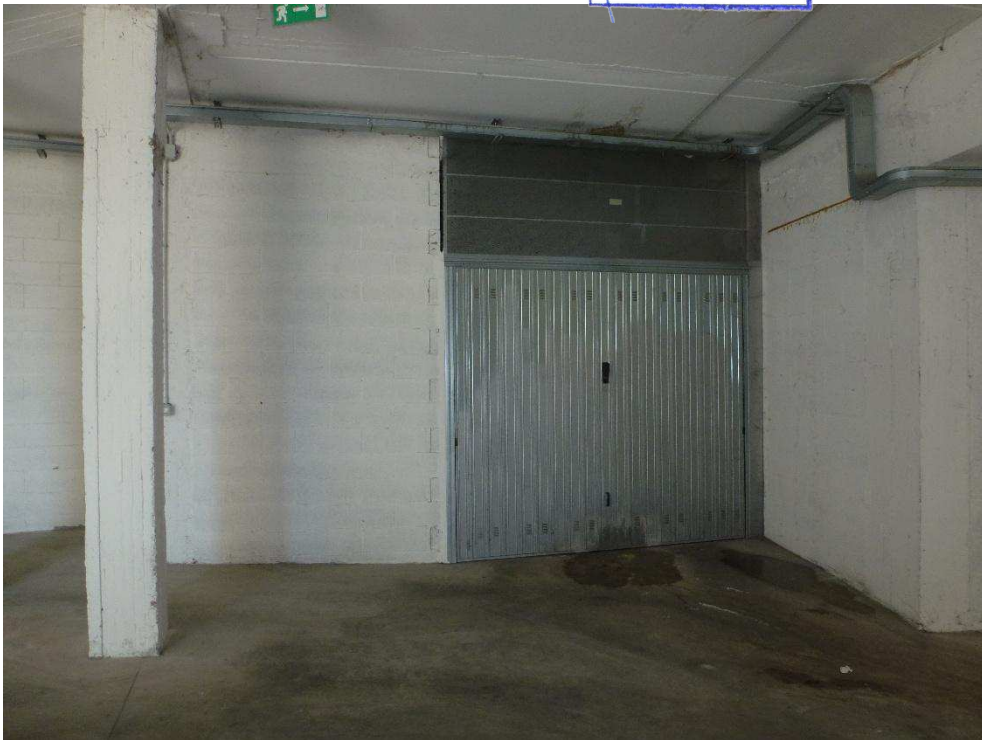
Foto n.28 – sub.40 ingresso garage piano primo sottostrada
