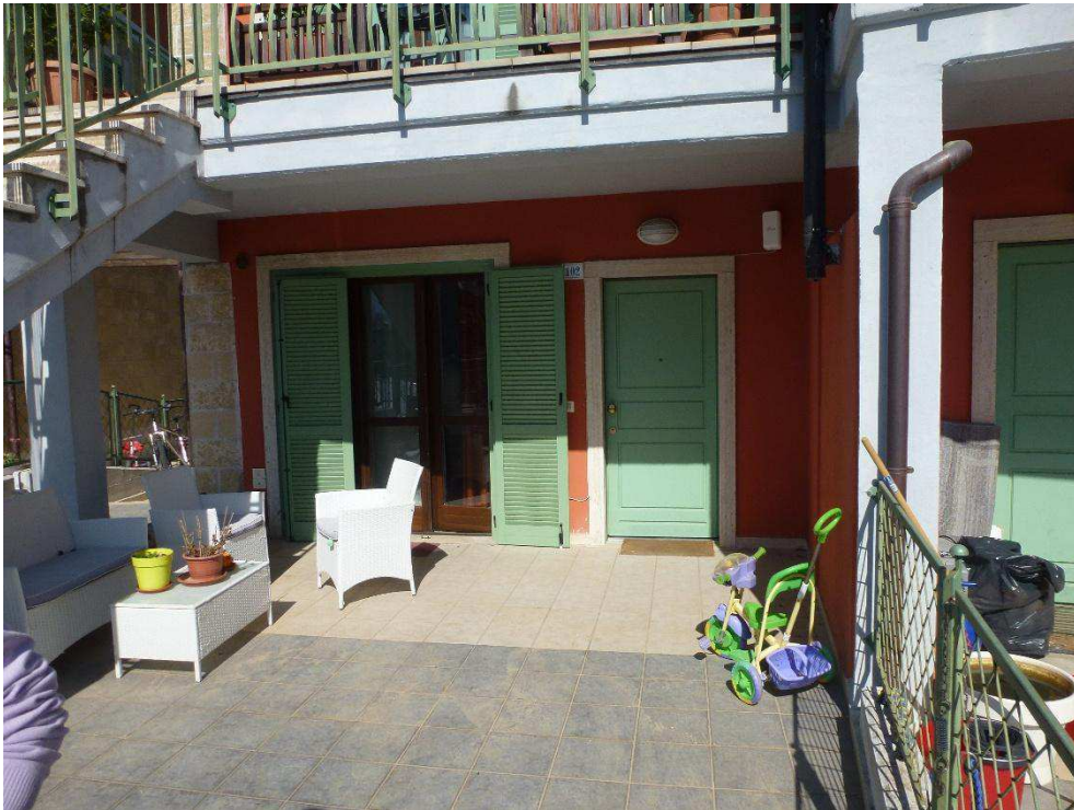
Foto n.01 Ingresso e prospetto principale
