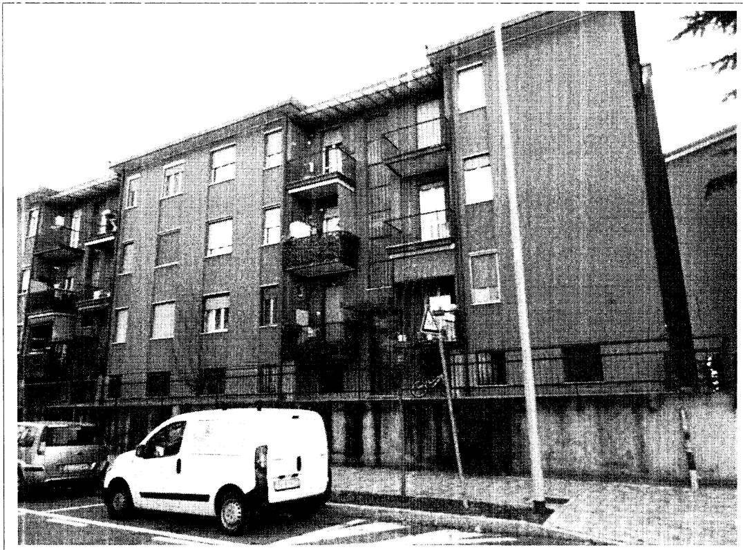
Fotografia n°2 – Vista della facciata del fabbricato su Via Milano
