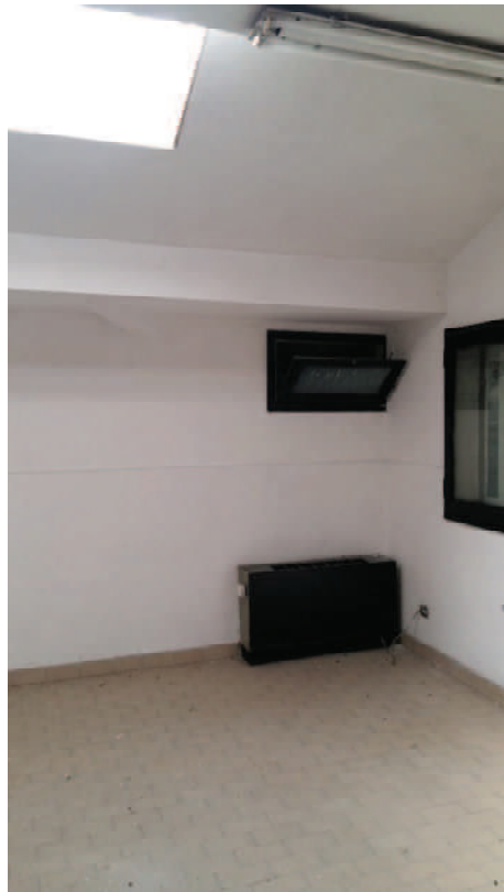
FOTO 26 – PIANO SECONDO UFFICI
