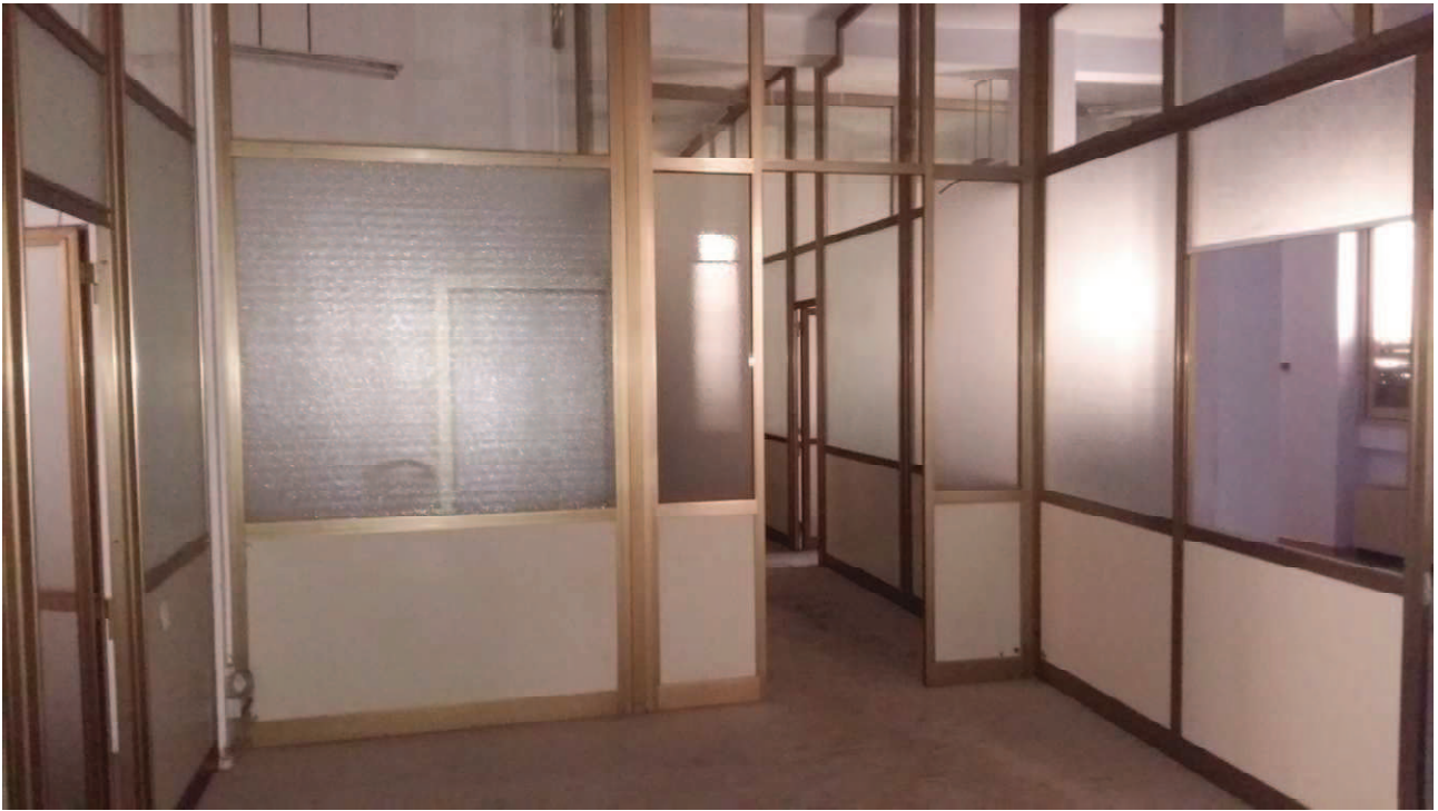
FOTO 15 – PIANO PRIMO UFFICI
