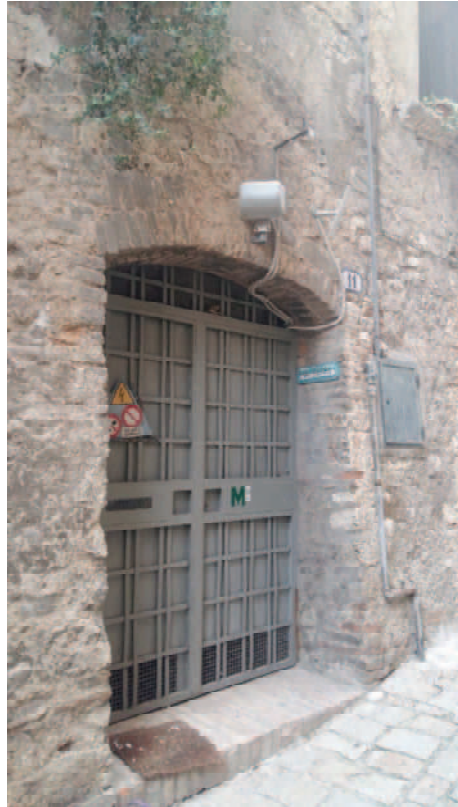
FOTO 7 – INGRESSO VIA DELLA PINCIANA N. 11 – CABINA ENEL
