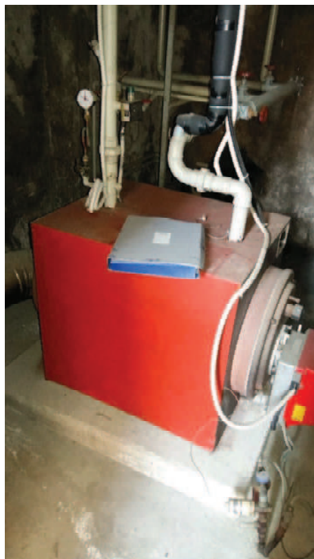
FOTO 8 – PARTICOLARE CENTRALE TERMICA
