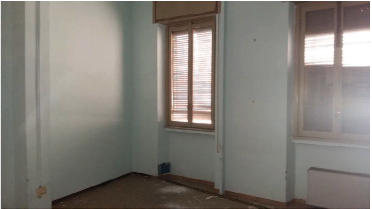
FOTO 21 – PIANO PRIMO UFFICI
