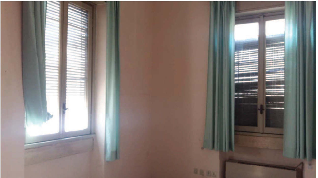
FOTO 22 – PIANO PRIMO UFFICI
