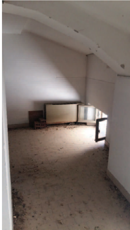
FOTO 27 – PIANO SECONDO UFFICI
