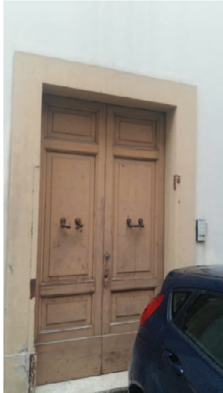
FOTO 3 – INGRESSO VIA SAFFI N. 12
