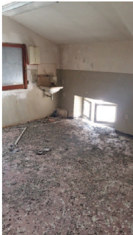
FOTO 30 – PIANO SECONDO UFFICI
