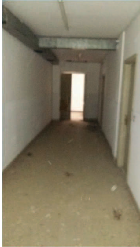
FOTO 23 – PIANO SECONDO UFFICI
