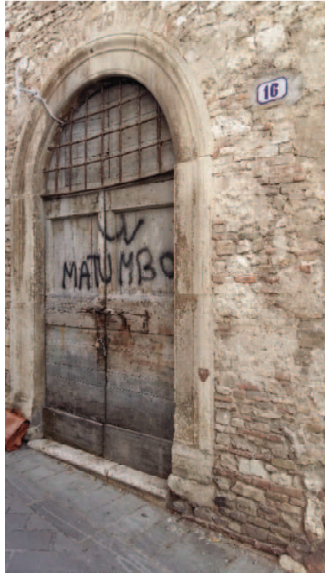
FOTO 5 – INGRESSO VIA SAFFI N. 16
