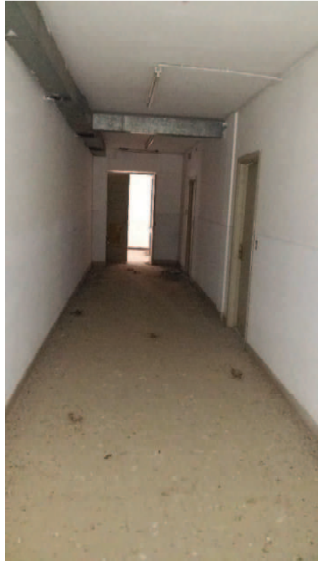
FOTO 29 – PIANO SECONDO UFFICI
