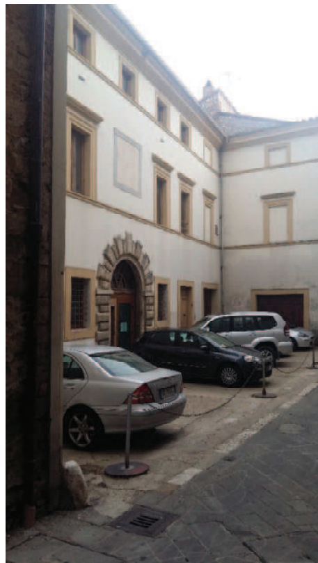
FOTO 2 – INGRESSO VIA SAFFI N. 12
