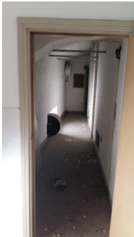
FOTO 28 – PIANO SECONDO UFFICI
