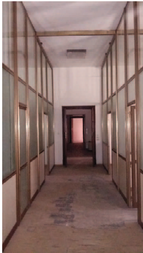
FOTO 18 – PIANO PRIMO UFFICI
