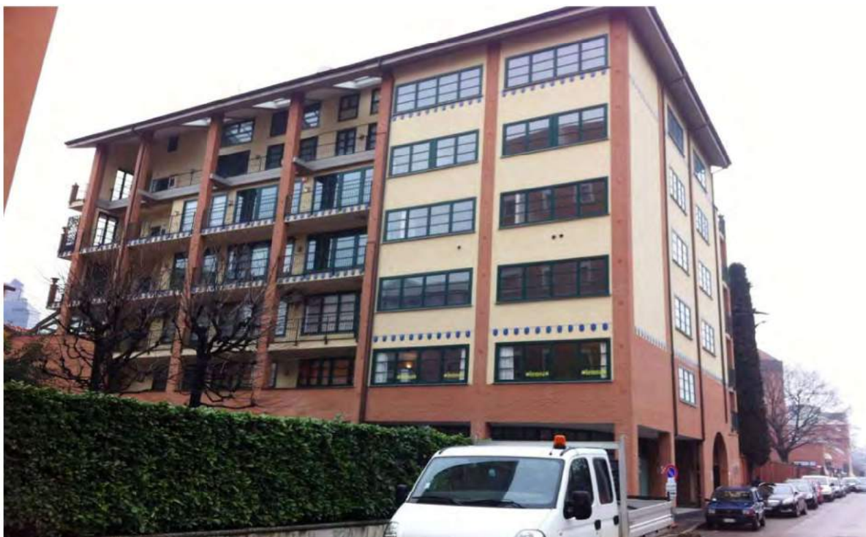
Vista dall'esterno dell'immobile
