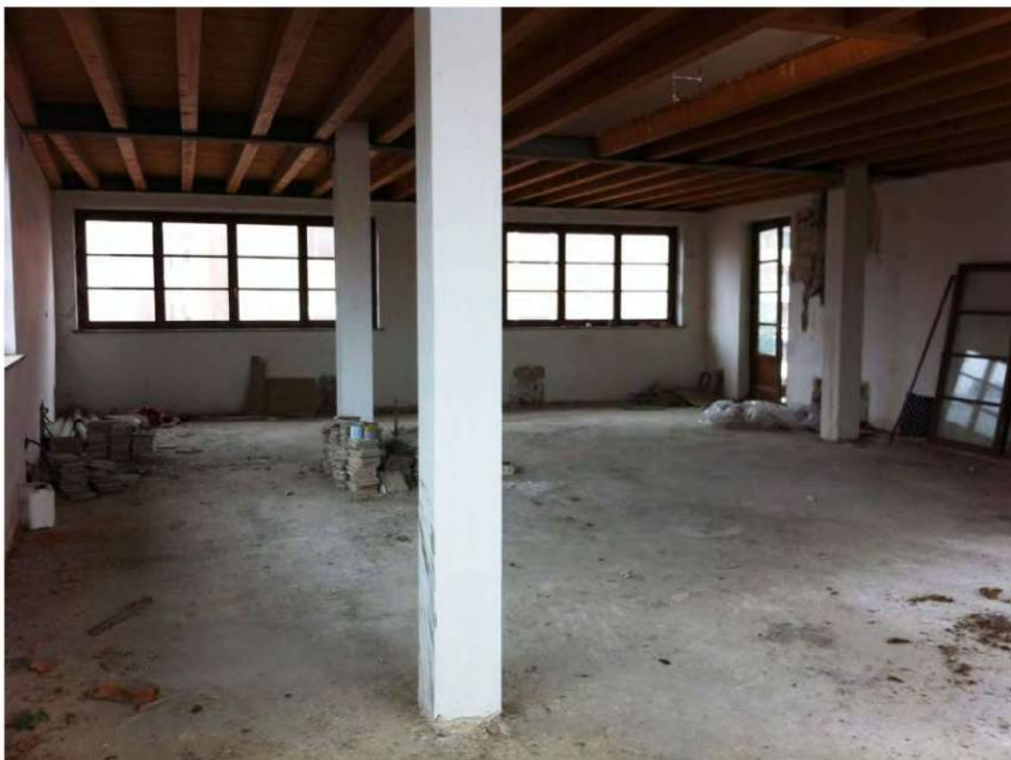
subalterno 18 il soppalco è tutta la copertura in legno
