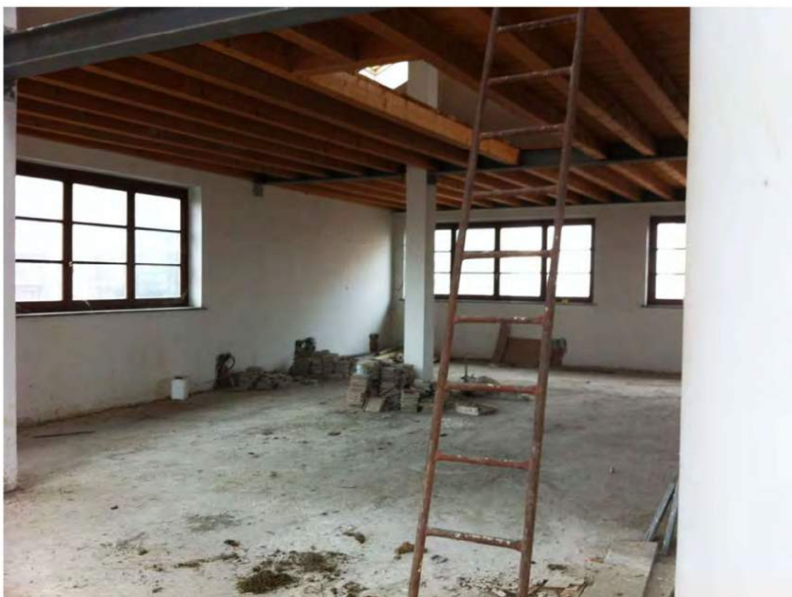
subalterno 18 il soppalco è visto da sotto in legno
