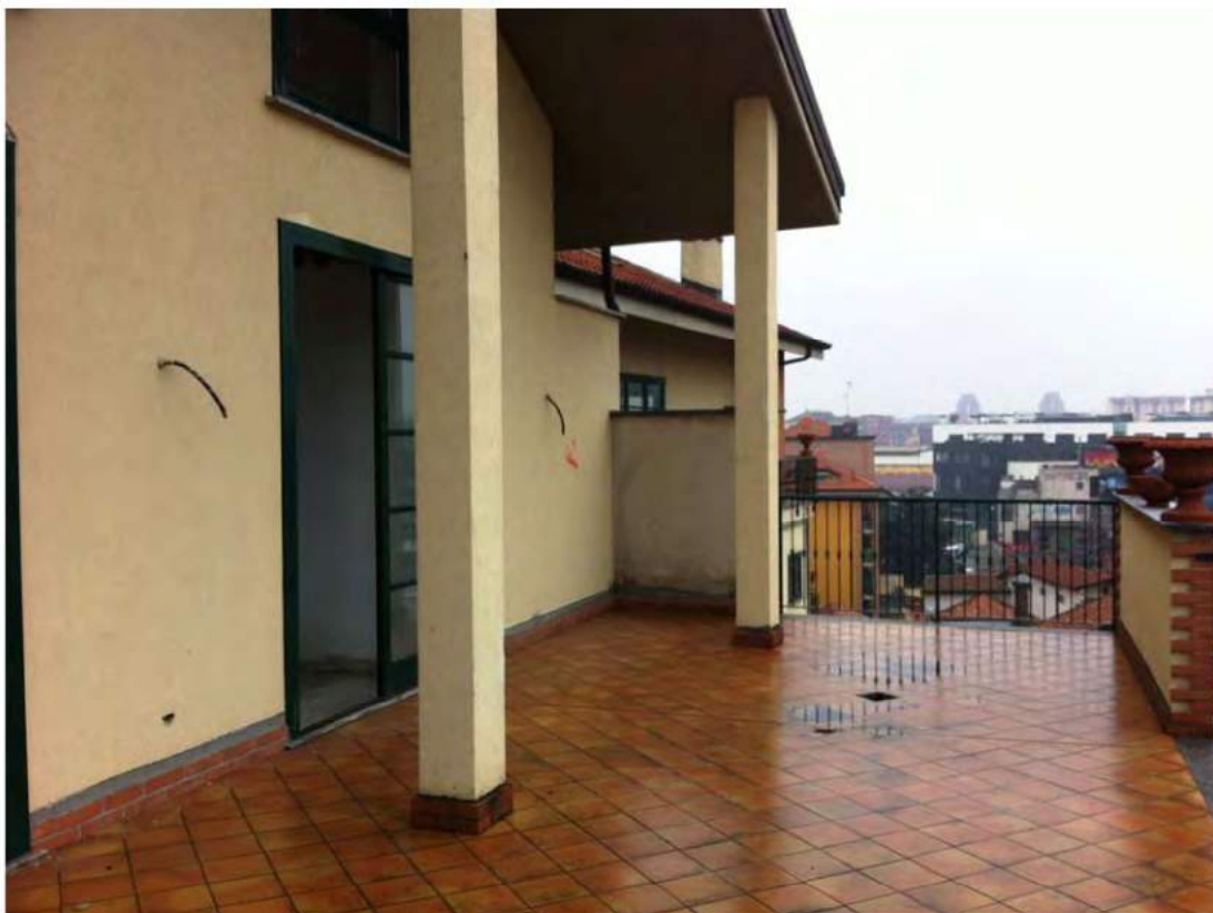
subalterno 18 balcone esclusivo (i pilastri non presenti nella pianta catastale)
