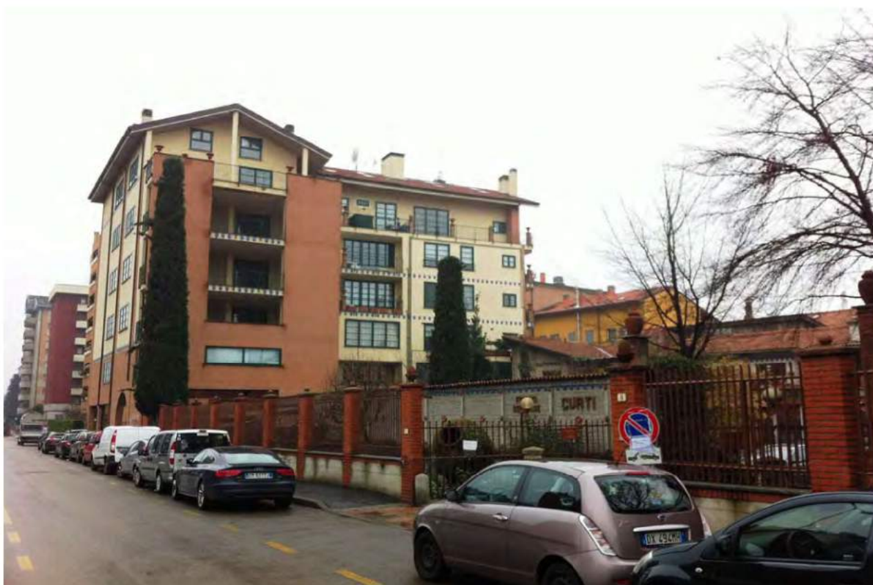
Vista dall'esterno dell'immobile
