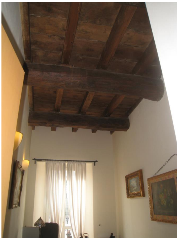
Particolare del soffitto in legno delle camere
