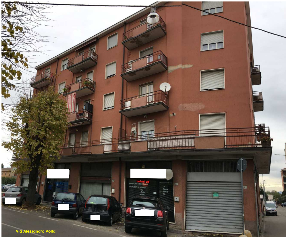
Foto nn. 1-2-3. Appartamento per civile abitazione al piano secondo con annesso locale cantina al piano S1, sito in Senago (MI), alla Via Alessandro Garrone n. 1. Palazzina condominiale, con accesso comune dal civico numero 1 di Via A. Garrone
