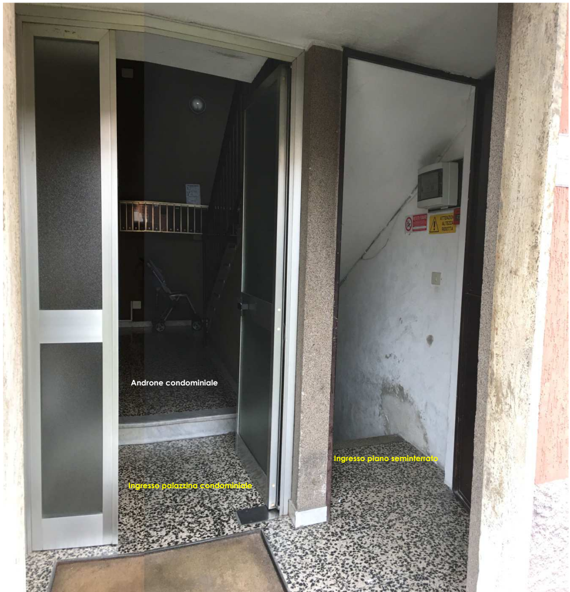
Foto n. 8. Ingresso palazzina condominiale ed ingresso piano seminterrato
