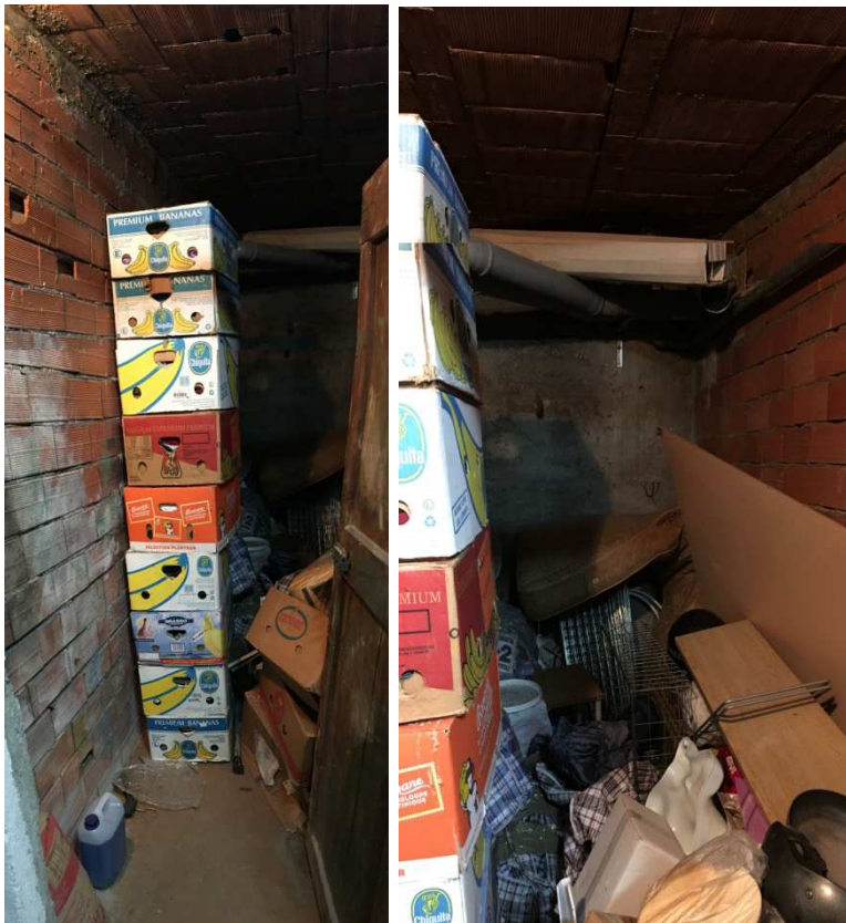
Foto nn. 25-26. Piano Seminterrato. Vano cantina
