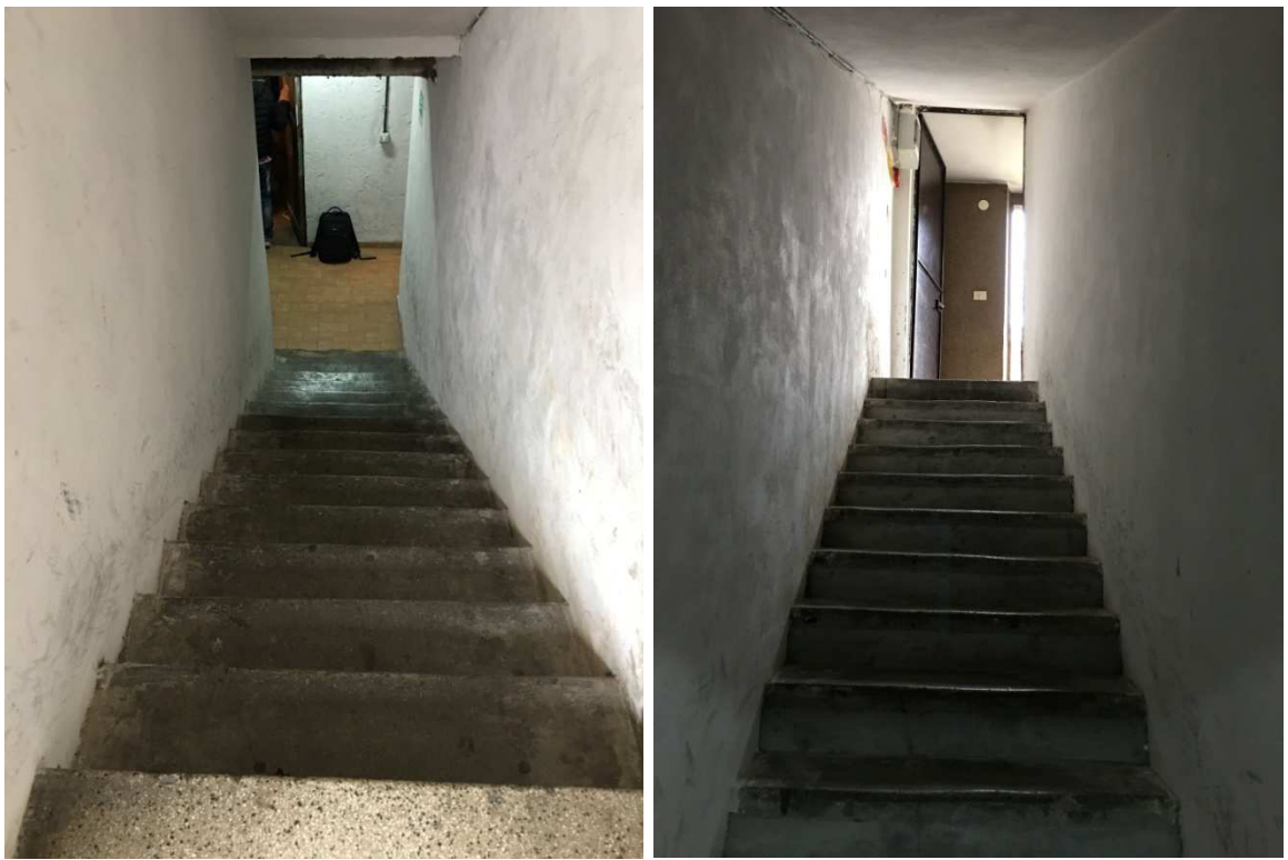
Foto nn. 21-22. Piano Seminterrato. Rampa comune
