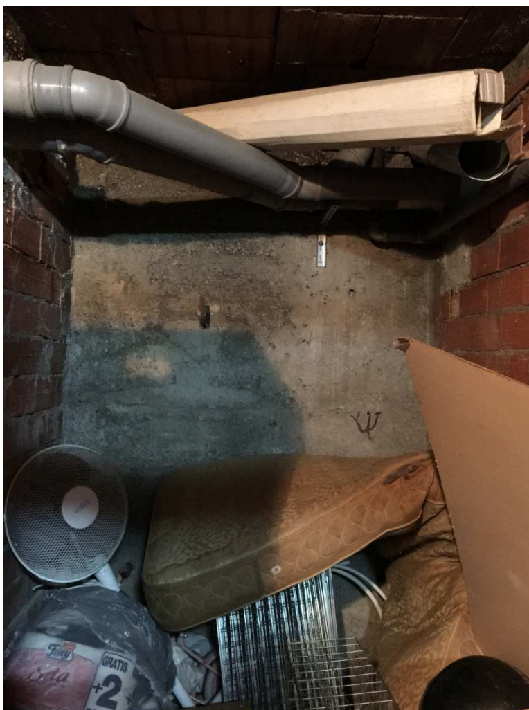
Foto n. 27. Piano Seminterrato. Vano cantina
