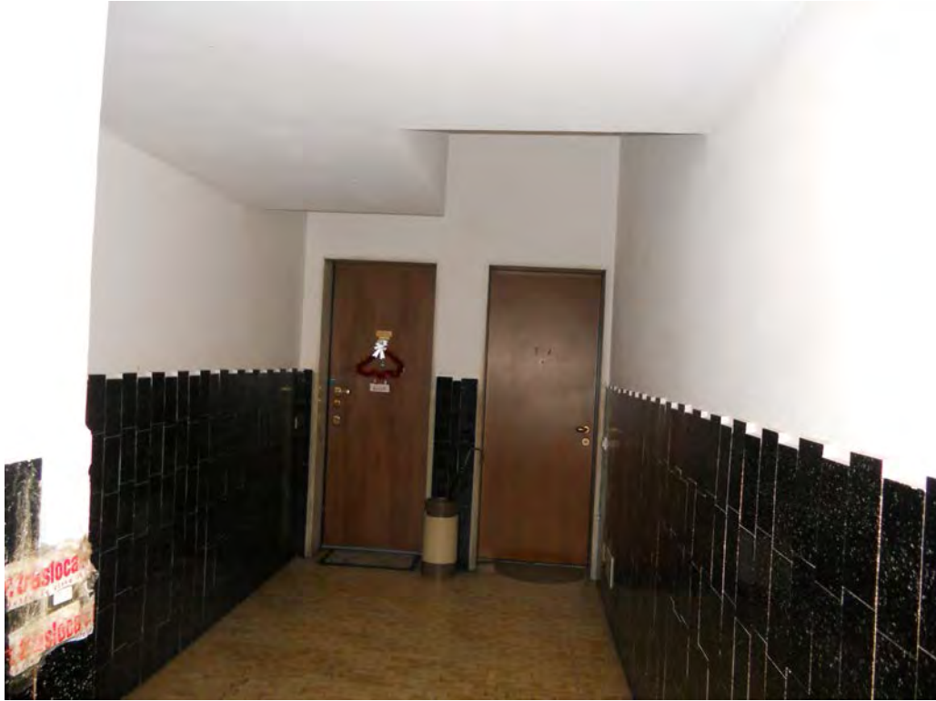
porta ingresso sub. 702-701
