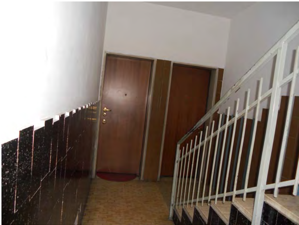
porta ingresso sub. 704-703
