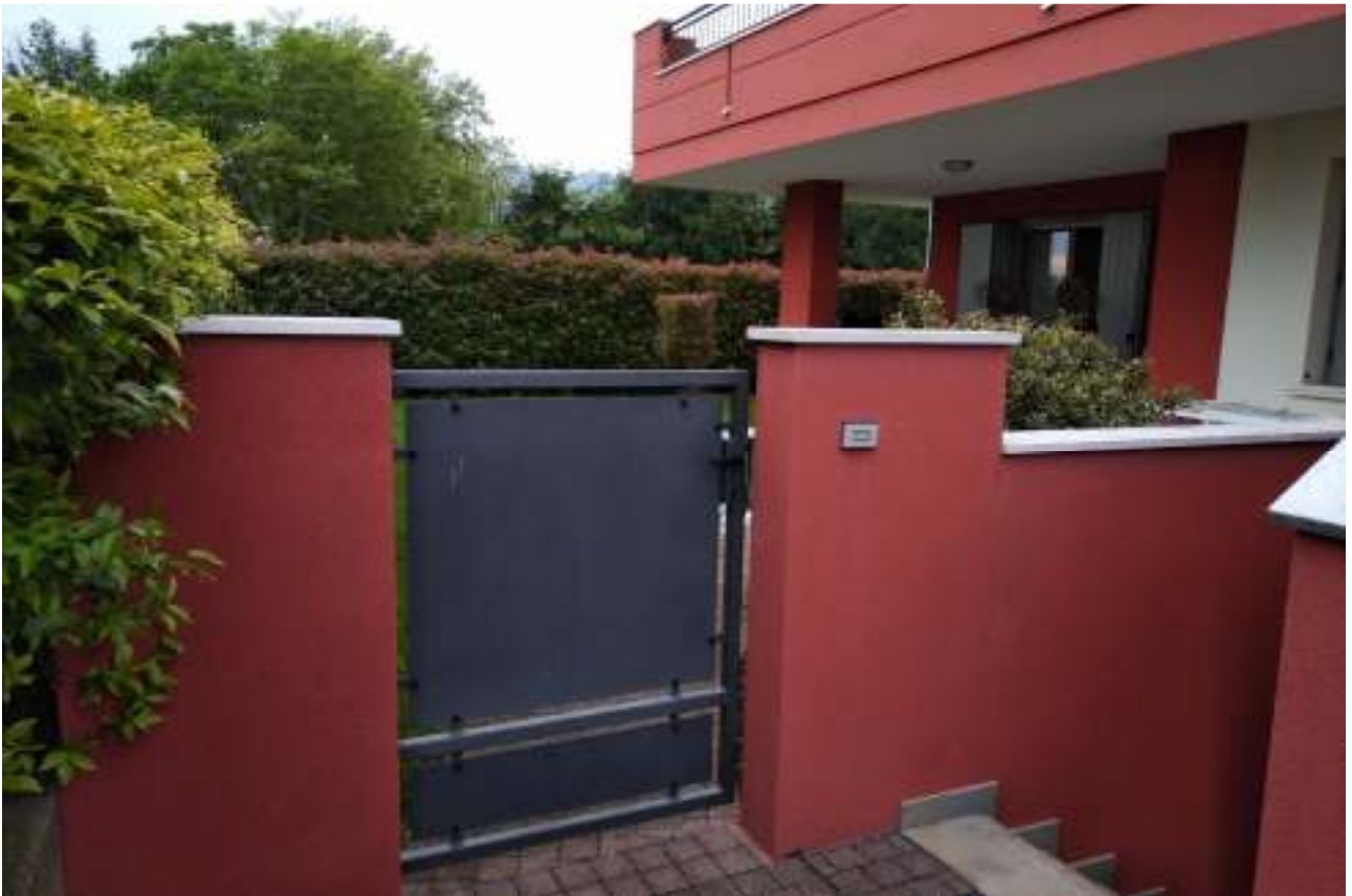
Foto n. 6 – Ingresso all'unità esecutata (interno 1).
