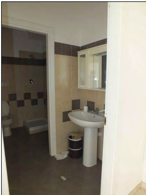
Foto n.ro 15 Anti bagno
