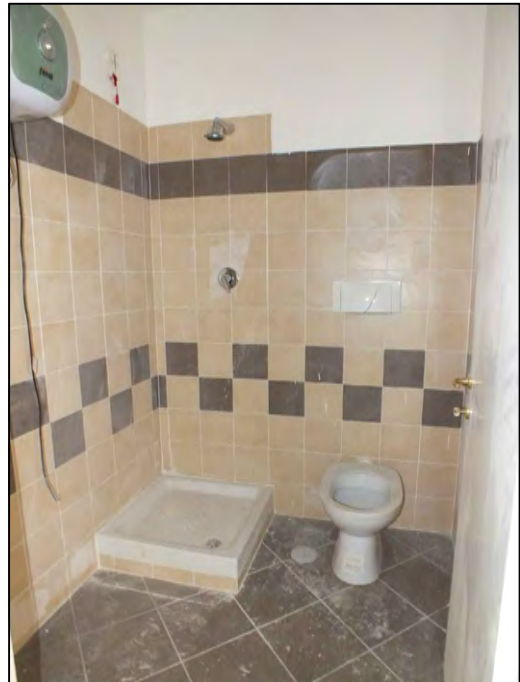
Foto n.ro 18 Bagno
