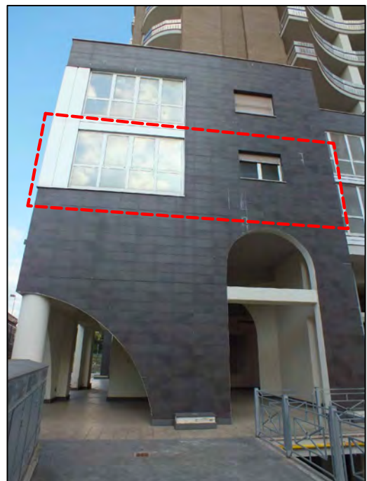
Foto n.ro 4 Prospetto Ovest
