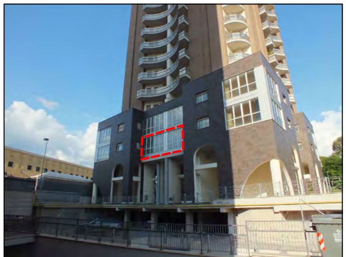
Foto n.ro 4 Prospetto Ovest
