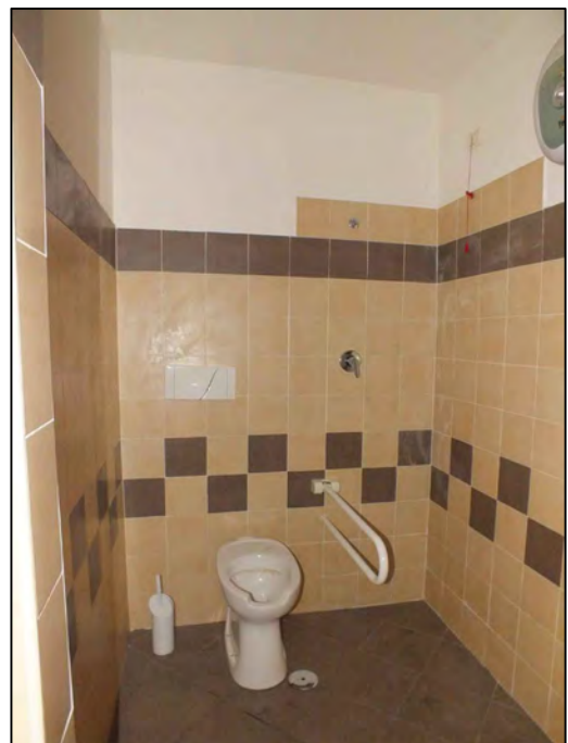
Foto n.ro 20 Bagno
