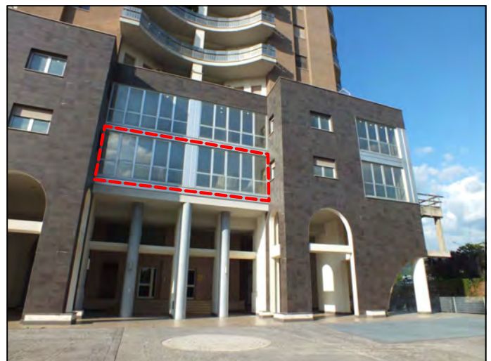
Foto n.ro 4 Prospetto Sud
