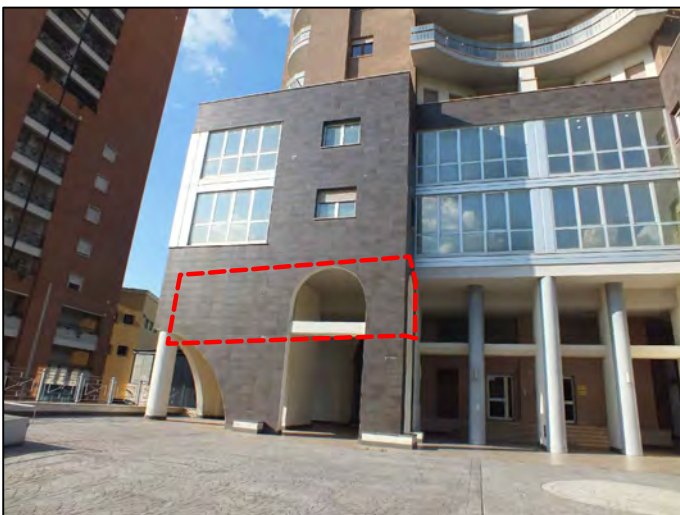
Foto n.ro 3 Prospetto Ovest
