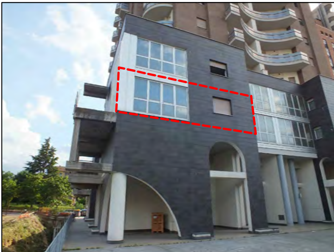
Foto n.ro 3 Prospetto Nord
