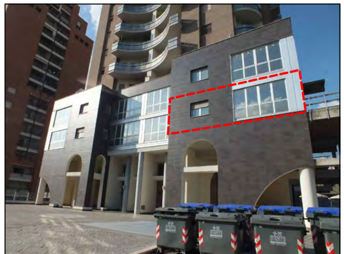
Foto n.ro 4 Prospetto Sud
