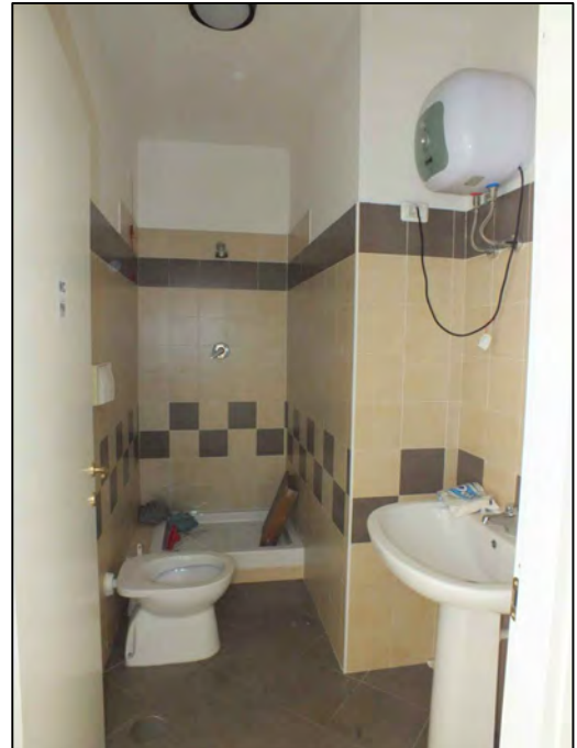
Foto n.ro 18 Bagno
