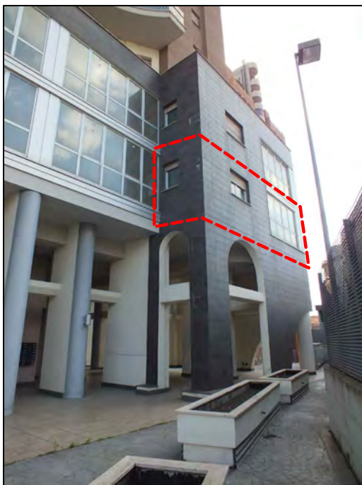
Foto n.ro 3 Prospetto Nord
