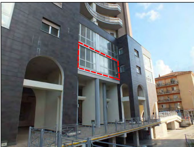
Foto n.ro 3 Prospetto Ovest
