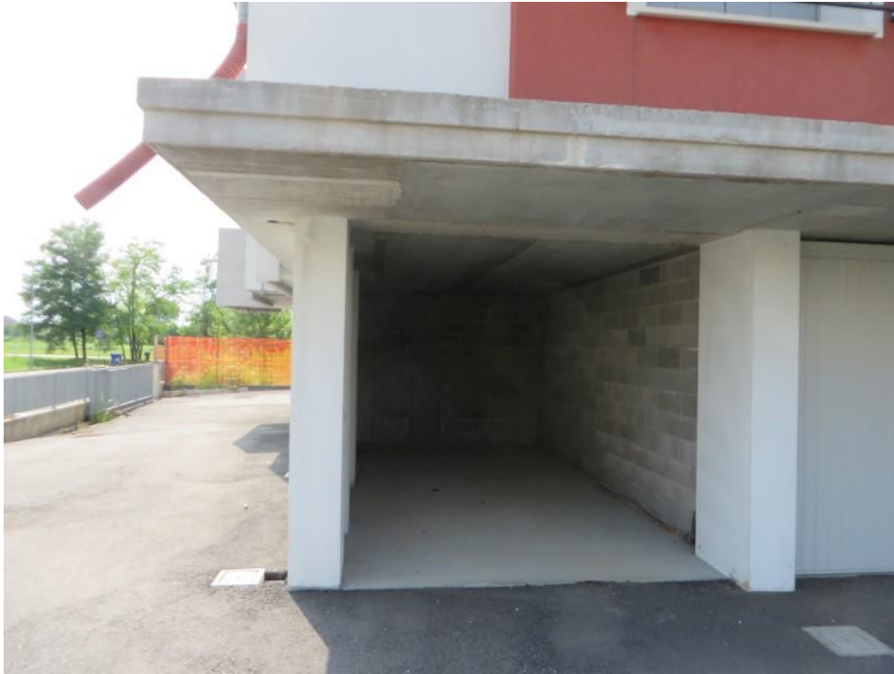
FOTO 35: GARAGE (Subalterno n. 6 – P.T.)
