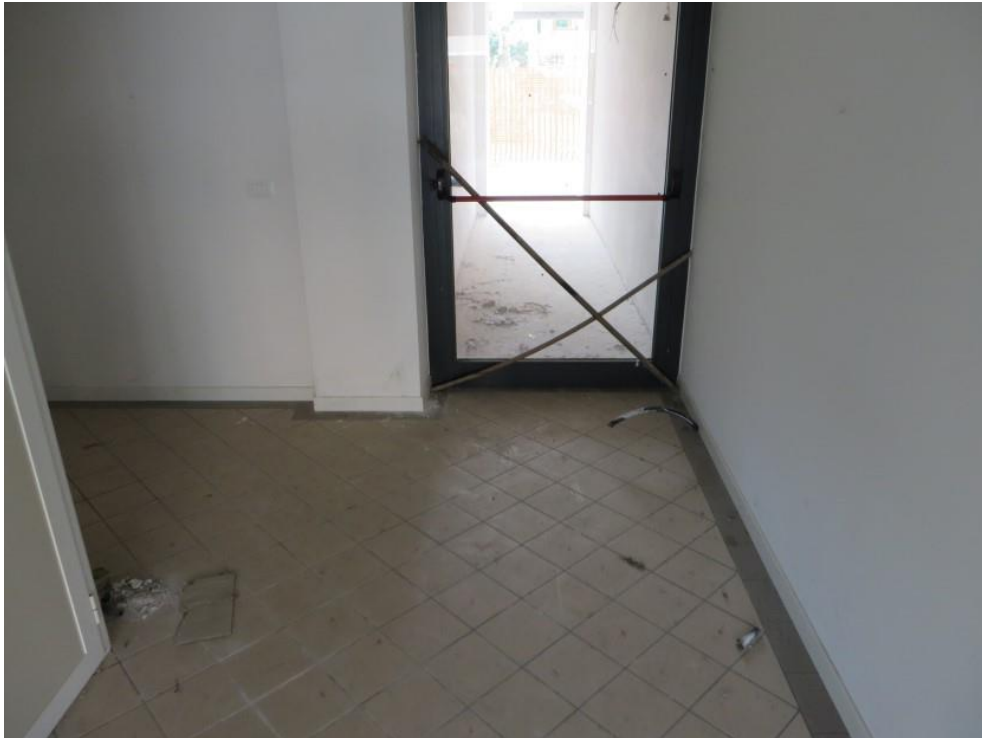
FOTO 39: PARTICOLARI VARI CONDOMINIO
