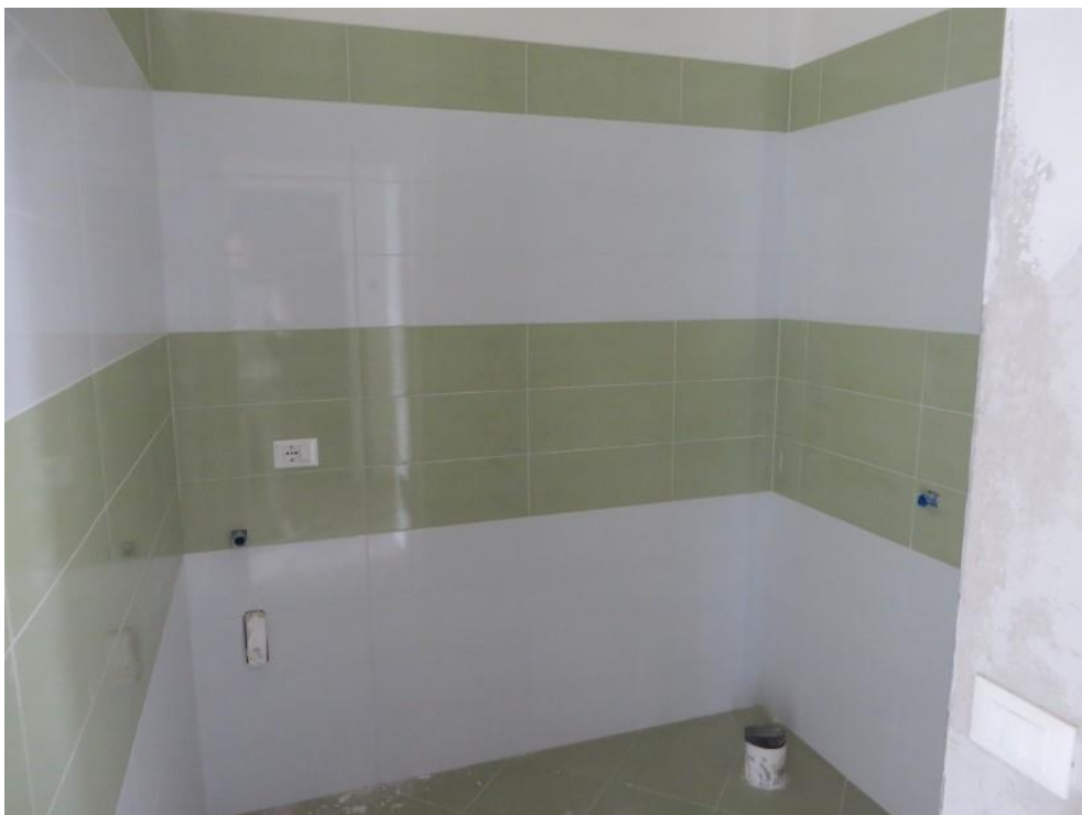
FOTO 20: RIPOSTIGLIO-BAGNO (Subalterno n. 13 – 3°P.)
