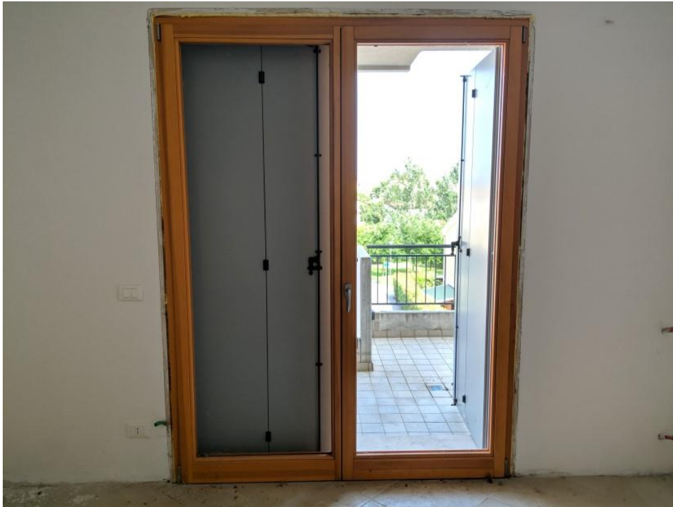
FOTO 33: PANORAMICA SERRAMENTO (Subalterno n. 13 – 3°P.)
