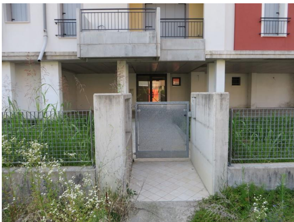
FOTO 6: ACCESSO PEDONALE DA VIA MASSIMO D'ANTONA
