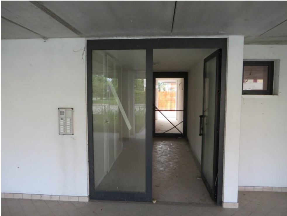
FOTO 11: PORTA D'INGRESSO DEL CONDOMINIO
