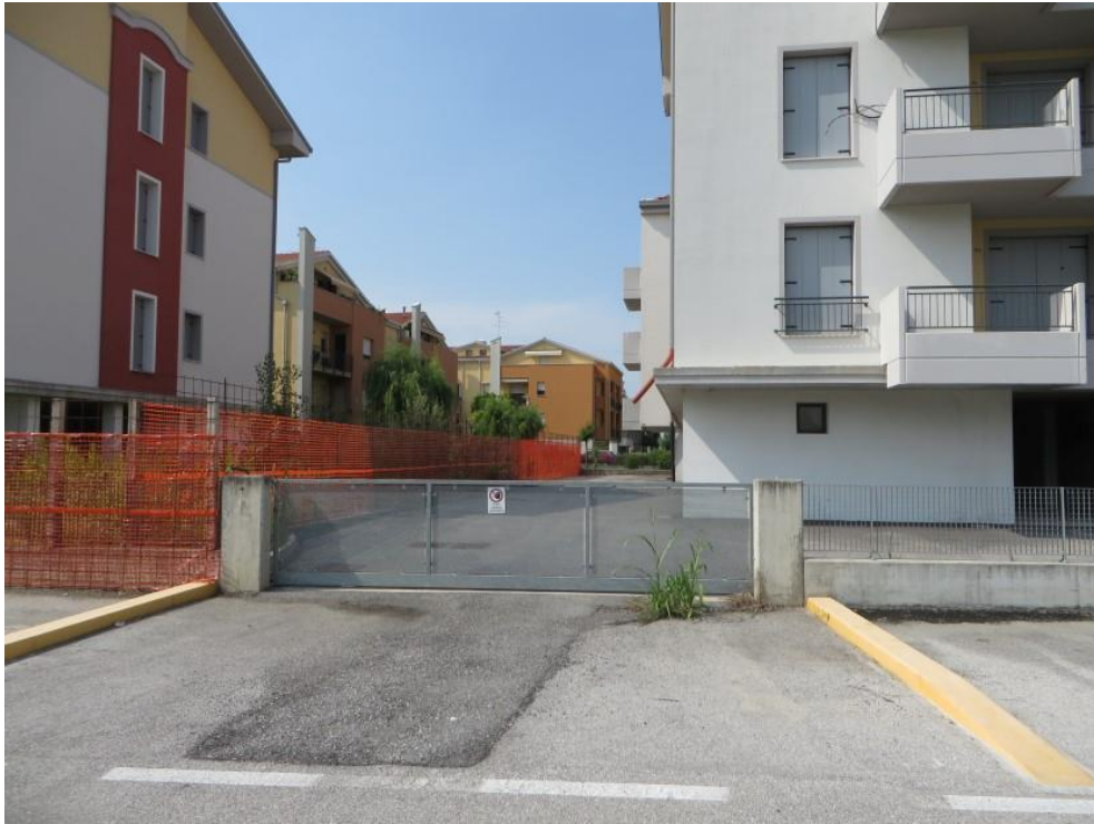
FOTO 7: ACCESSO CARRAIO DA VIA PALAZZINE
