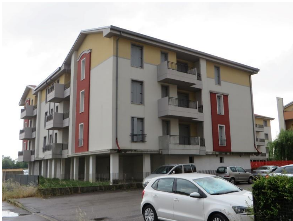
FOTO 3: ALTRA PANORAMICA CONDOMINIO CORPO C
