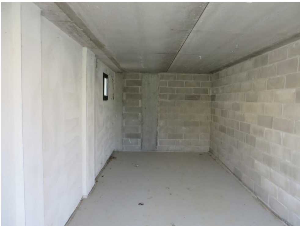
FOTO 36: GARAGE (Subalterno n. 6 – P.T.)
