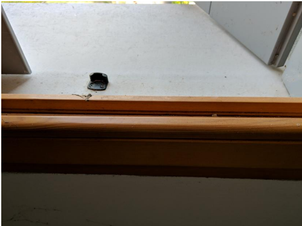
FOTO 34: PARTICOLARE SERRAMENTO (Subalterno n. 13 – 3°P.)
