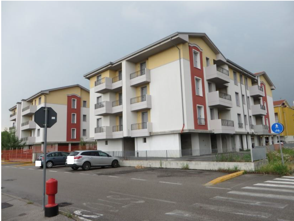
FOTO 1: PANORAMICA CORPI C (oggetto di esecuzione) e D
