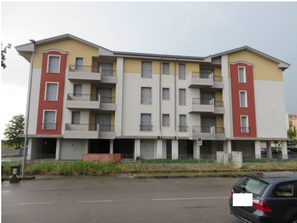
FOTO 2: PANORAMICA CONDOMINIO CORPO C
