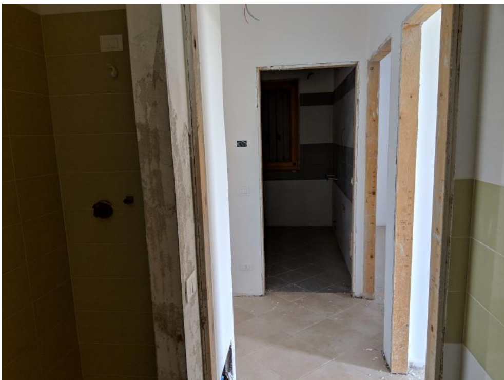
FOTO 18: DISIMPEGNO (Subalterno n. 13 – 3°P.)
