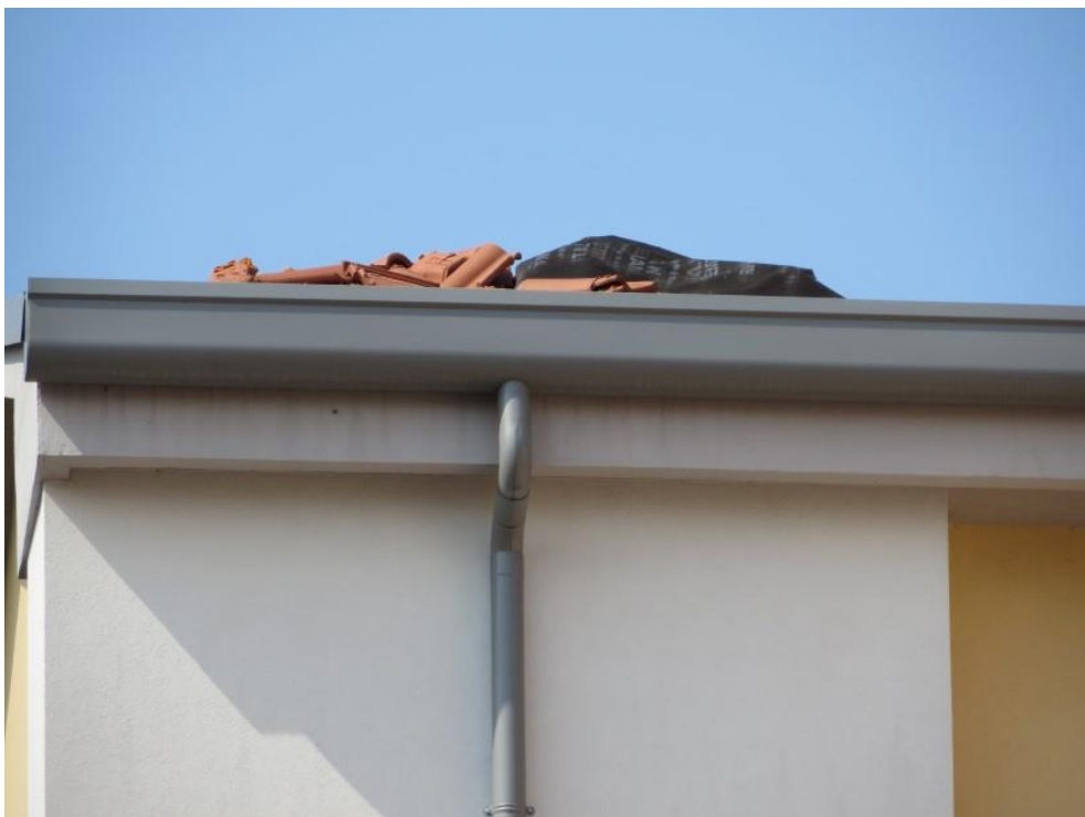
FOTO 42: PARTICOLARE COPERTURA DEL CONDOMINIO
