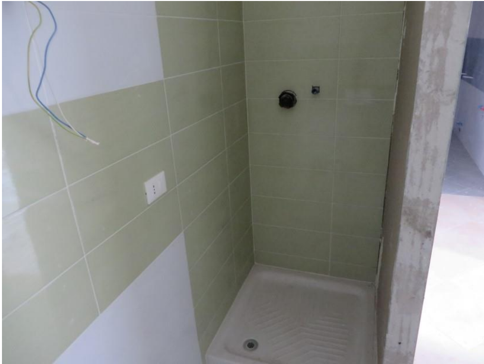
FOTO 21: RIPOSTIGLIO-BAGNO (Subalterno n. 13 – 3°P.)
