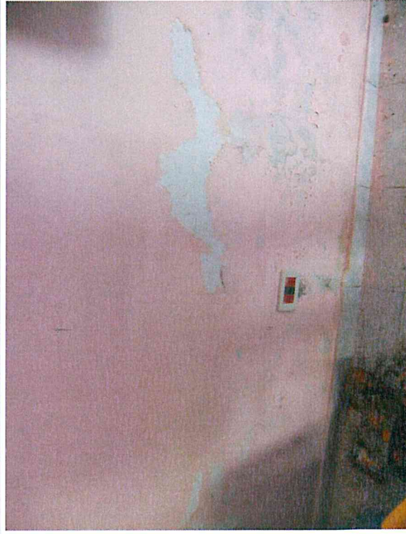
Unità immobiliare oggetto di stima: particolare intonaci
