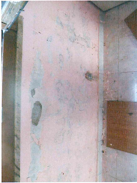
Unità immobiliare oggetto di stima: particolare intonaci
