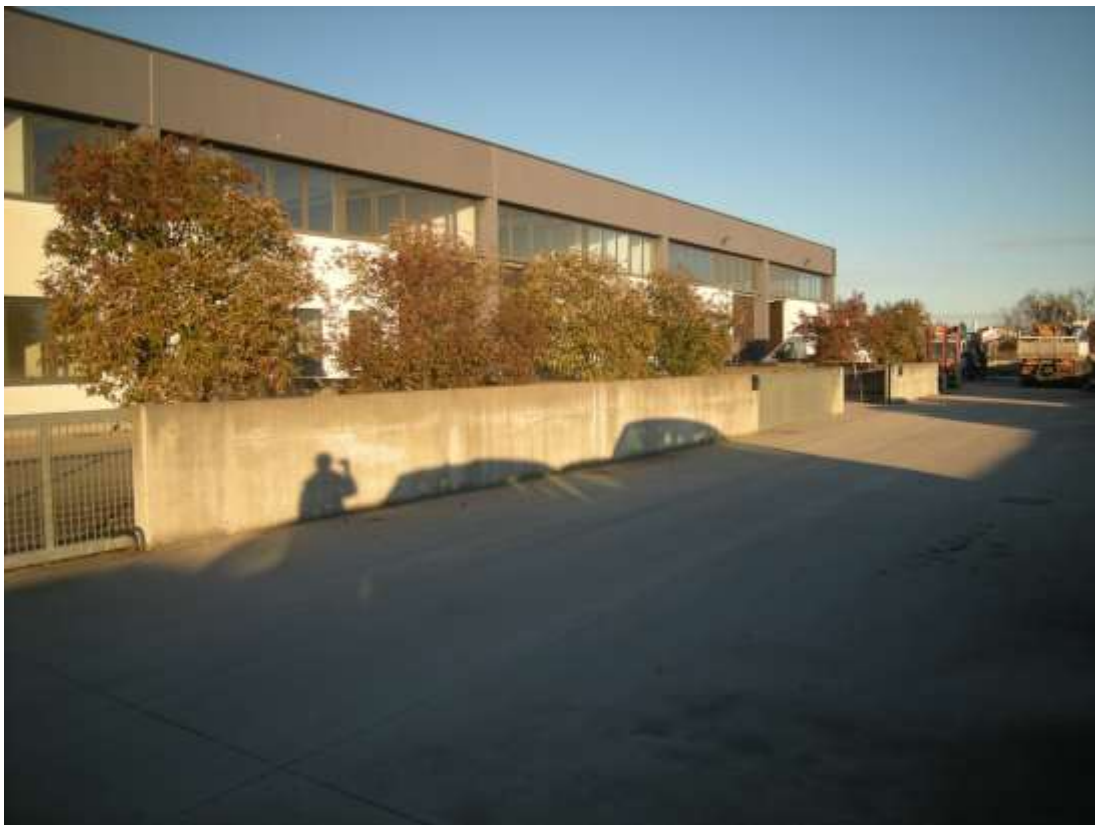
Concordia Sagittaria, foglio 5 particella 930 - Il prospetto sud del fabbricato artigianale e lo scoperto - area di manovra comune ai sub. 3, 5, 6, 7, 8, 9, 10, 11.
