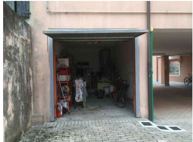
Veduta autorimessa (sub 11)
