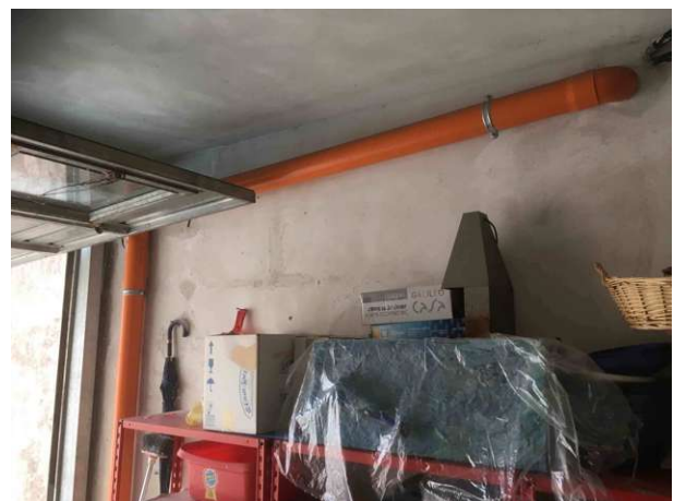
Particolare servitù scarico (sub 11)
