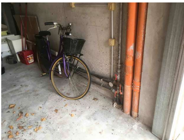
Particolare servitù scarico (sub 11)
