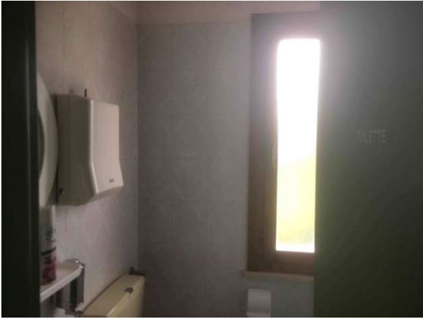
Veduta wc (sub 12)
