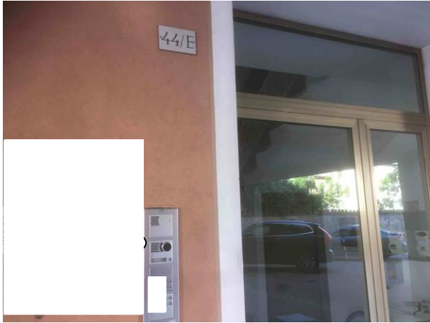
Veduta esterna accesso da civico 44/E
