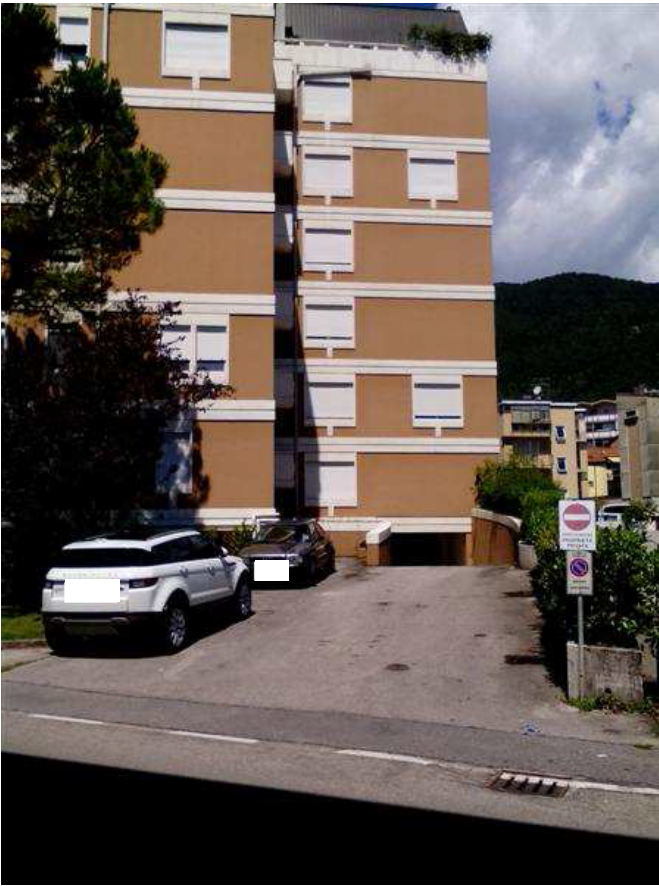
1) Rampa di accesso ai garages da via E. De Amicis
