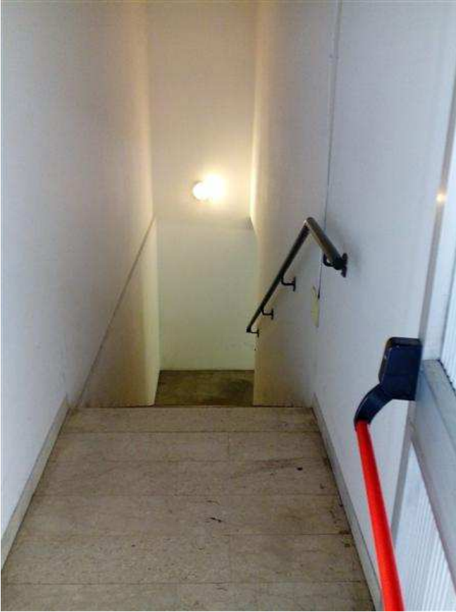
3) Scala afferente al piano seminterrato
