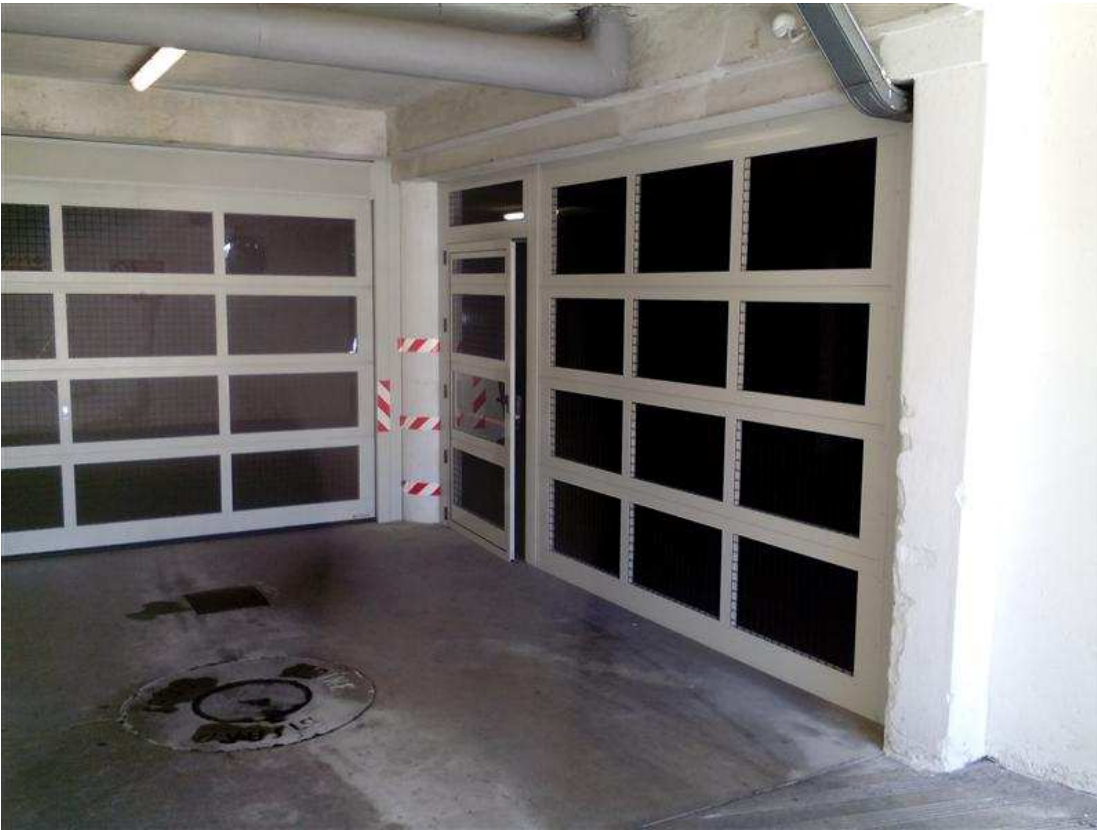
5) Portone di ingresso ai garages al piano seminterrato
