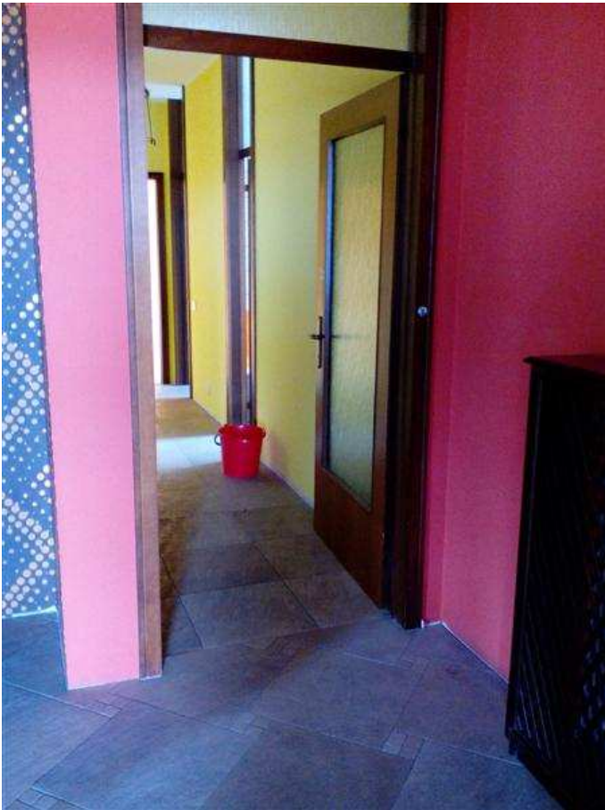
69) Accesso al disimpegno dall'ingresso
