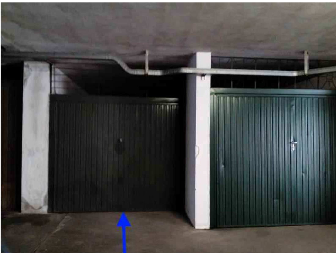
8) Portone di ingresso al garage pignorato
