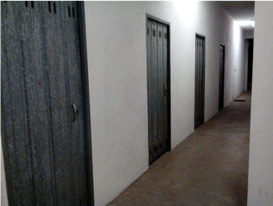
7) Veduta del corridoio comune e della cantina pignorata
