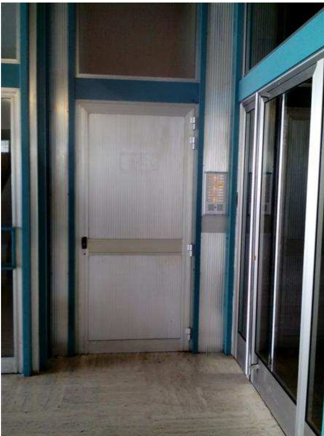
2) Porta di accesso alle cantine site al piano seminterrato
