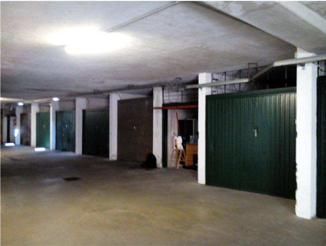
9) Vedute del garage
