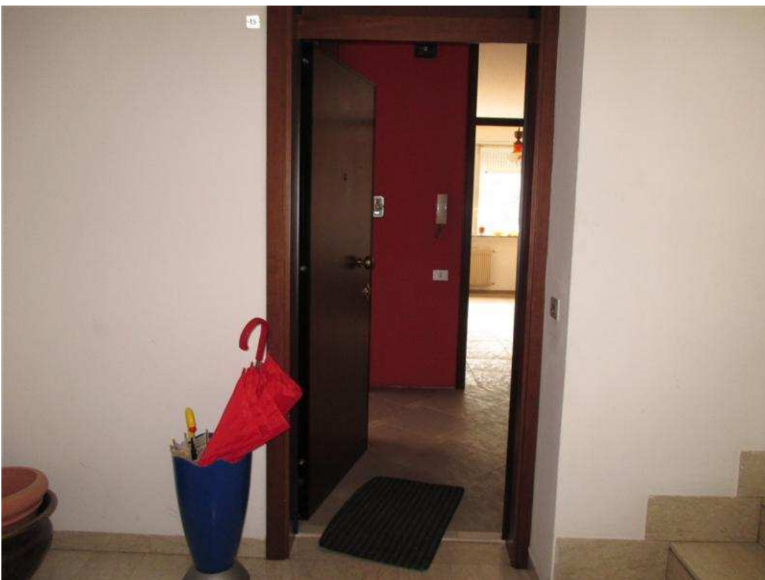
2) Portoncino di ingresso all'abitazione
