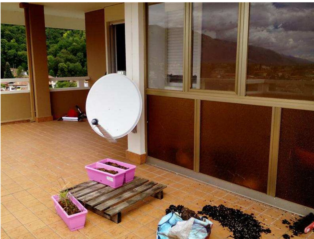
36) Particolare terrazzo e veranda
