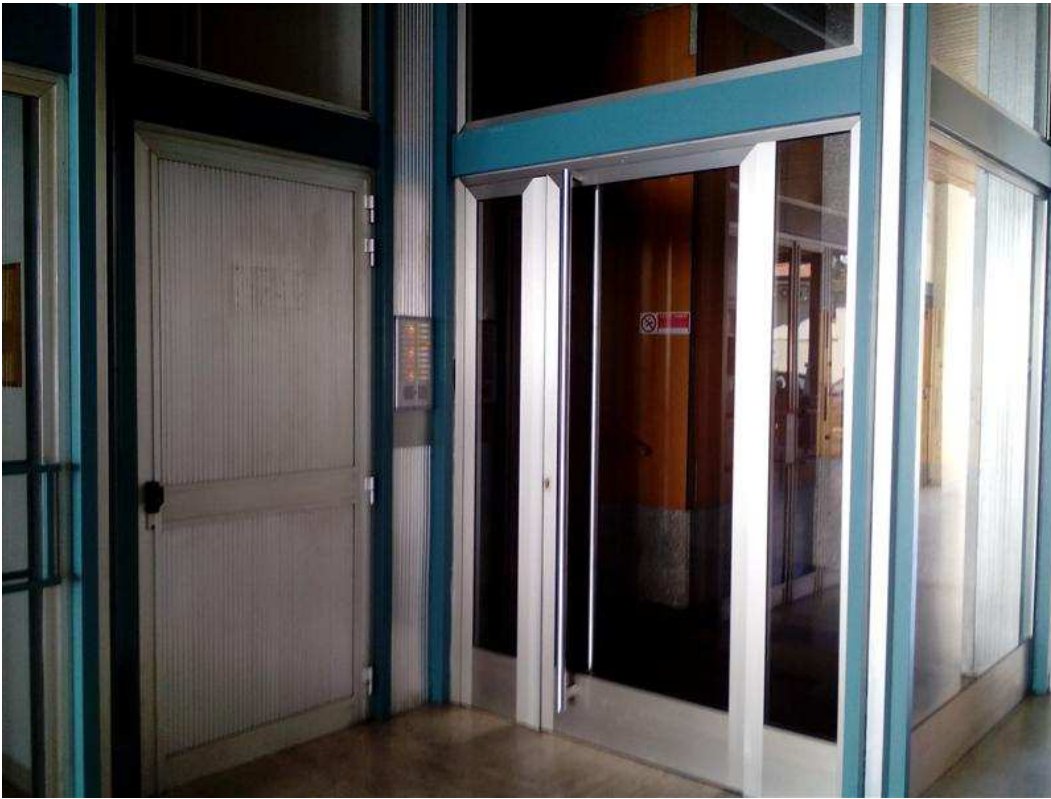
1) Atrio di ingresso al fabbricato
