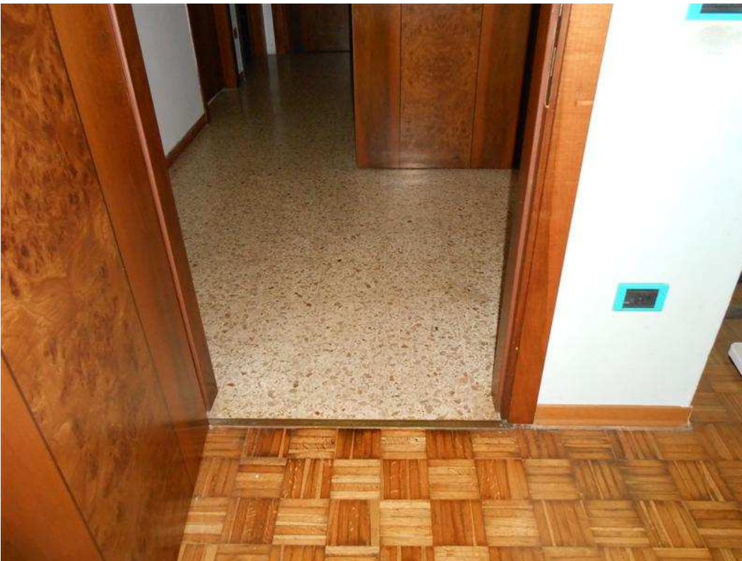
56) Particolare camera 1 e disimpegno
