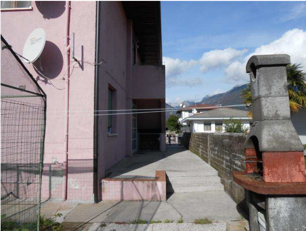
17) Veduta dell'area scoperta comune sul fronte est del fabbricato
