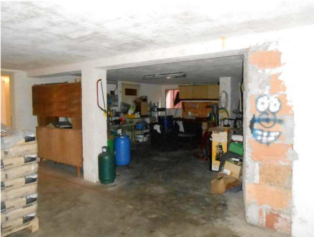
21) Veduta del locale
