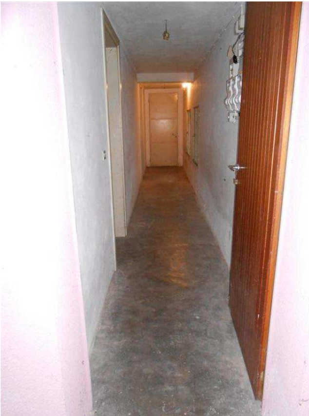
8) Veduta del corridoio
