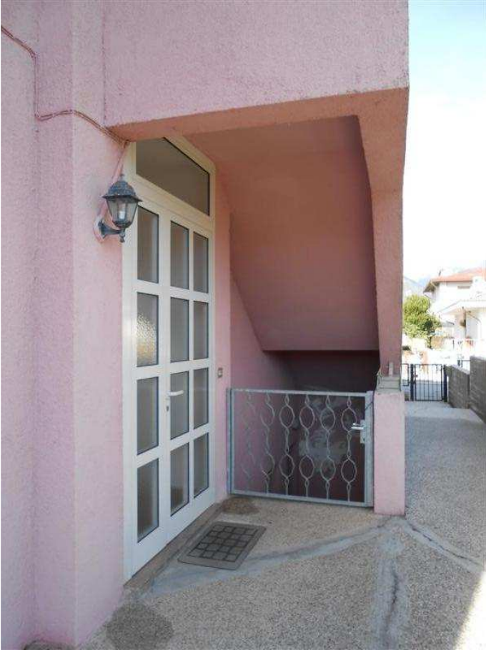
1) Portoncino di ingresso all'abitazione
