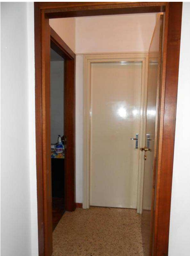
82) Porta di accesso al bagno 2 dal disimpegno
