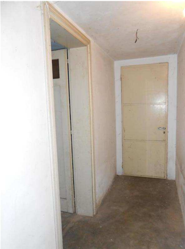
12) Porta di ingresso alla cantina (a sx)
