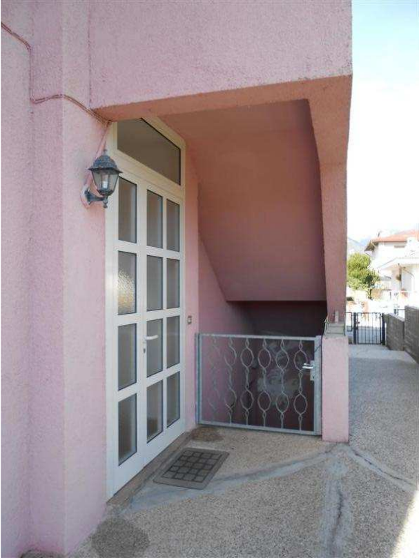
1) Accesso alla scala afferente al piano seminterrato
