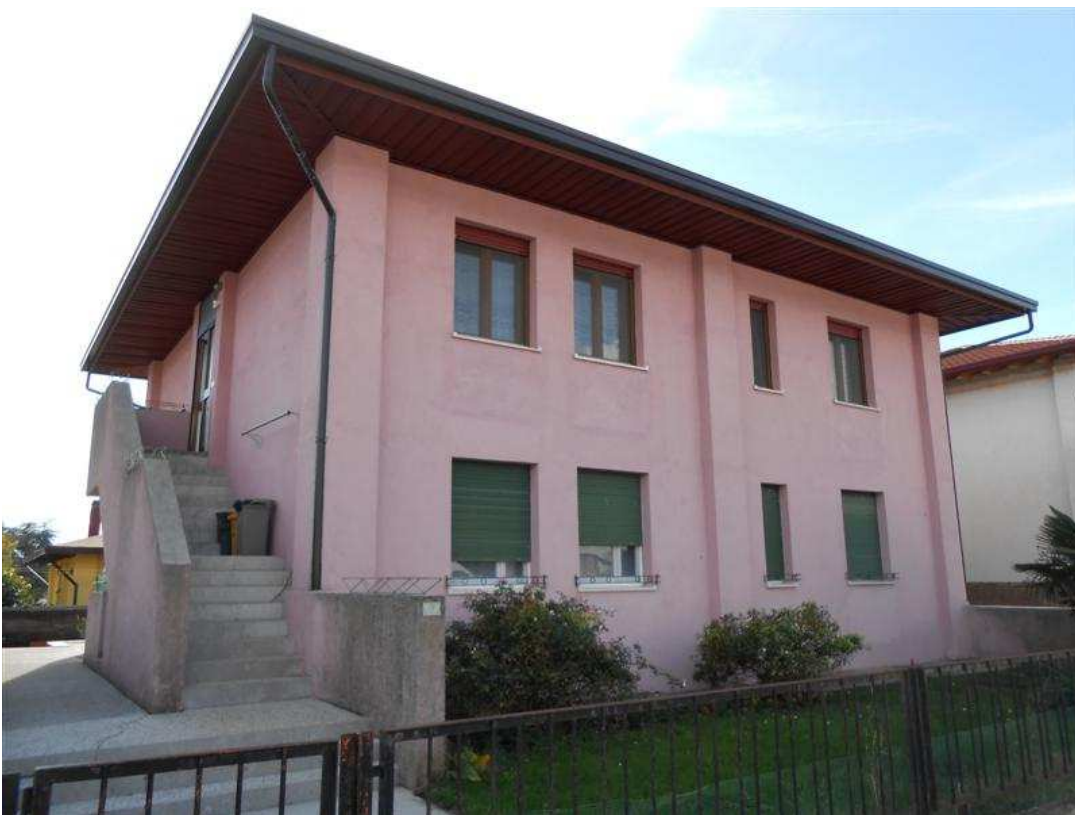
6) Veduta del fronte nord del fabbricato da via Sciavalle
