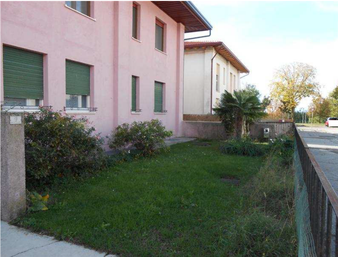
9) Veduta e particolare dell'area scoperta comune sul fronte nord
