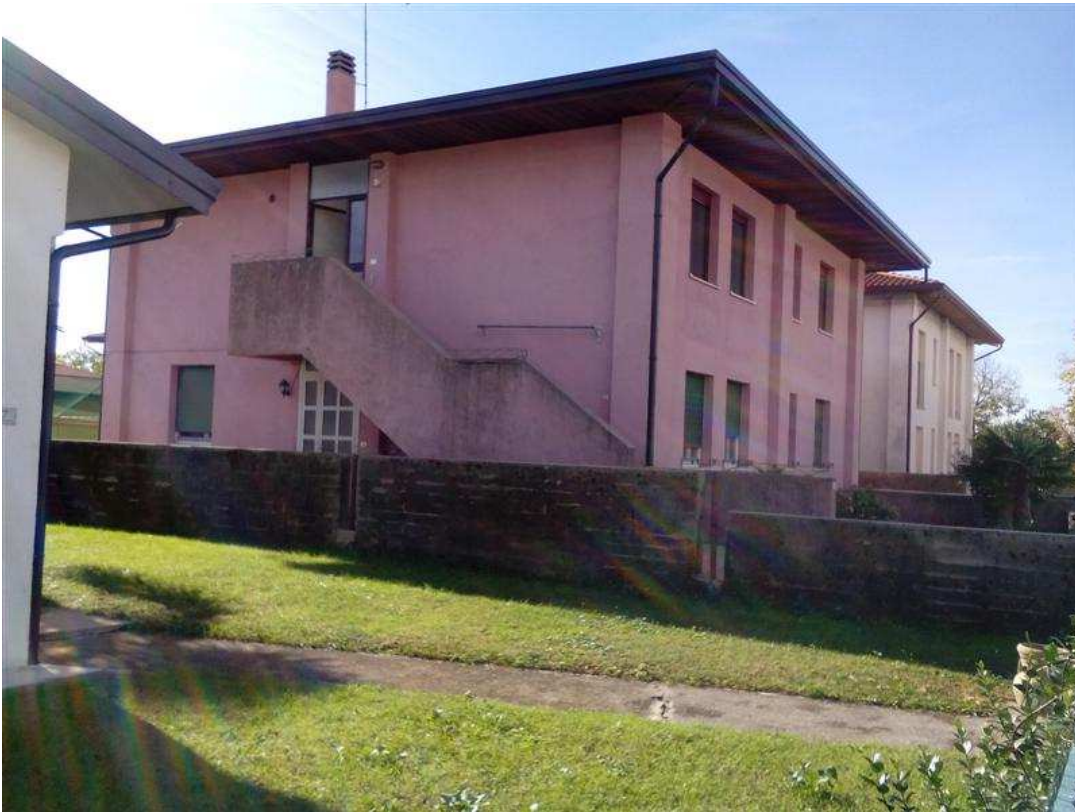
5) Veduta del fronte est del fabbricato da via Sciavalle
