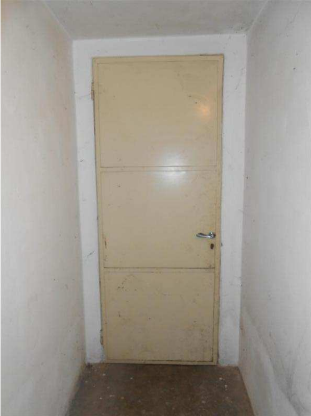
17) Ingresso al locale centrale termica
