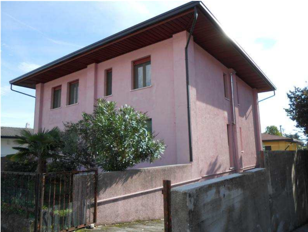
25) Ingresso alla rampa afferente al piano seminterrato, da via Sciavalle
