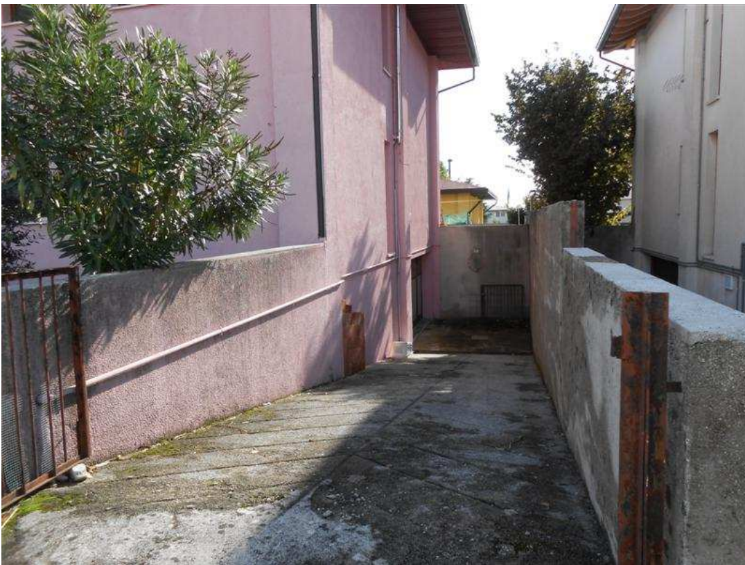
26) Veduta della rampa comune antistante il fonte ovest del fabbricato
