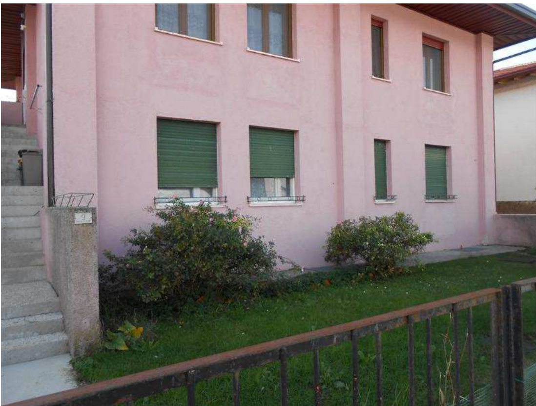
8) Veduta del fronte nord del fabbricato
