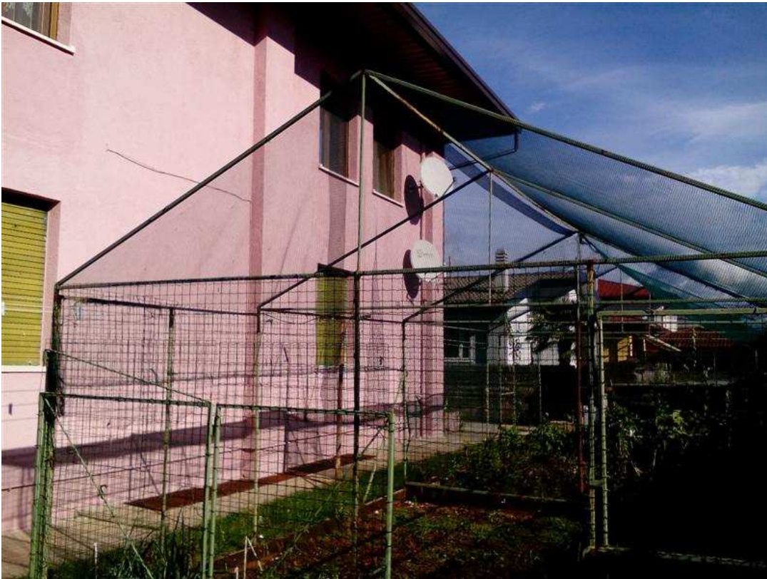
23) Vedute del fronte sud del fabbricato e dell'area scoperta comune antistante
