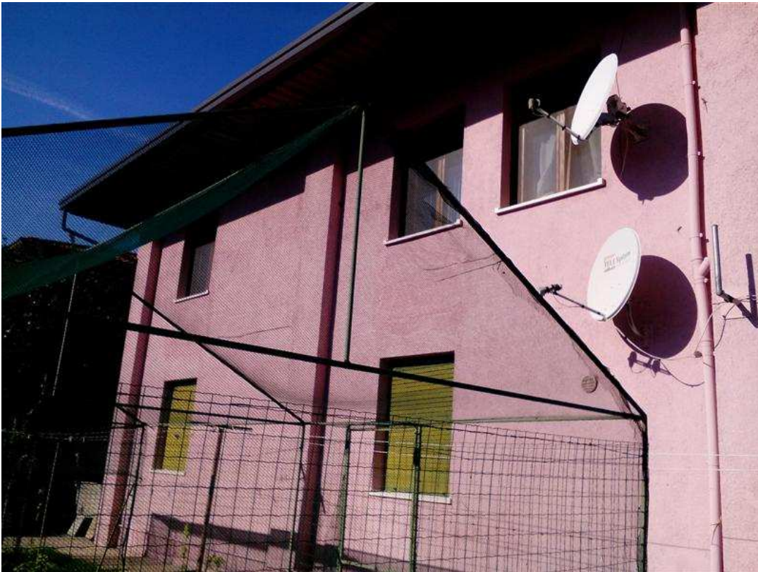
21) Vedute del fronte sud del fabbricato e dell'area scoperta comune antistante
