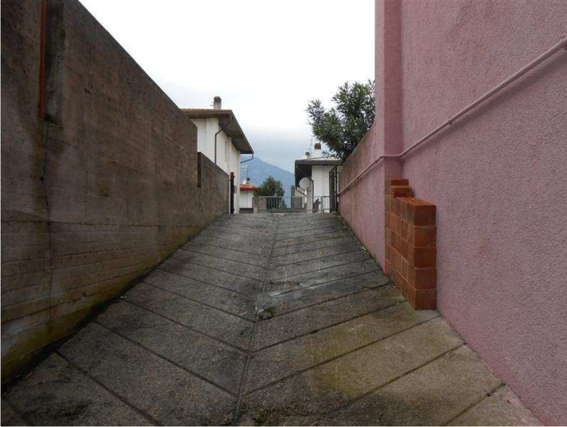
3) Particolare della rampa; in alto, via Sciavalle
