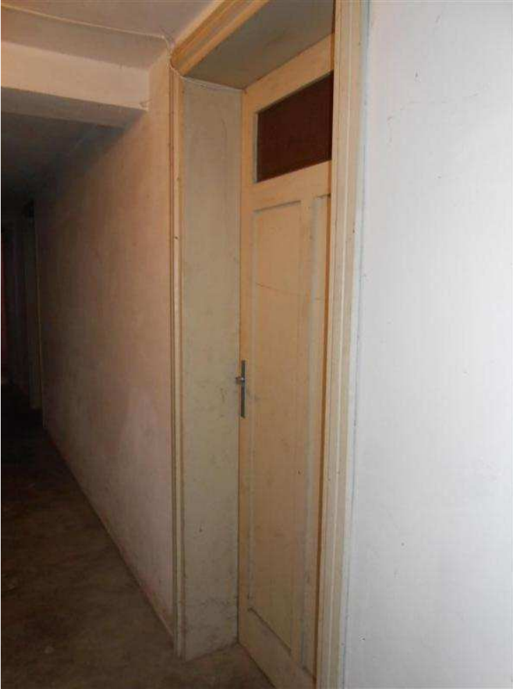
13) Particolare di porta di ingresso alla cantina
