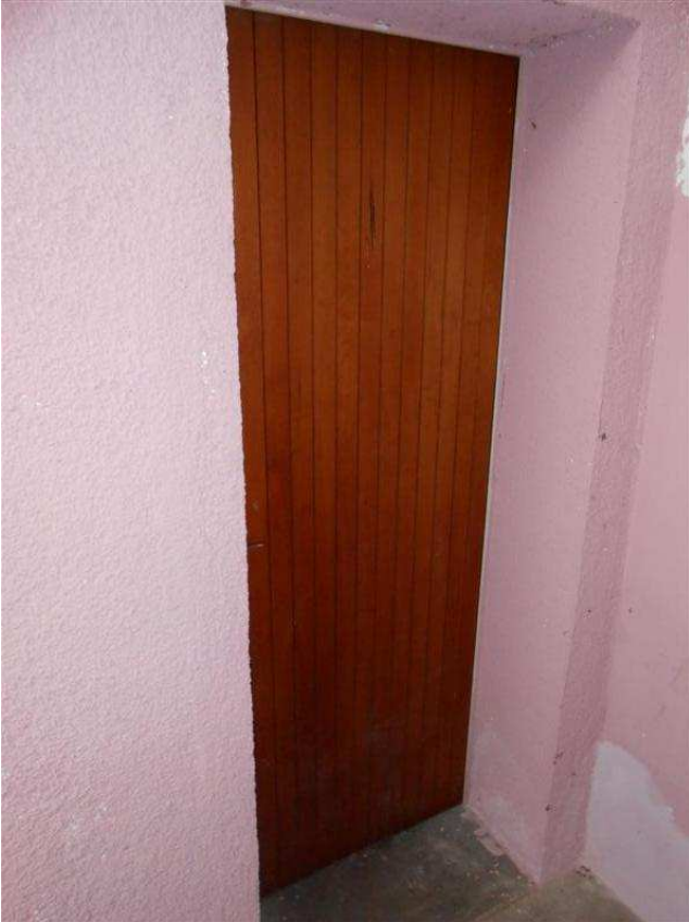
7) Portoncino di ingresso al corridoio
