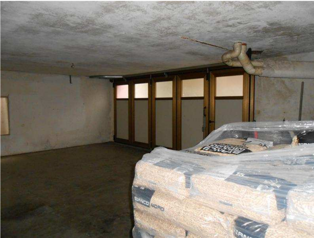
15) Vedute del locale e del portone di ingresso dalla rampa
