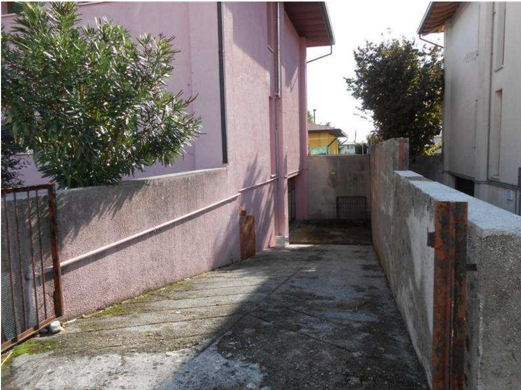
2) Rampa di accesso al piano seminterrato
