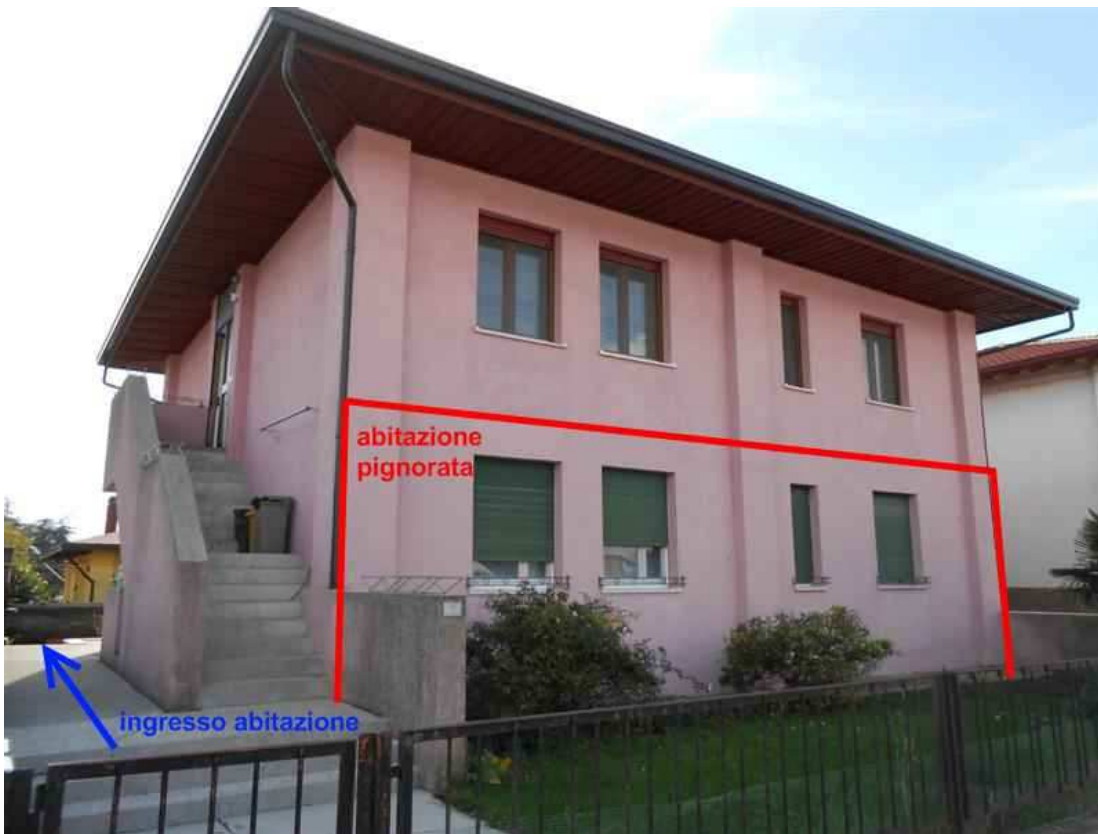
3) Vedute del fabbricato e degli ingressi
