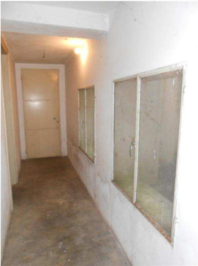
15) Veduta del corridoio
