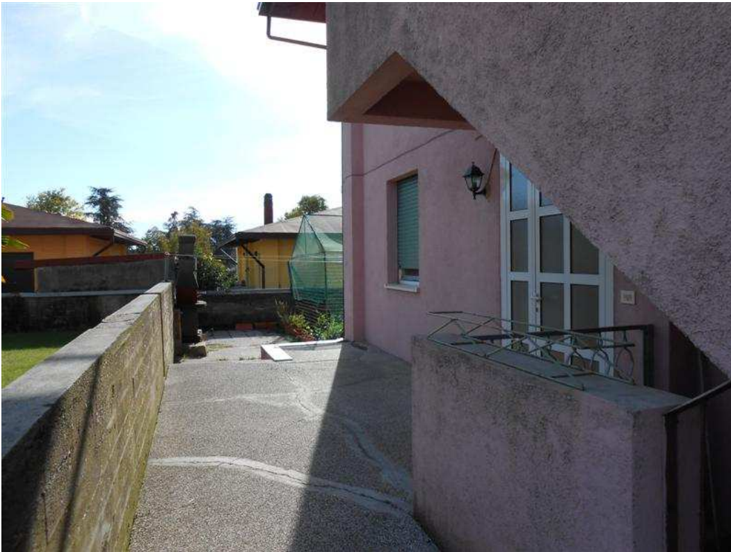
15) Area scoperta comune antistante il fronte est del fabbricato
