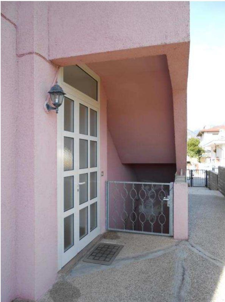
9) Scala di accesso al piano seminterrato
