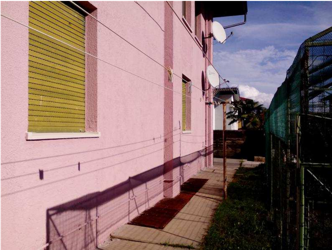
19) Vedute del fronte sud del fabbricato e dell'area scoperta comune antistante
