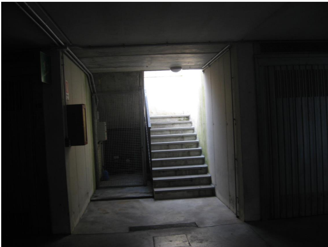
La scala di sicurezza d'uscita dall'area di manovra
