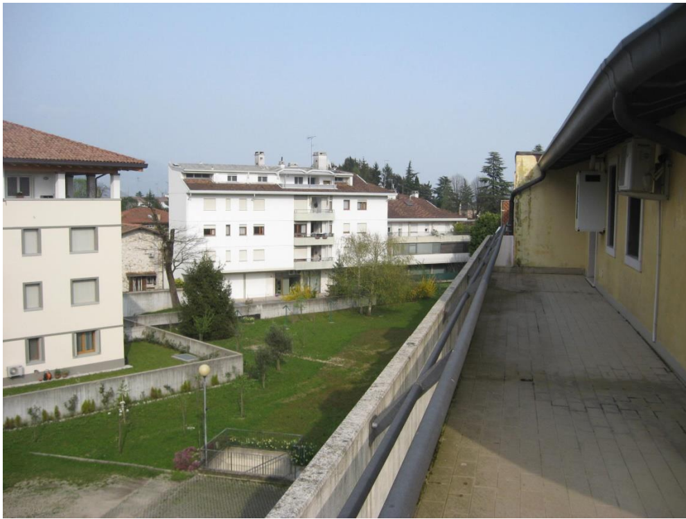
La terrazza retro con vista su corte interna
