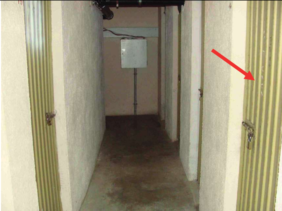
Veduta corridoio comune piano interrato
