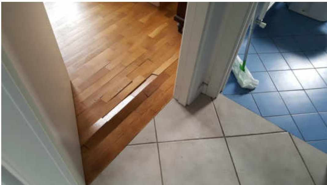
La pavimentazione della camera sub 19
