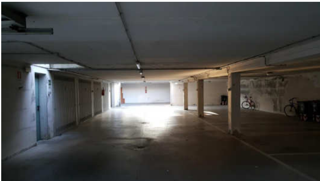
La corsia di manovra d'accesso alle autorimesse ed ai stalli
