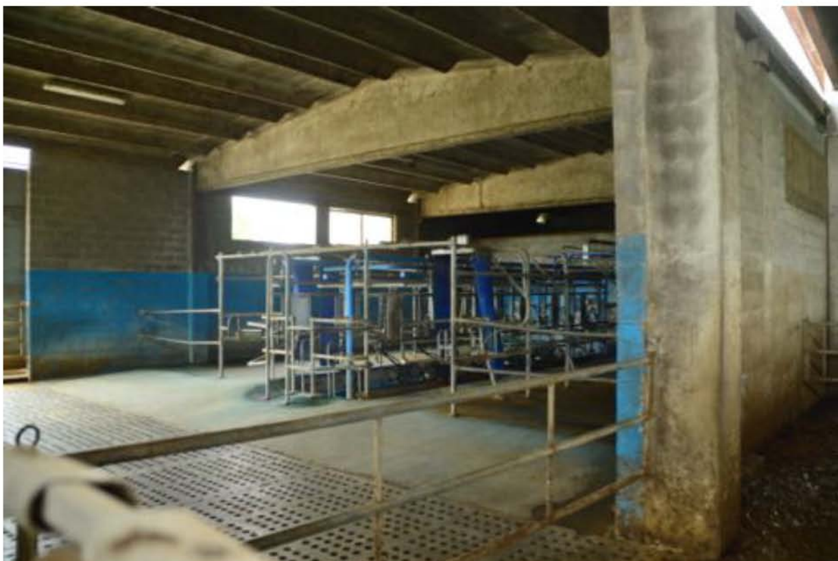
Foto 13– capriate della copertura
