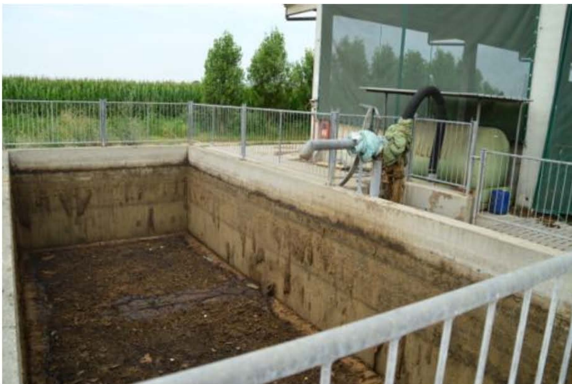
Foto 11,12 – vasche di decantazione
