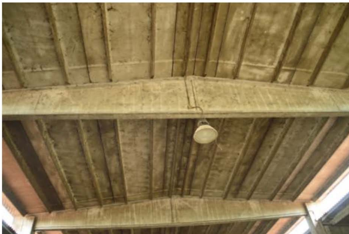
Foto 13– capriate della copertura
