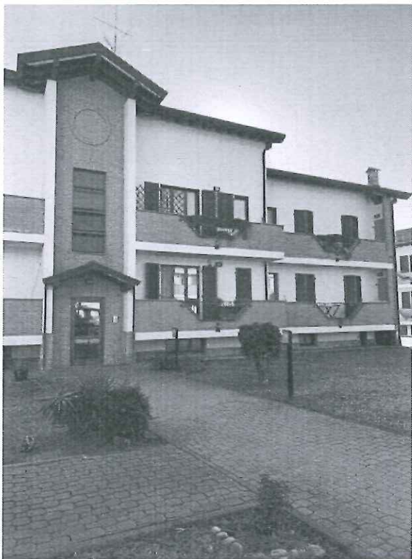
Ingresso principale Palazzina B
