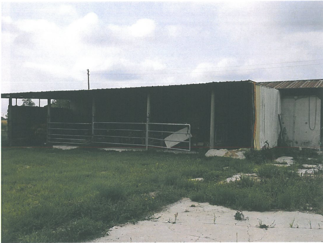
Struttura a lato silos sub 10 – da demolire
