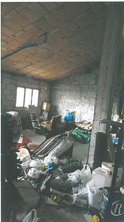
La soffitta sub 5
