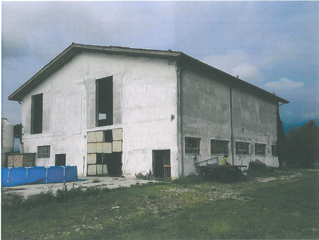
La stalla sub 9 vista da est
