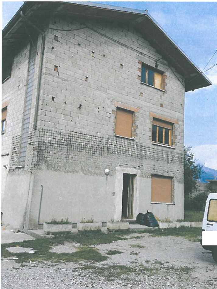
Vista nord-est fabbricato ad uso abitazione
