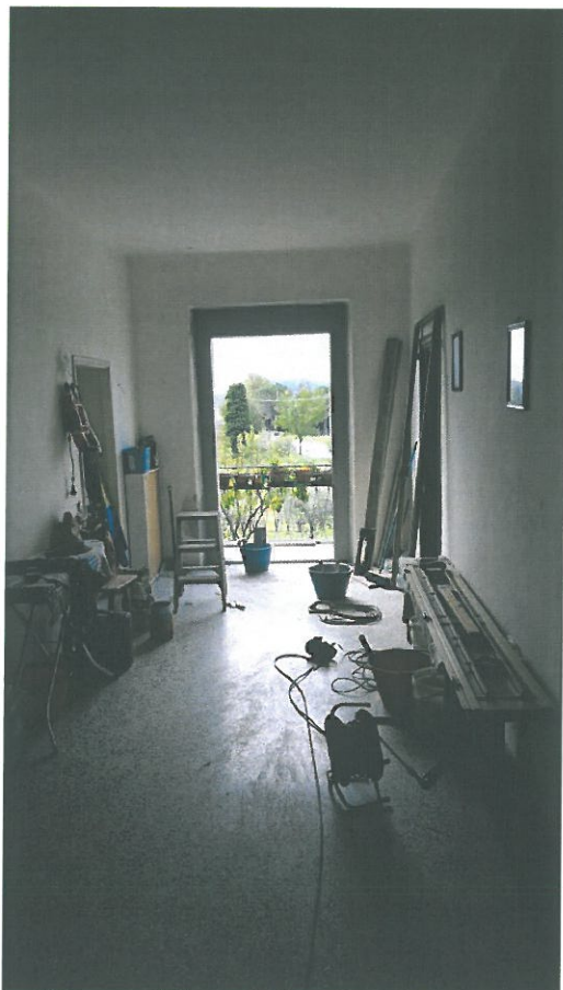
Corridoio comune al piano primo sub 4
