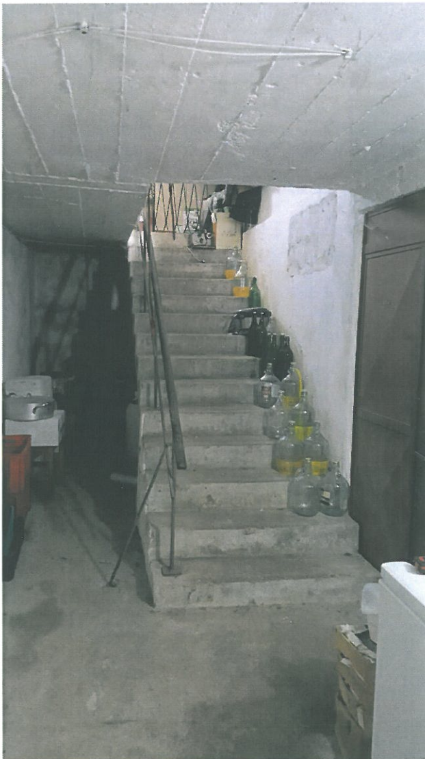
Scala comune al piano interrato sub 4
