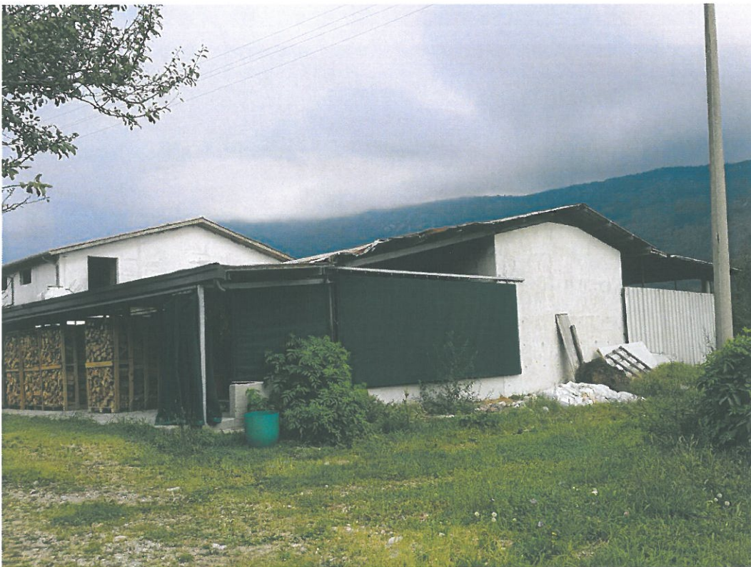
Il silos sub 10 visto da sud – gli estremi laterali sono abusivi
