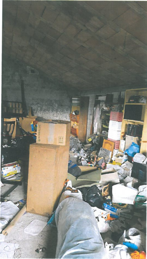
La soffitta sub 5
