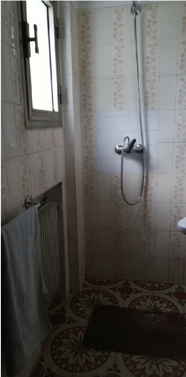
Foto 10 – bagno piano terra
