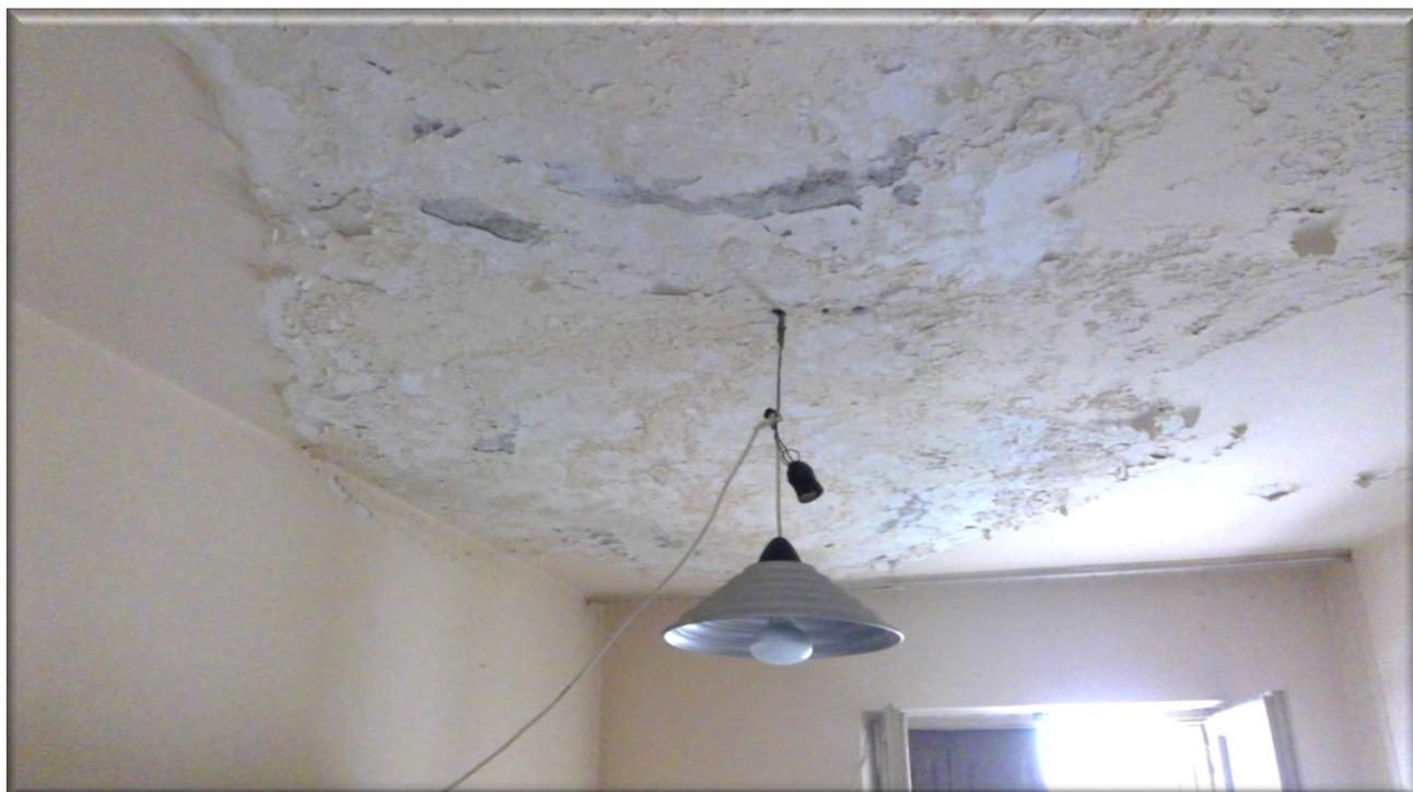
Foto n. 45 – Comune di Maniago (PN), Foglio 12, particella 88 sub 1 – Interni primo piano – Particolare dei danni da infiltrazione d’acqua al soffitto della terza camera.
