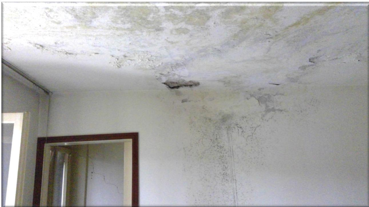
Foto n. 41 – Comune di Maniago (PN), Foglio 12, particella 88 sub 1 – Interni primo piano – Particolare dei danni da infiltrazione d'acqua al soffitto della seconda camera.
