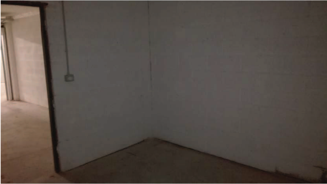
lotto 2: interno della cantina facente parte della p.m. 30
