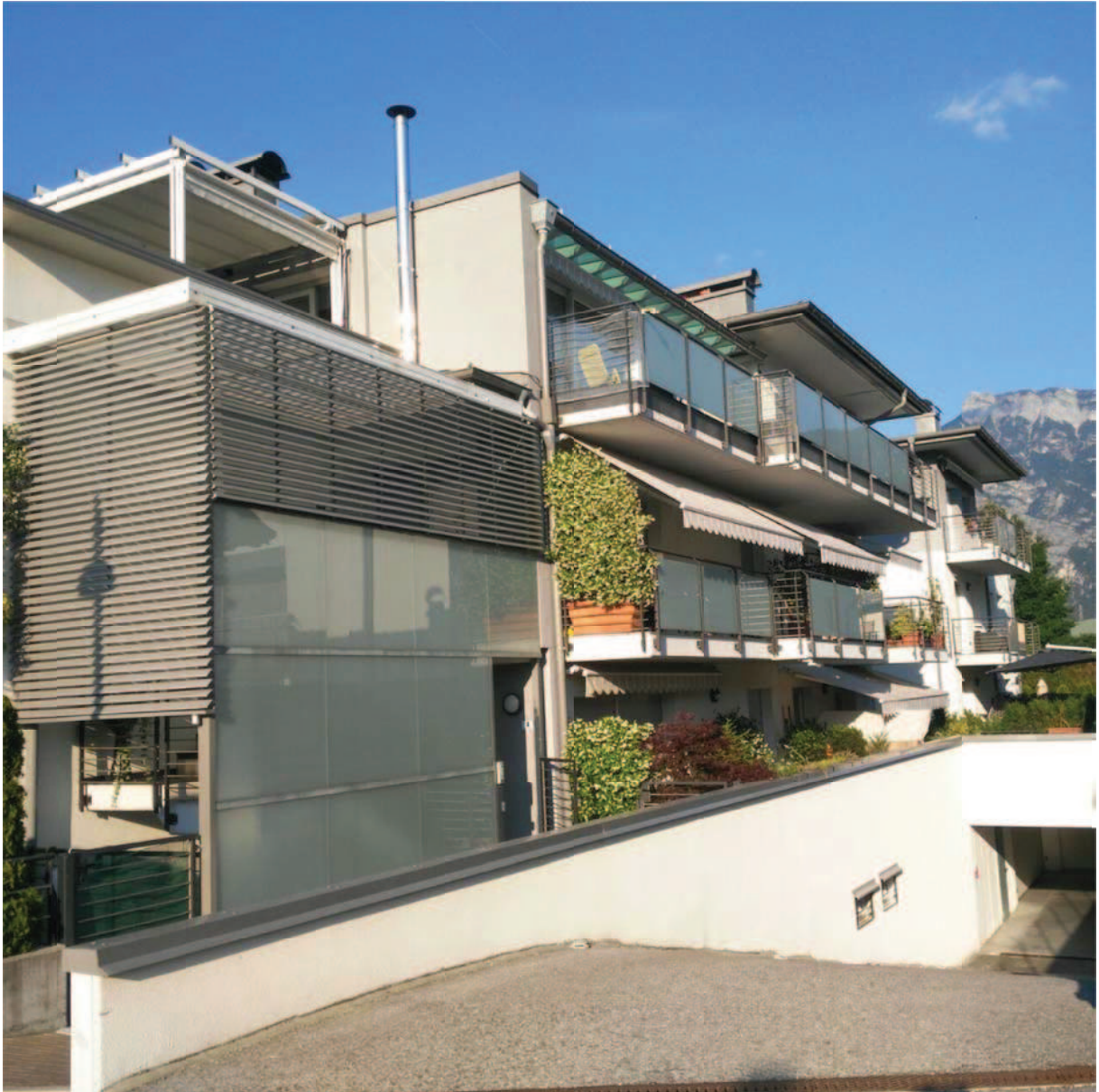
Complesso residenziale dove sono ubicati gli immobili oggetto di stima
