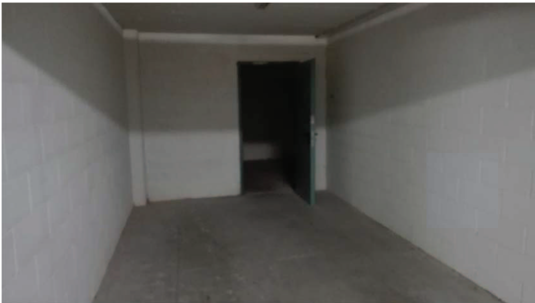
lotto 2 : interno del garage facente parte della p.m. 30
