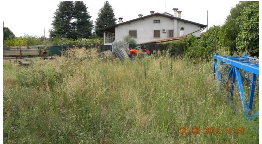
Vista edifici a confine lato nord
