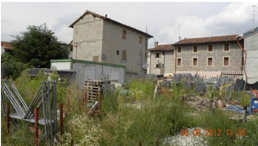
Vista edifici a confine lato nord est
